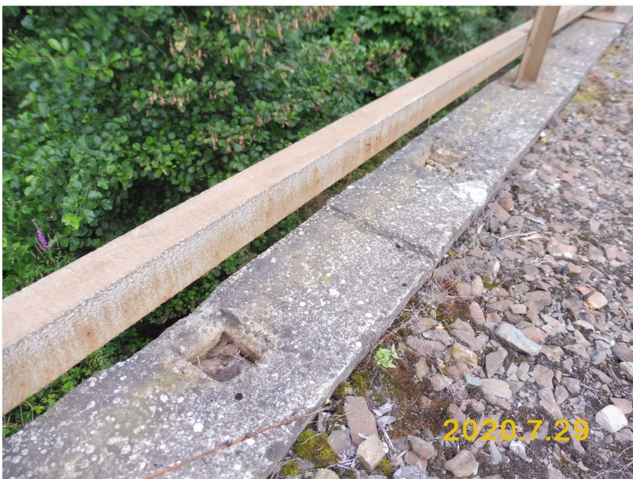
3.2-08 Levá římsa ve 2. poli - nevyplněné otvory pro uložení sloupků zábradlí
