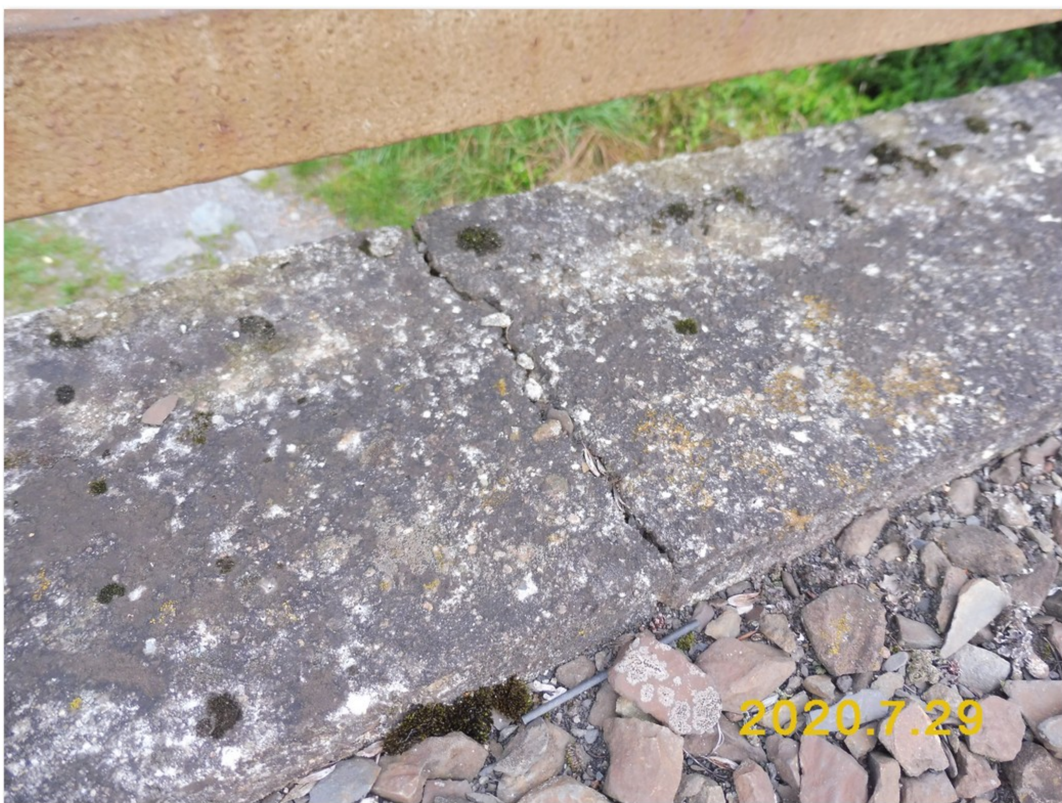
3.2-05 Trhlina v levé římse na konci nosné konstrukce K01 nad opěrou 1
