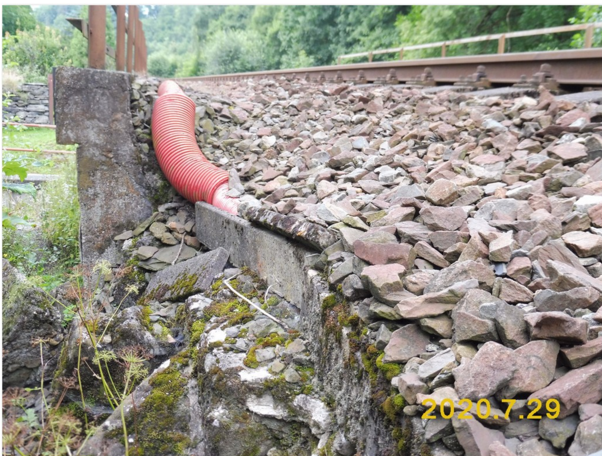
4.2-05 Přejít kabelového žlabu z mostu do násypu vpravo za opěrou 3 - na konci křídla nekrytá chránička
