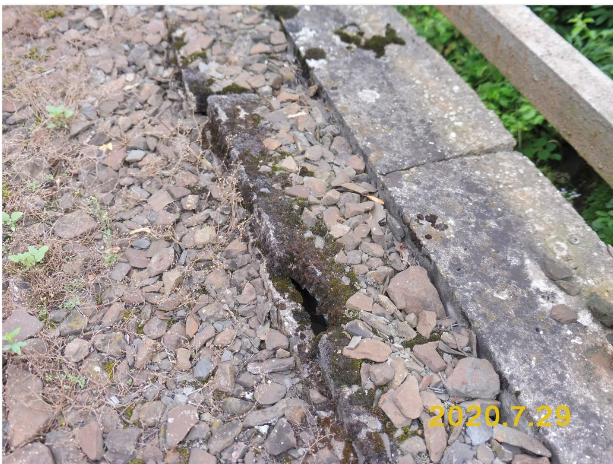
4.2-03 Kabelový žlab podél pravé římsy ve 2. poli - poškozená krycí deska
