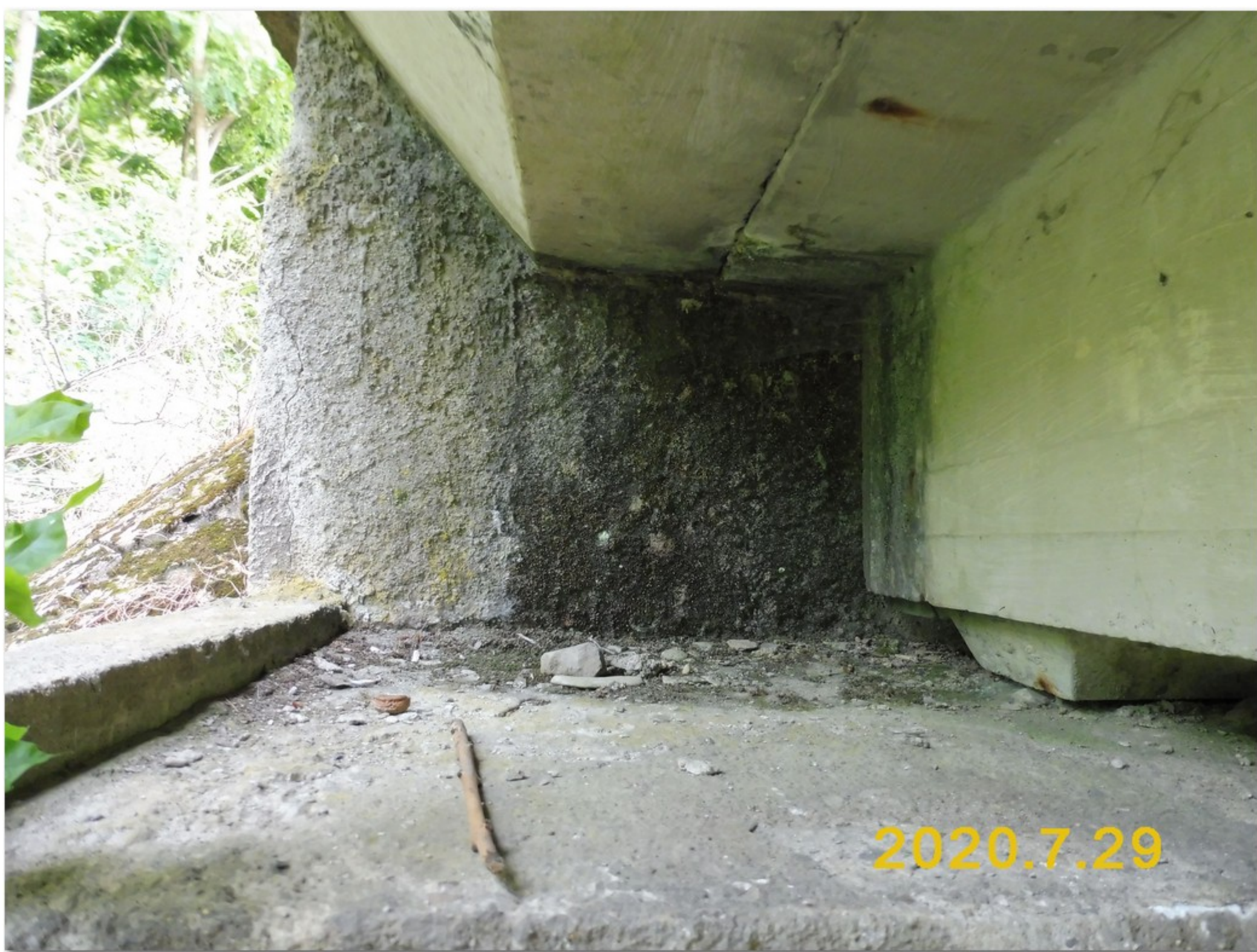
1.2-56 Líc závěrné zídky u levého čela opěry 3 se stopami dlouhodobého zatékání
