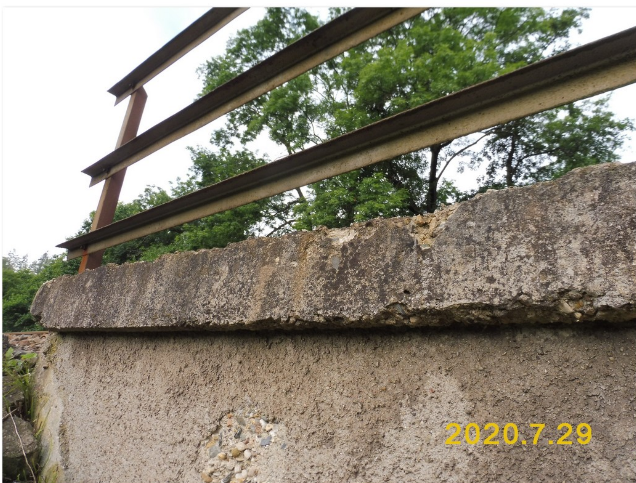
3.2-32 Pohledová plocha pravé římsy na křídle opěry 1
