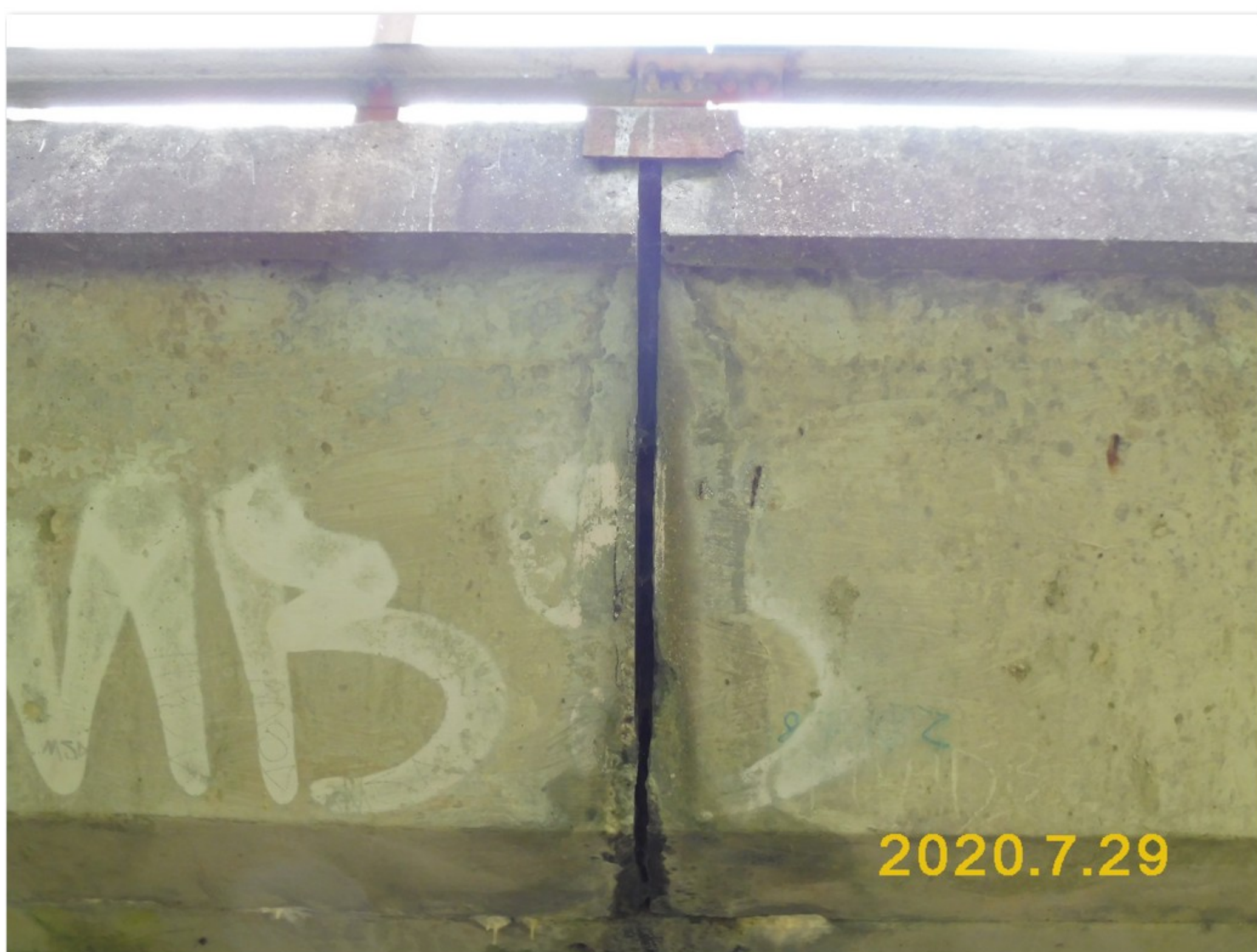
2.1-29 Dilatační spára v levé římsové konzole se stopami zatékání - v době prohlídky mokré
