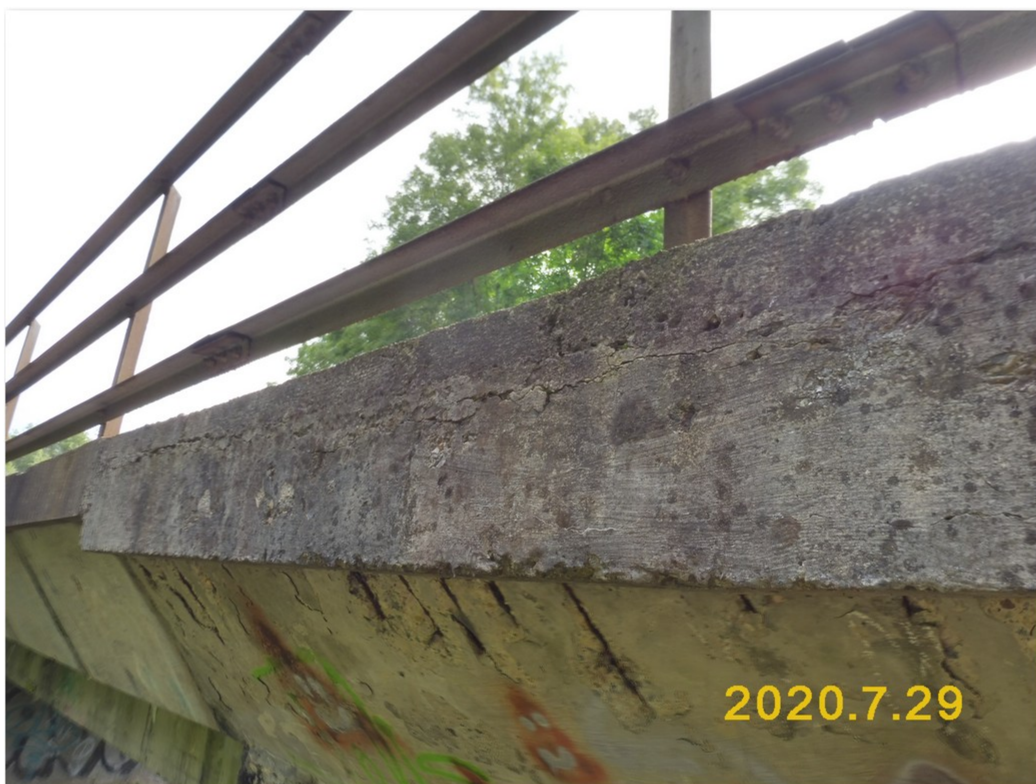
3.2-13 Pohledová plocha levé římsy v 1. poli - trhliny
