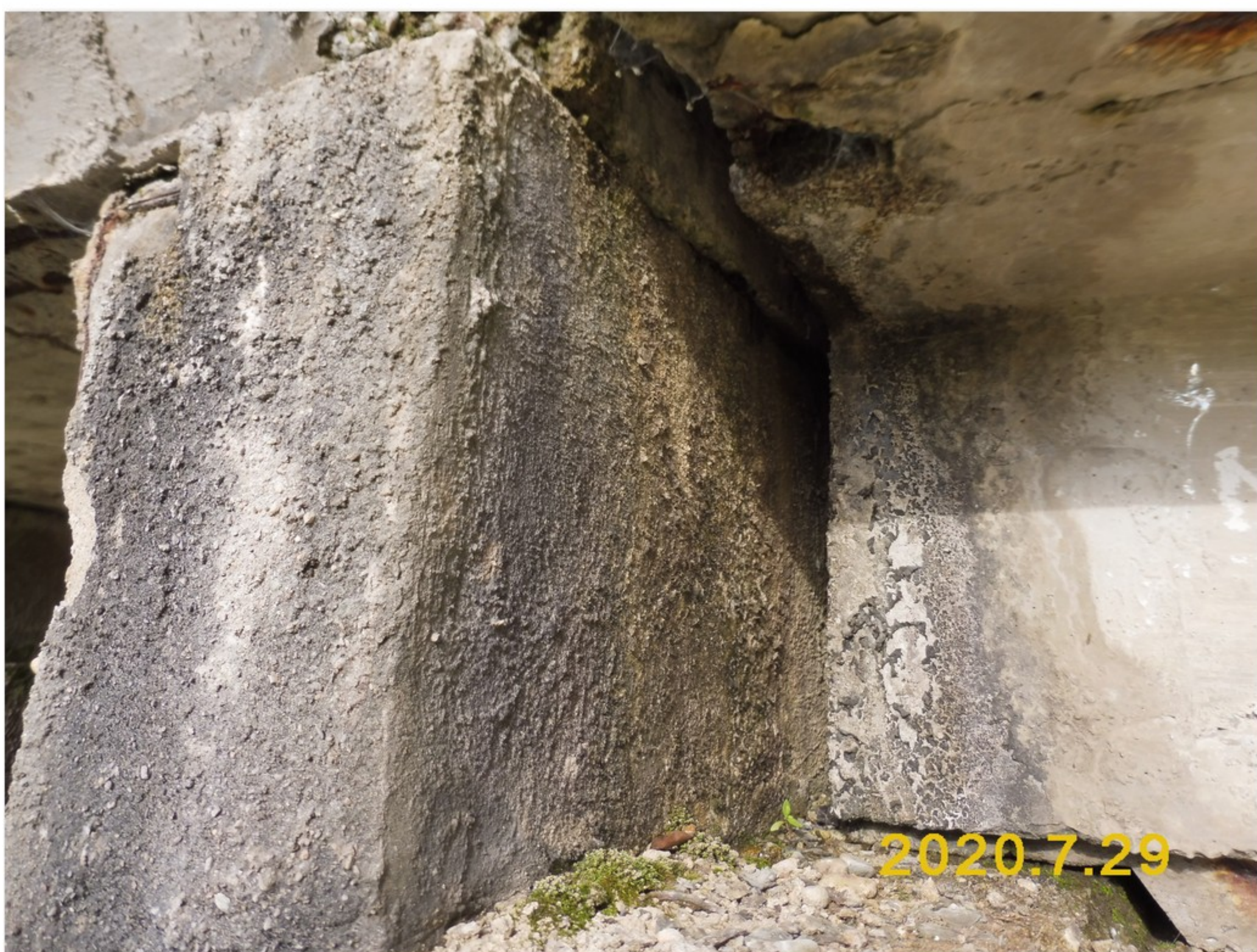
1.2-38 Líc závěrné zídky u pravého čela podpěry 2 se stopami dlouhodobého zatékání
