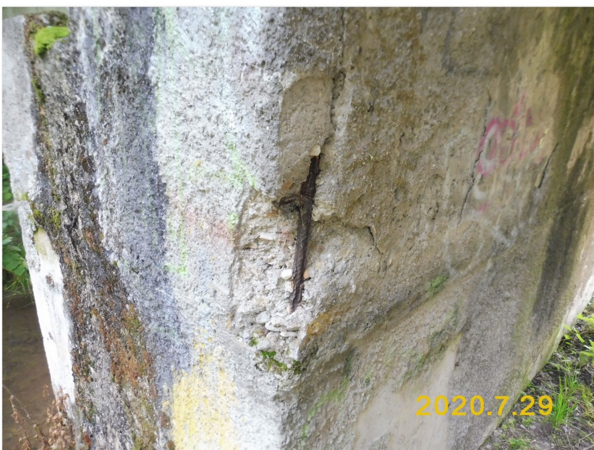
1.2-30 Levý roh podpěry 2 v 1. poli - koroze výztuže - beton odlomený působením korozních zplodin
