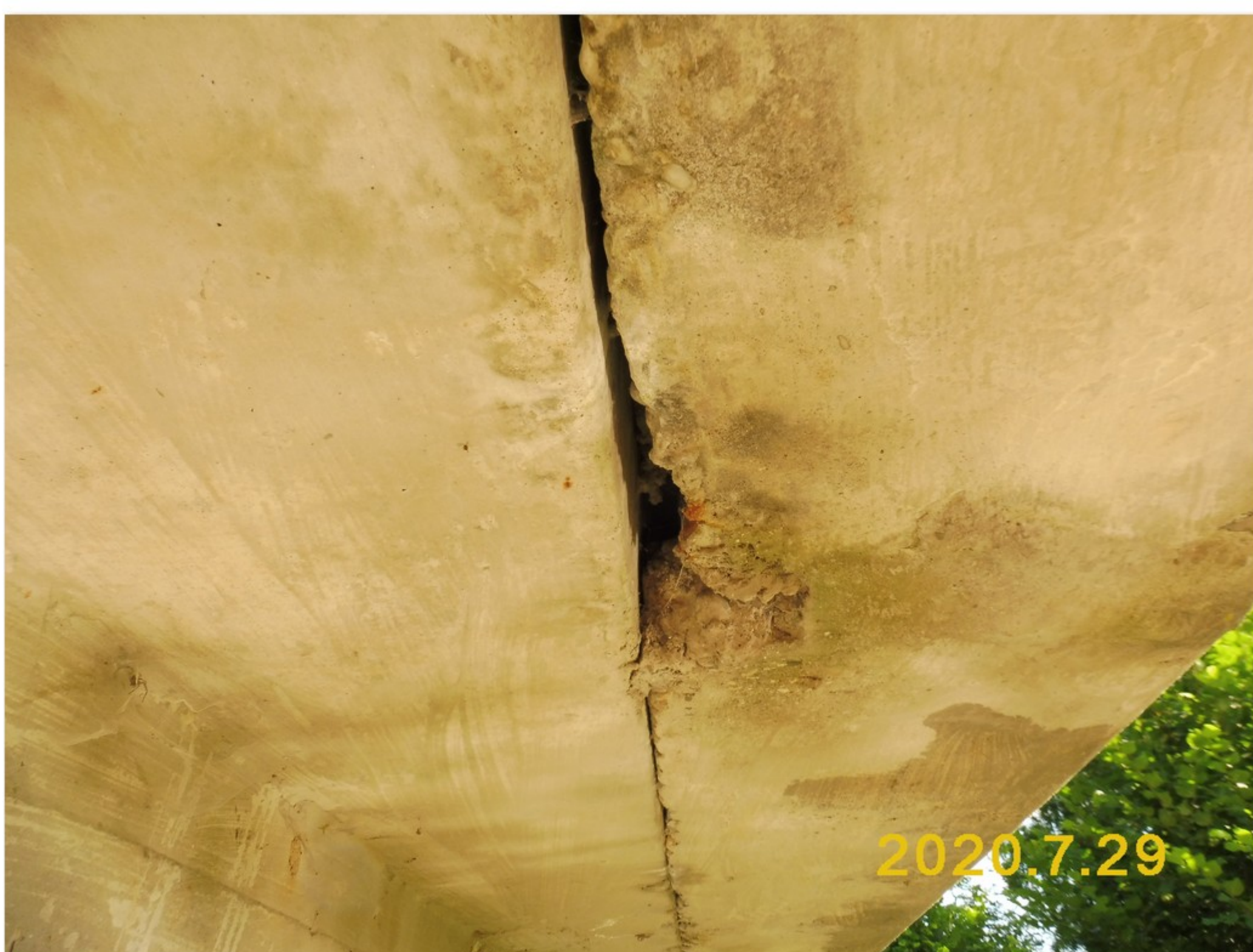
2.1-62 Degradace betonu na podhledu pravé římsové konzoly před pilířem 2
