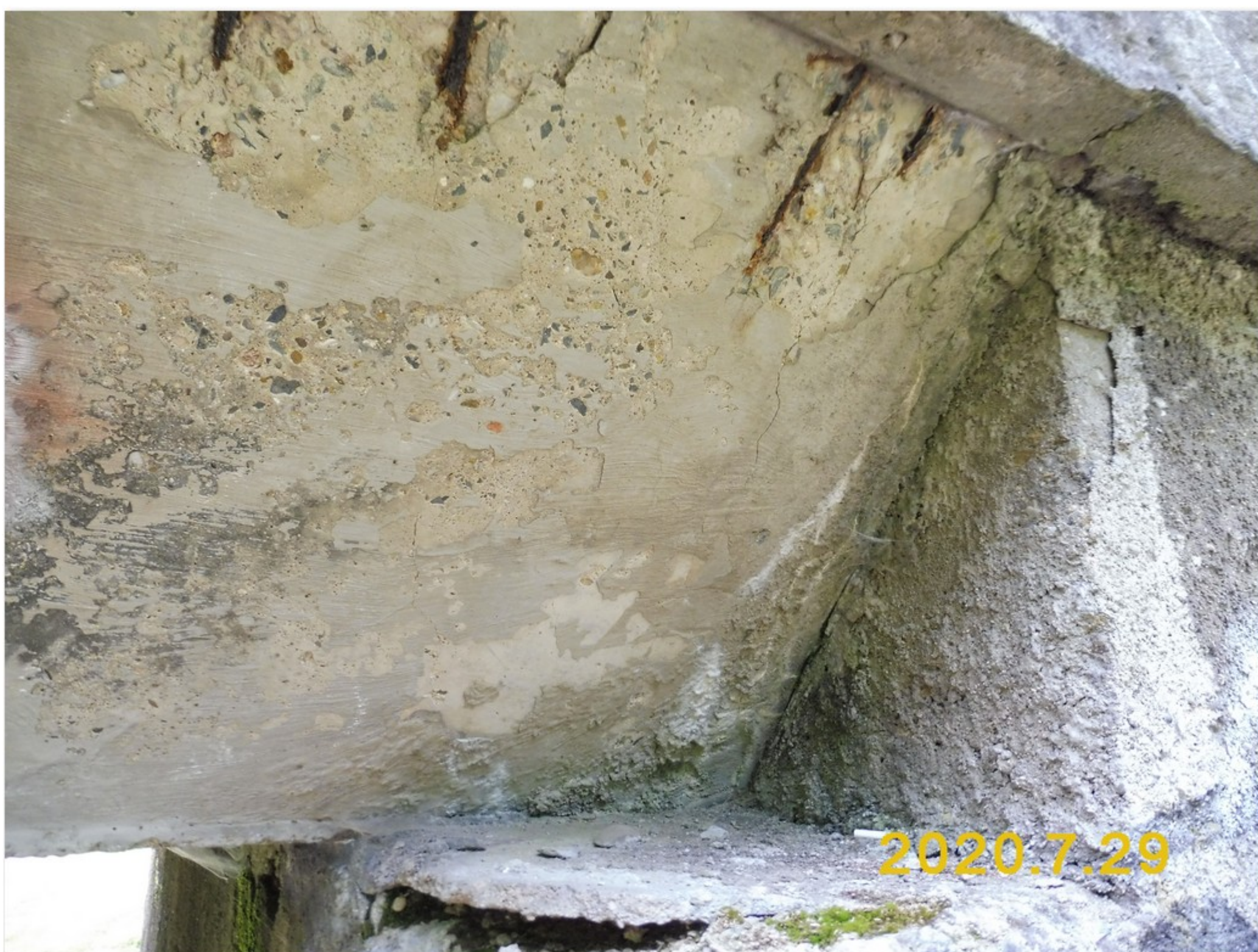
2.1-14 Uložení nosné konstrukce K01 na opěře 1 vlevo - na boku trhliny se stopami pronikající vody a výluhy
