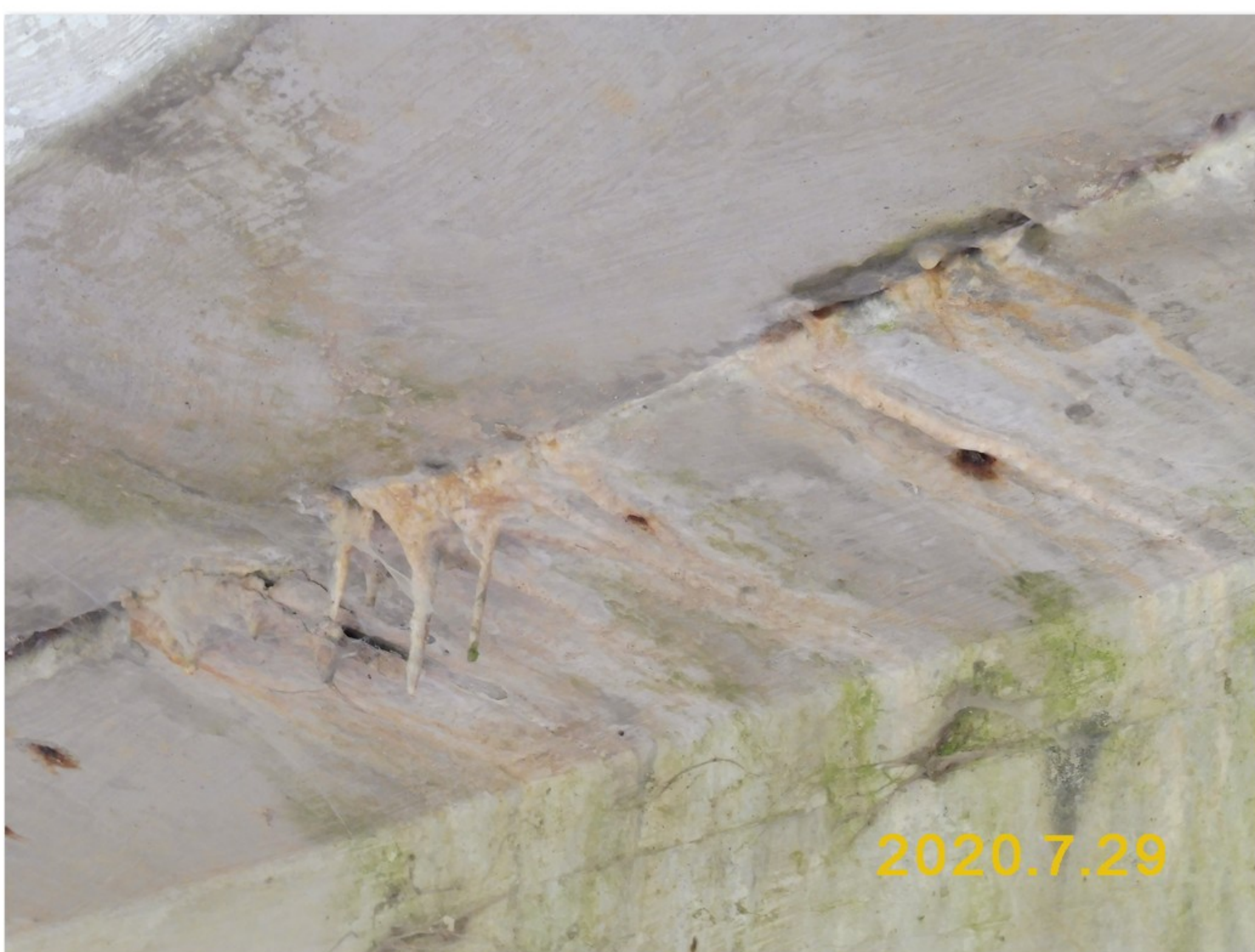
2.1-27 Podélná spára mezi nosníkem č. 02.1 a římsovou konzolou - zatékání - výluhy - krápníky
