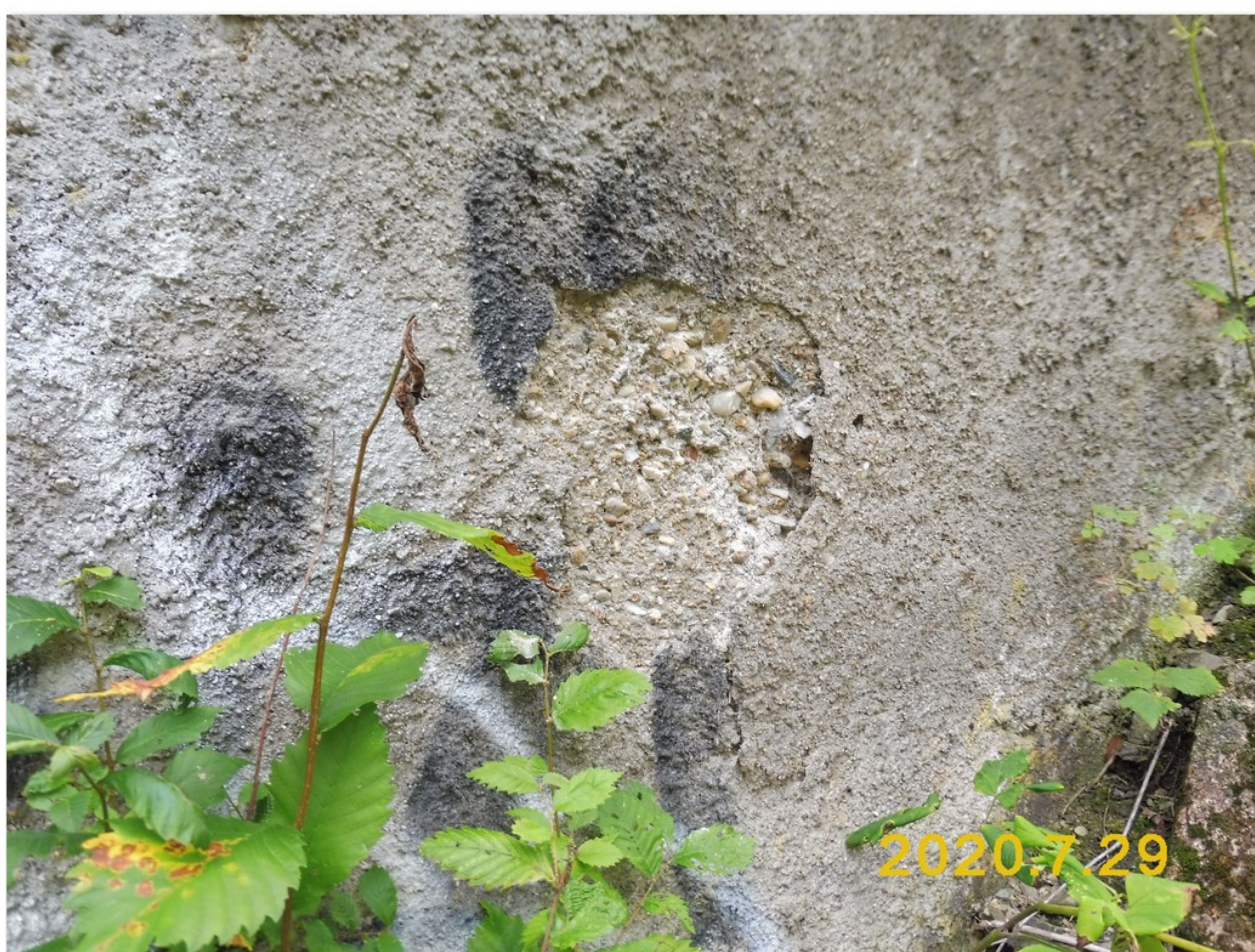
1.2-05 Levé křídlo opěry 1 - odpadnutá omítka - degradace betonu
