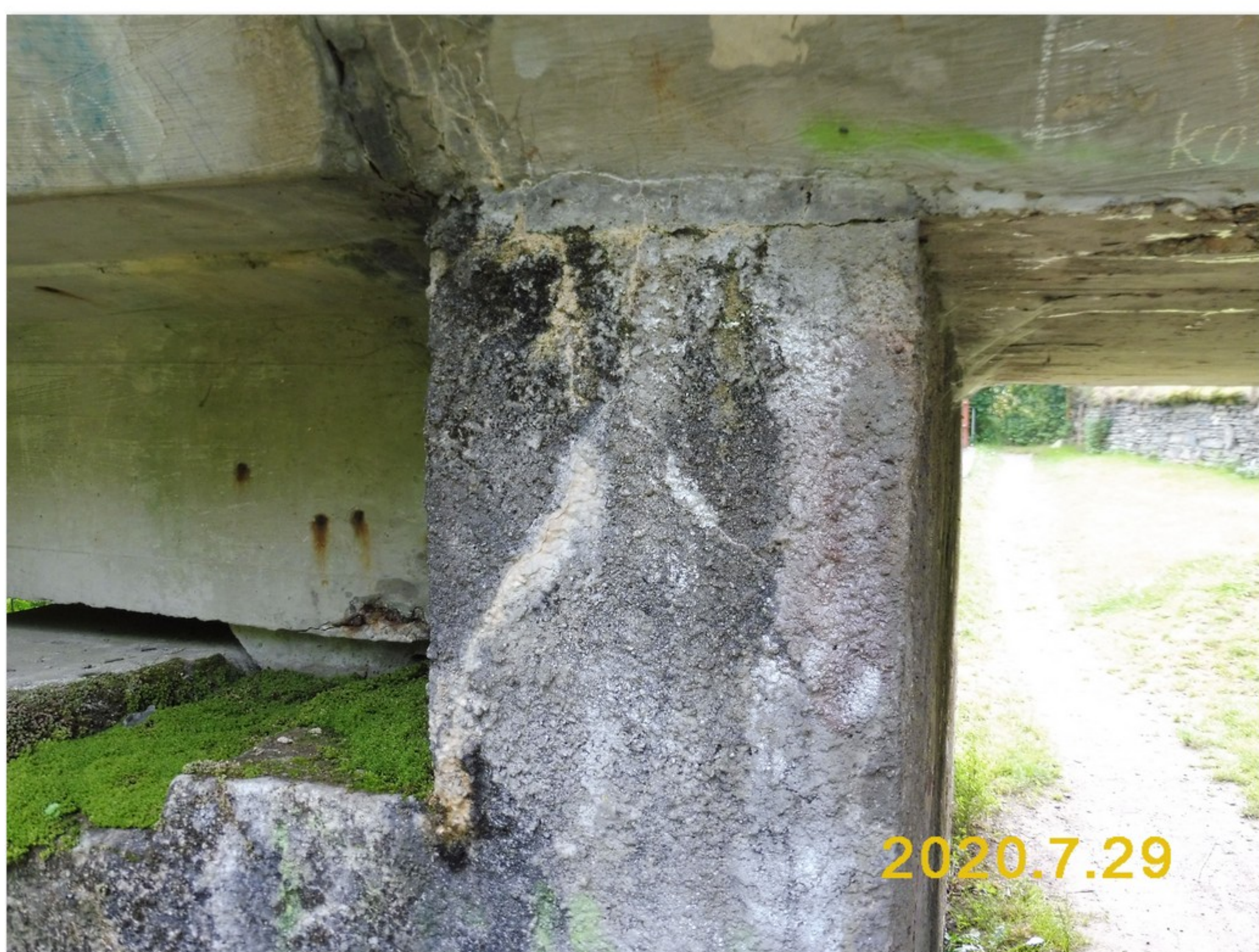
1.2-26 Závěrná zídka na levém čele podpěry 2 - trhliny s průsaky a inkrustacemi
