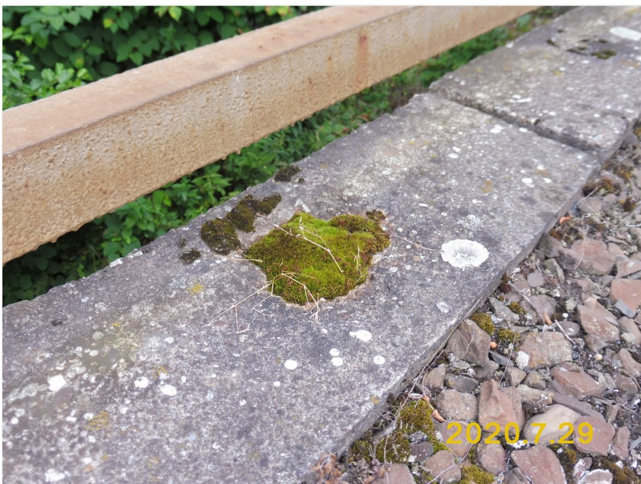
3.2-10 Levá římsa ve 2. poli - v nevyplněném otvoru pro uložení sloupku zábradlí uchycená vegetace
