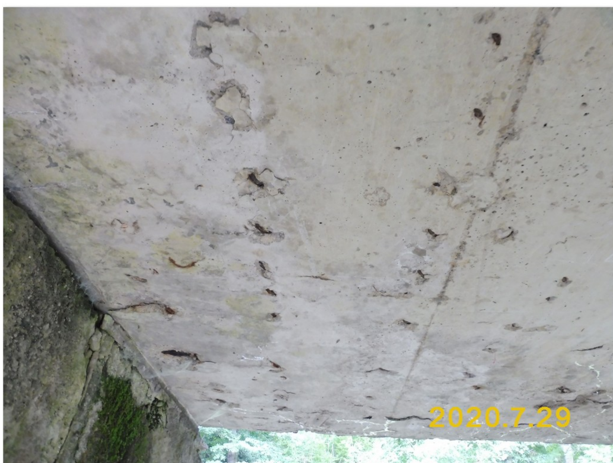
2.1-05 Podhled nosné konstrukce K01 před pilířem 2 - beton odlomený působením korozních zplodin v místě spon
