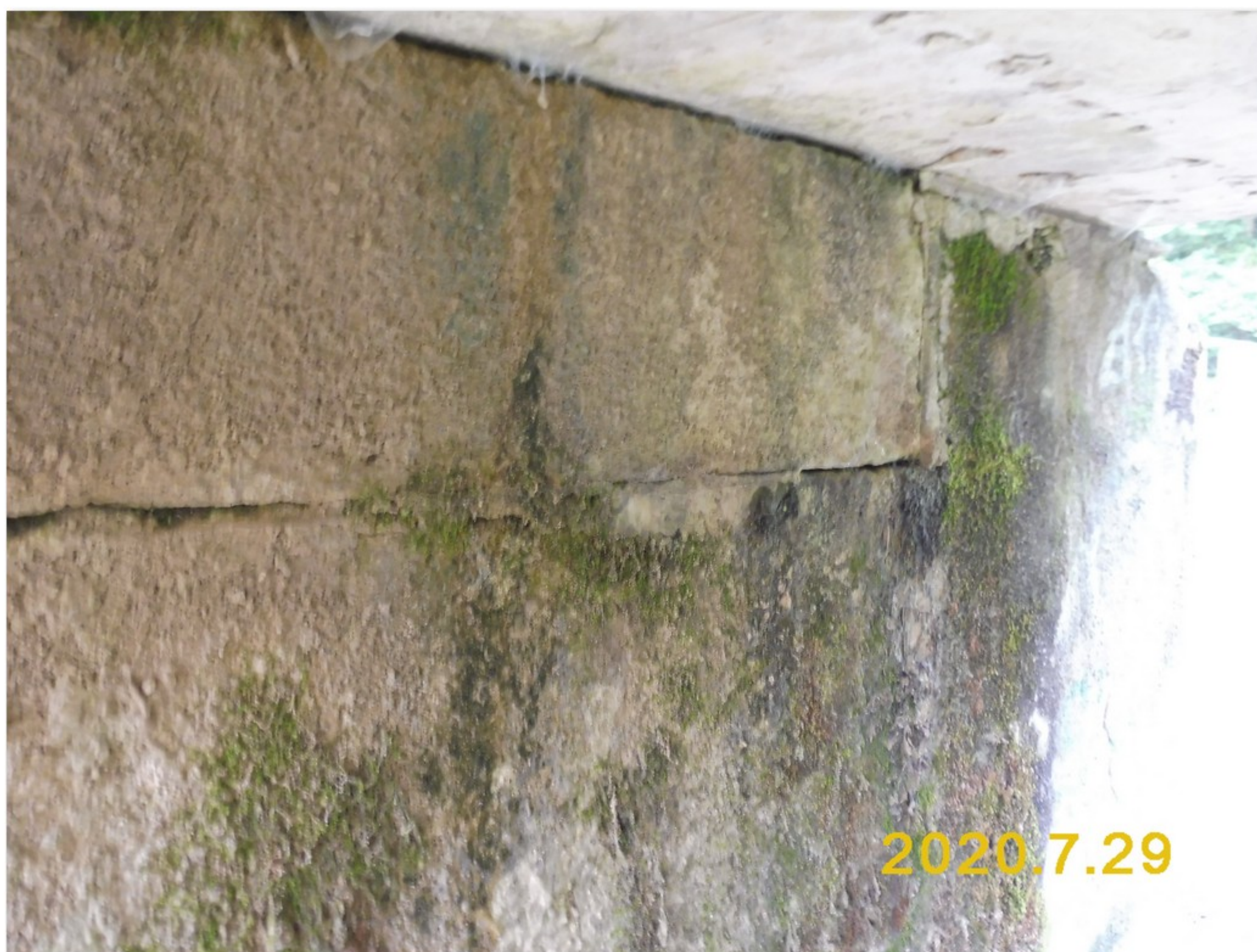
1.2-08 Detail líce opěry 1 - otevřené spáry mezi prefabrikovanou a monolitickou částí
