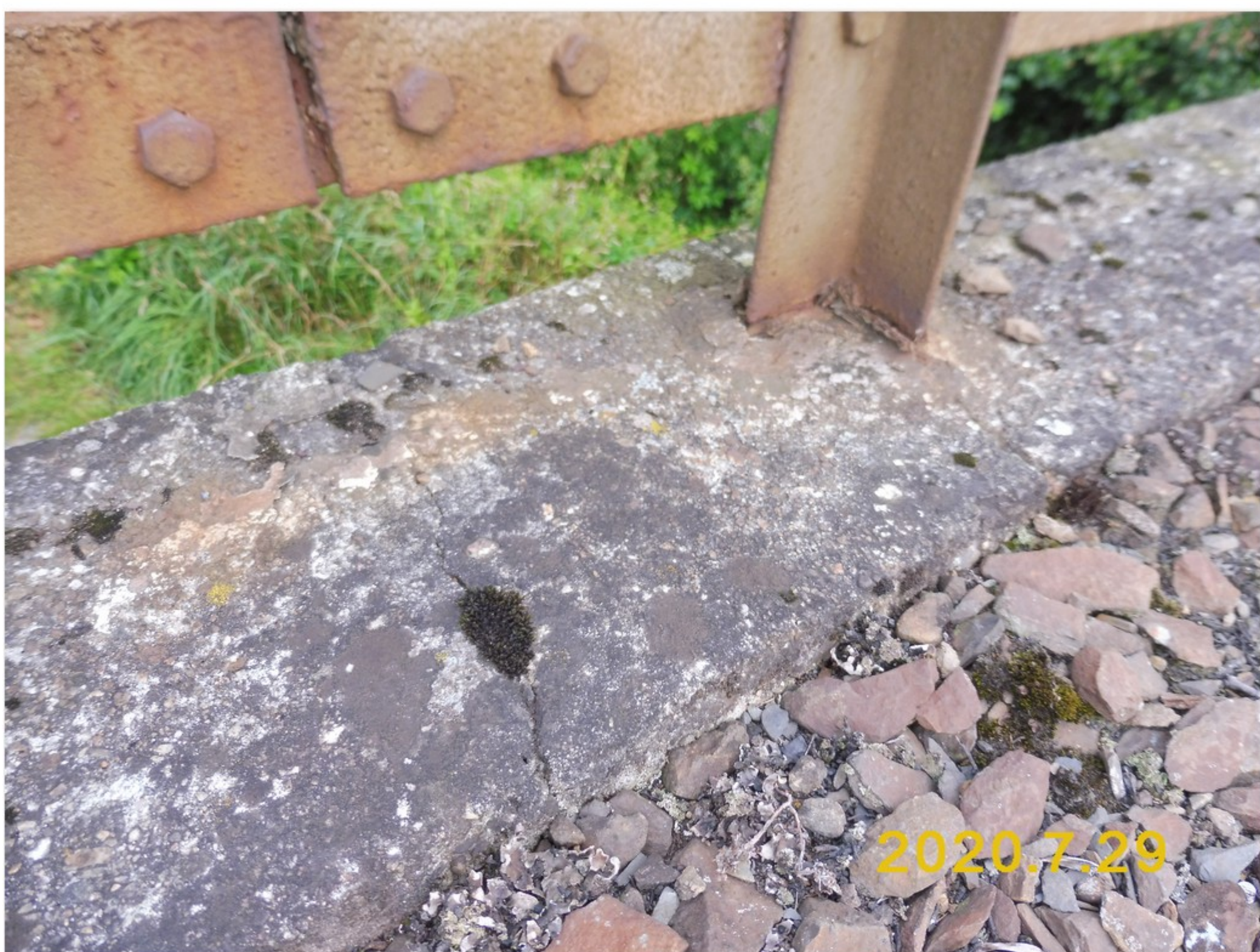
3.2-06 Povrch levé římsy v 1. poli - trhliny - uchycená vegetace
