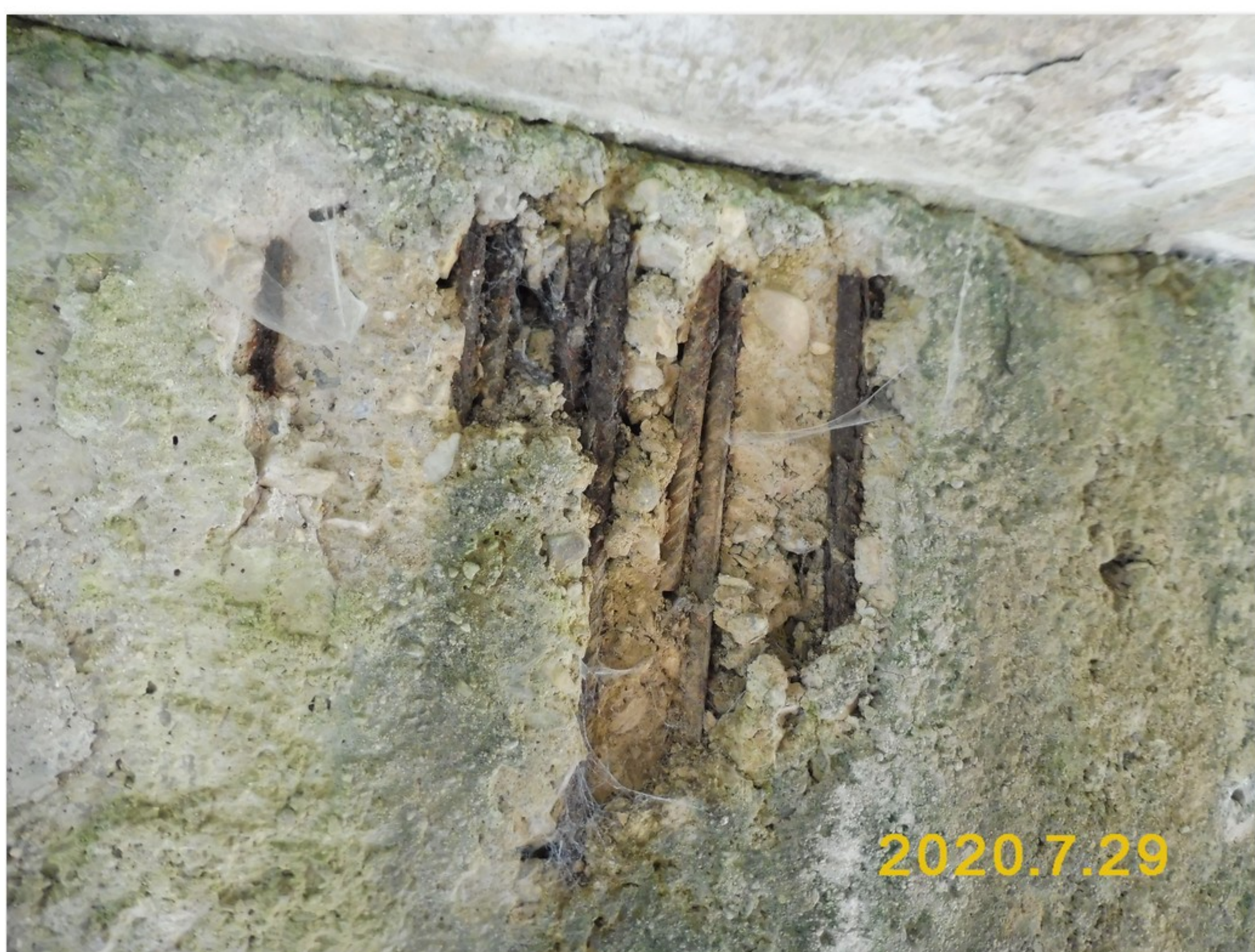
1.2-32 Líc podpěry 2 v 1. poli - koroze výztuže s nedostatečným krytím - beton odlomený působením korozních zplodin
