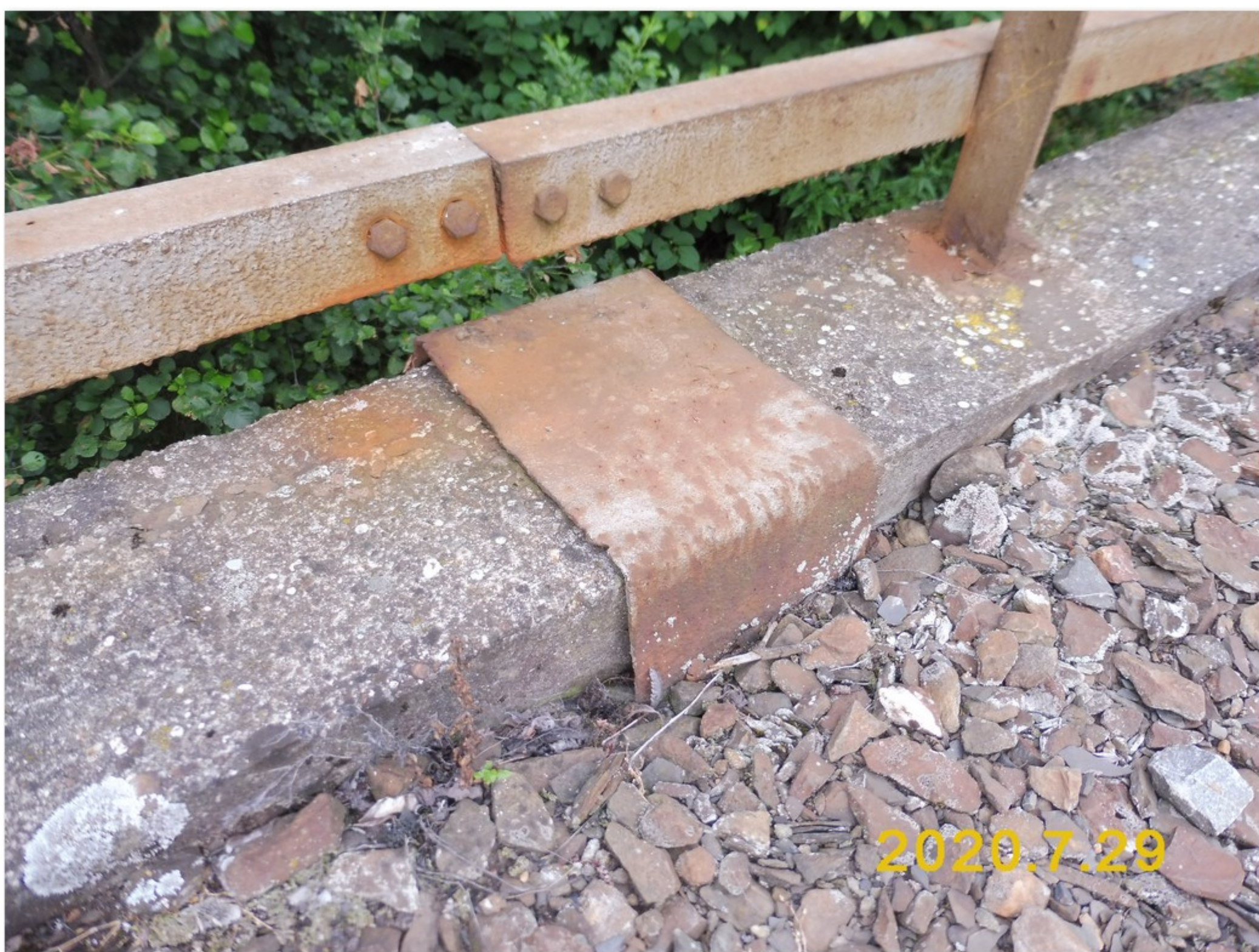
3.2-09 Zakrytí dilatační spáry levé římsy uprostřed rozpětí 2. pole
