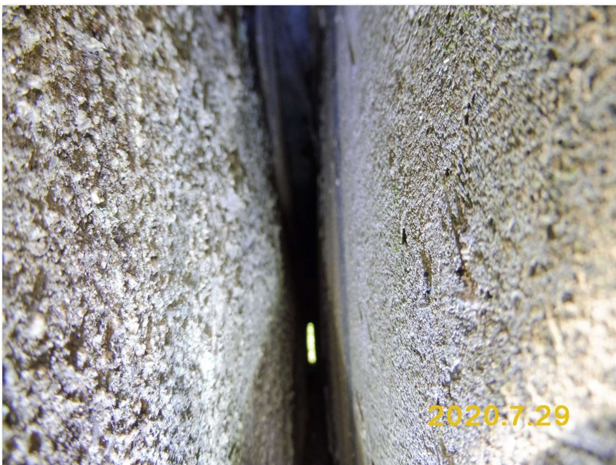
2.1-59 Čelo nosníku č. 02.2 a líc závěrné zídky pilíře 2 - pohled zprava
