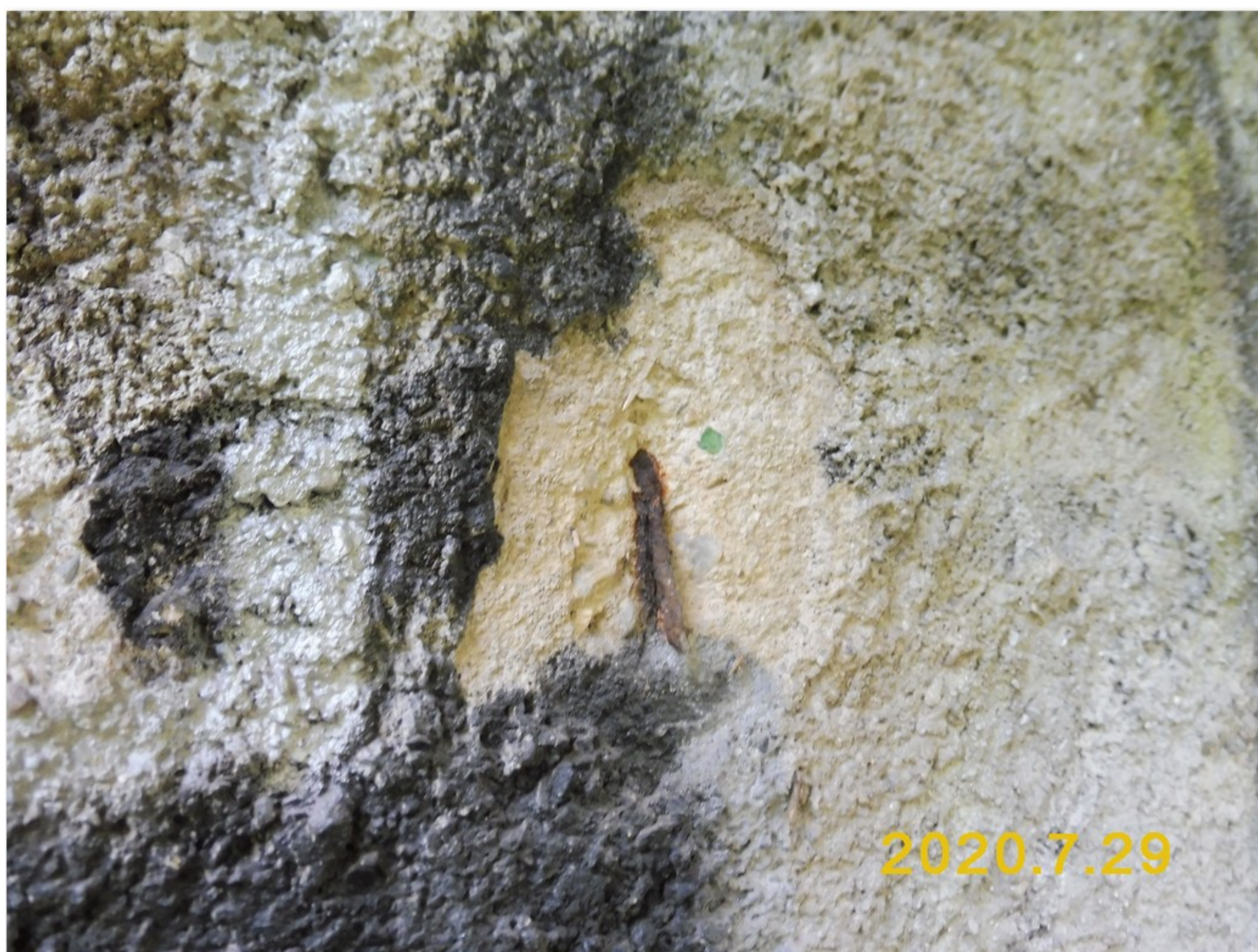
1.2-58 Líc opěry 3 - obnažená korodující výztuž - beton odlomený působením korozních zplodin
