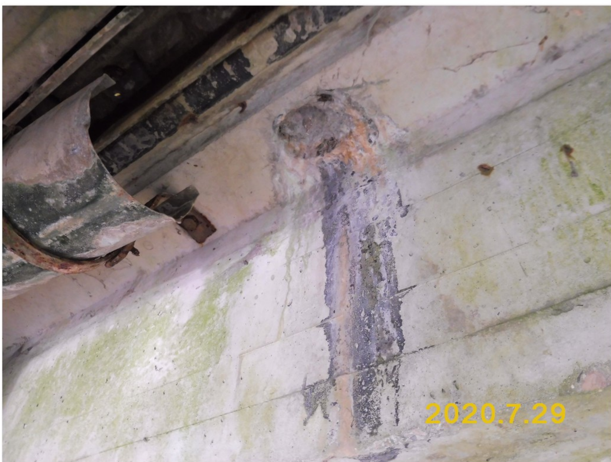
2.1-39 Zatékání přes montážní otvor v pravé horní přírubě nosníku č. 02.1 před pilířem 2
