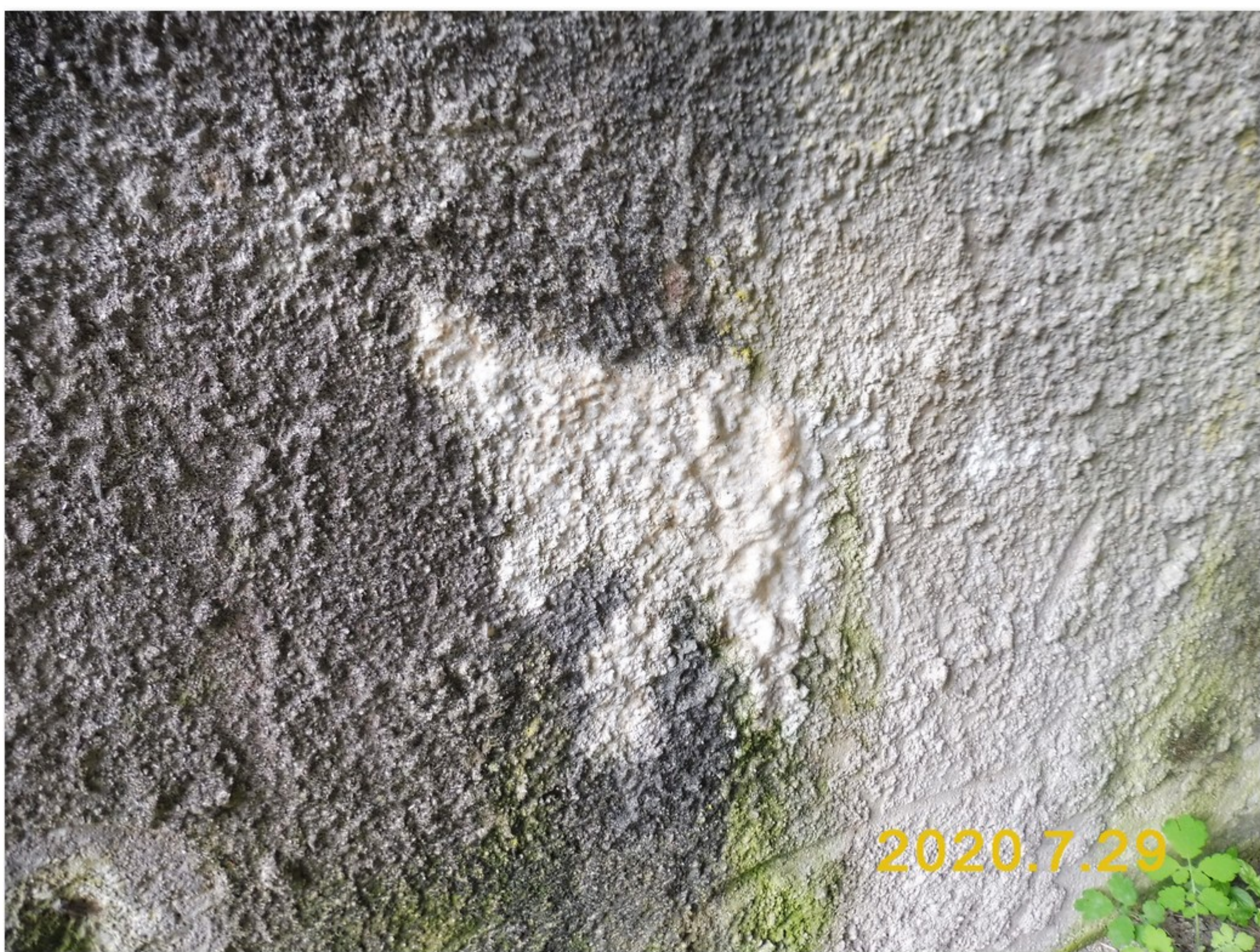
1.2-10 Líc opěry 1 - inkrustace v místě prosakování přes trhlinu
