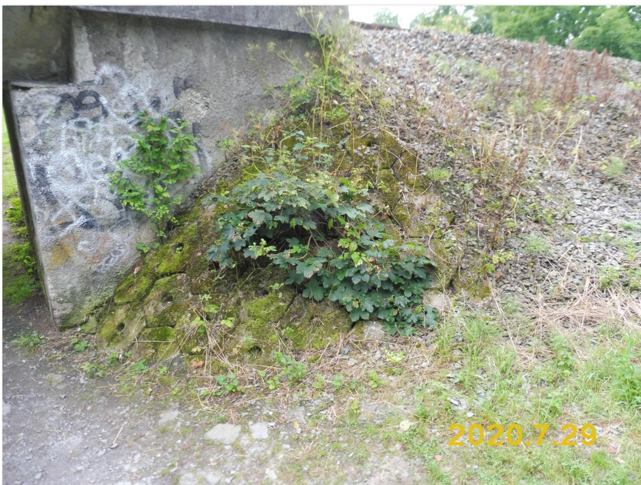
1.3-01 Svahový kužel u levého křídla opěry 1
