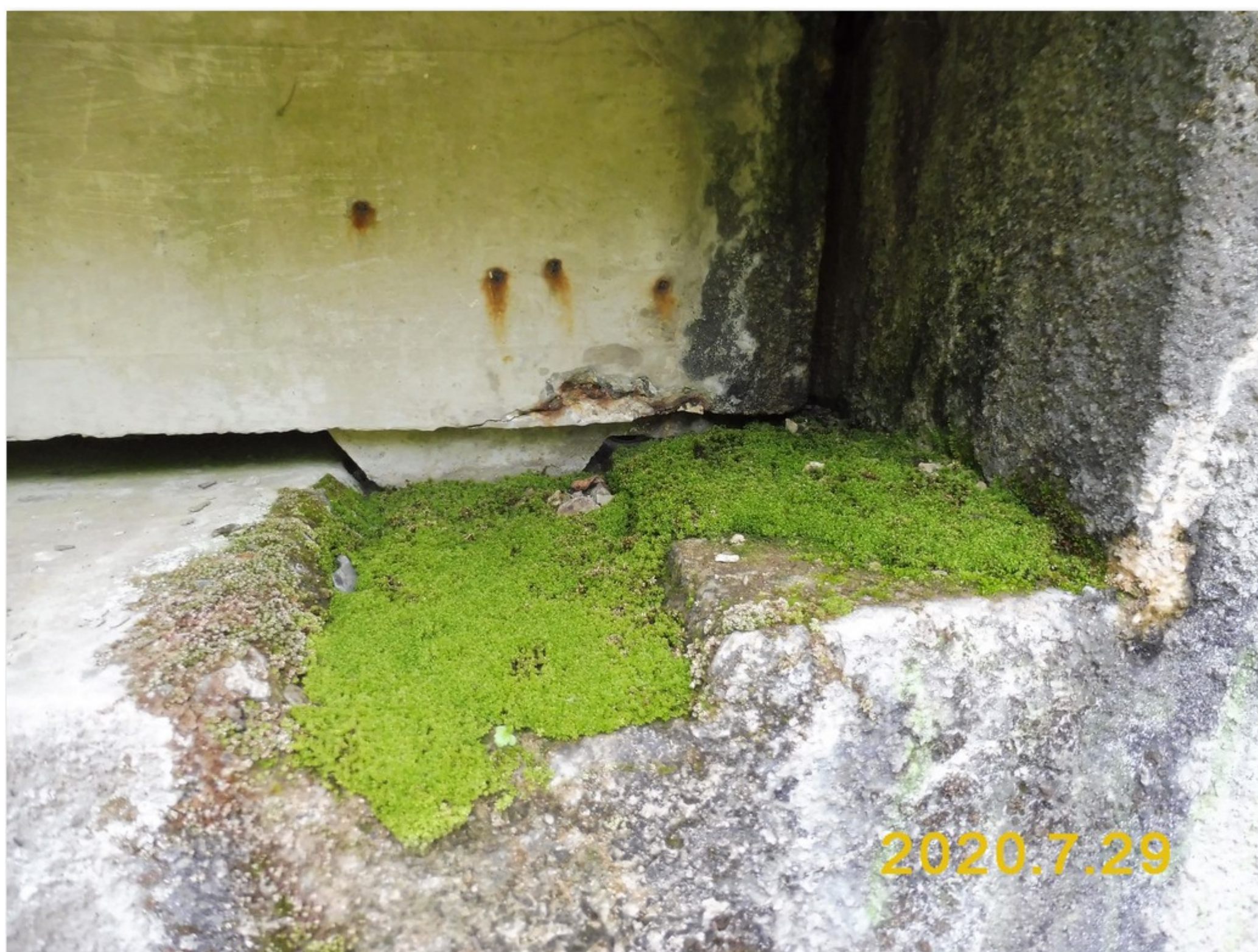
1.2-27 Vegetace rostoucí na úložném prahu u levého čela podpěry 2
