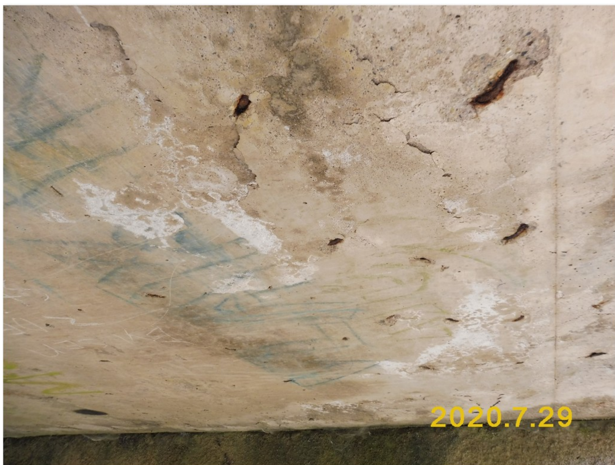
2.1-10 Podhled nosné konstrukce K01 - známky zatékání - výluhy
