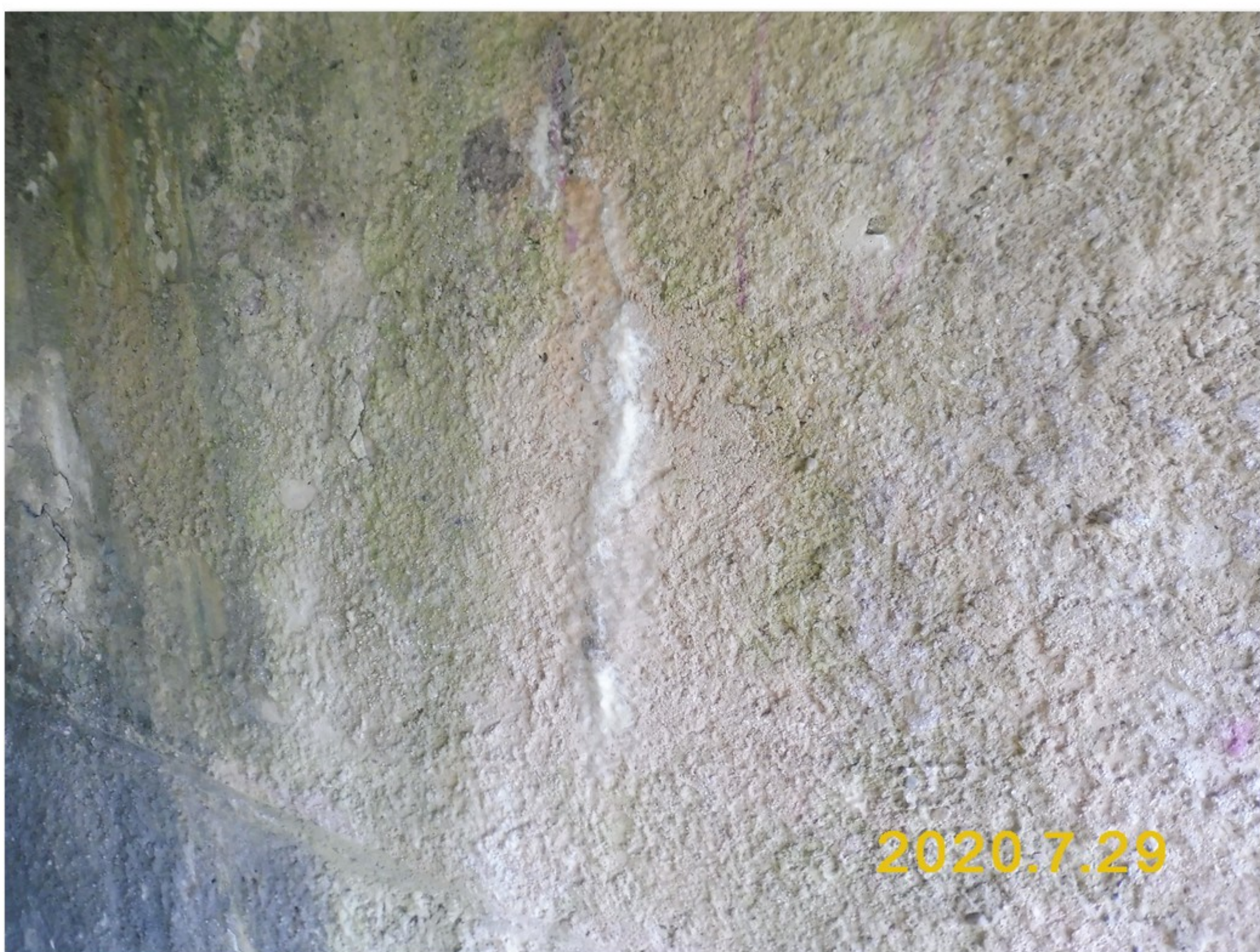
1.2-34 Trhliny s průsaky a inkrustacemi v líci podpěry 2 v 1. poli
