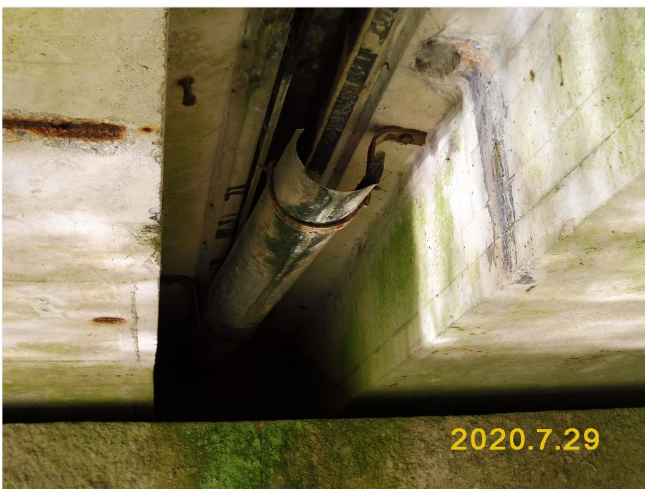
3.4-01 Odvodňovací žlab mezi nosníky nad podpěrou 2
