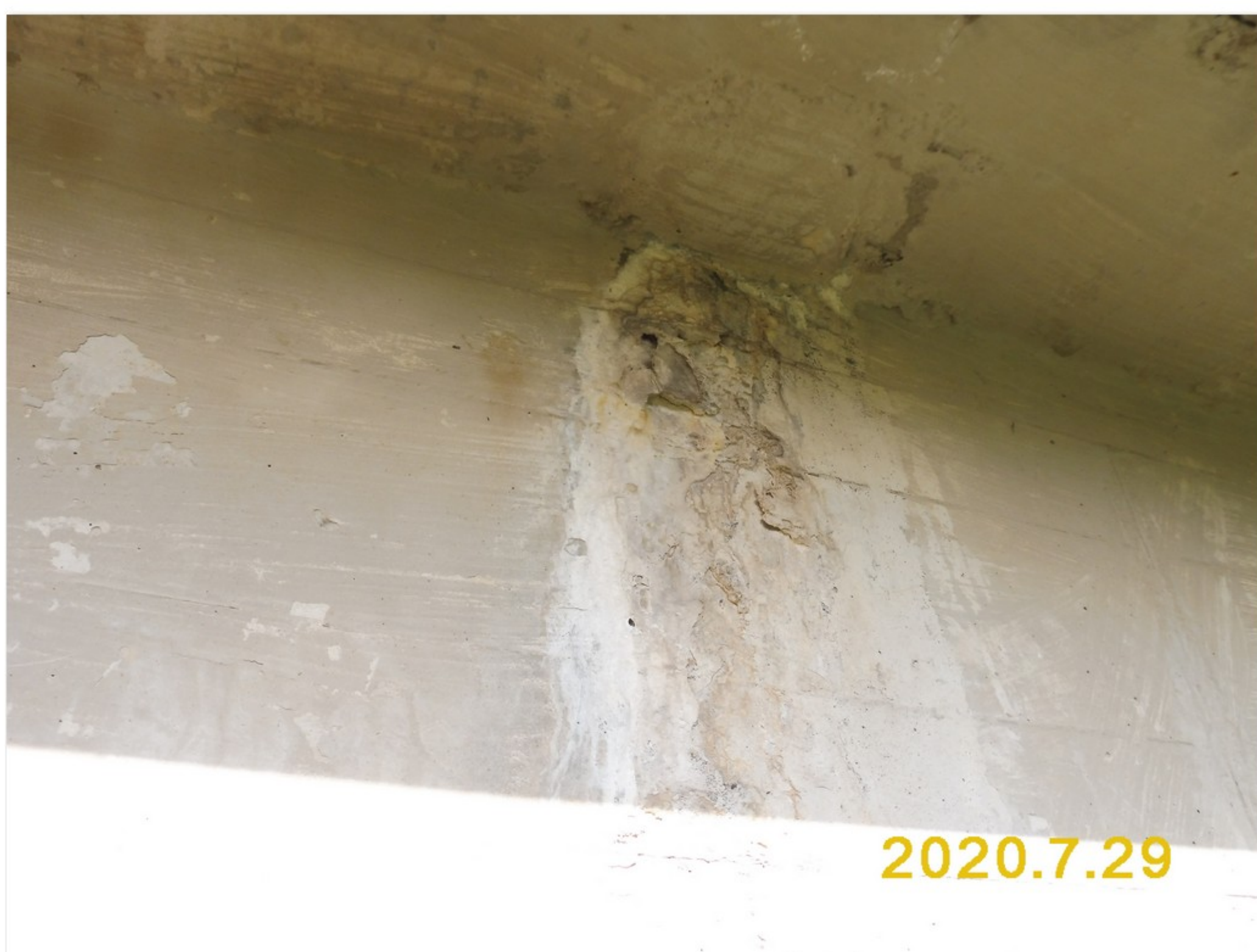
2.1-64 Stopy zatékání mezi pravou stěnou a horní přírubou nosníku č. 02.2 - inkrustace
