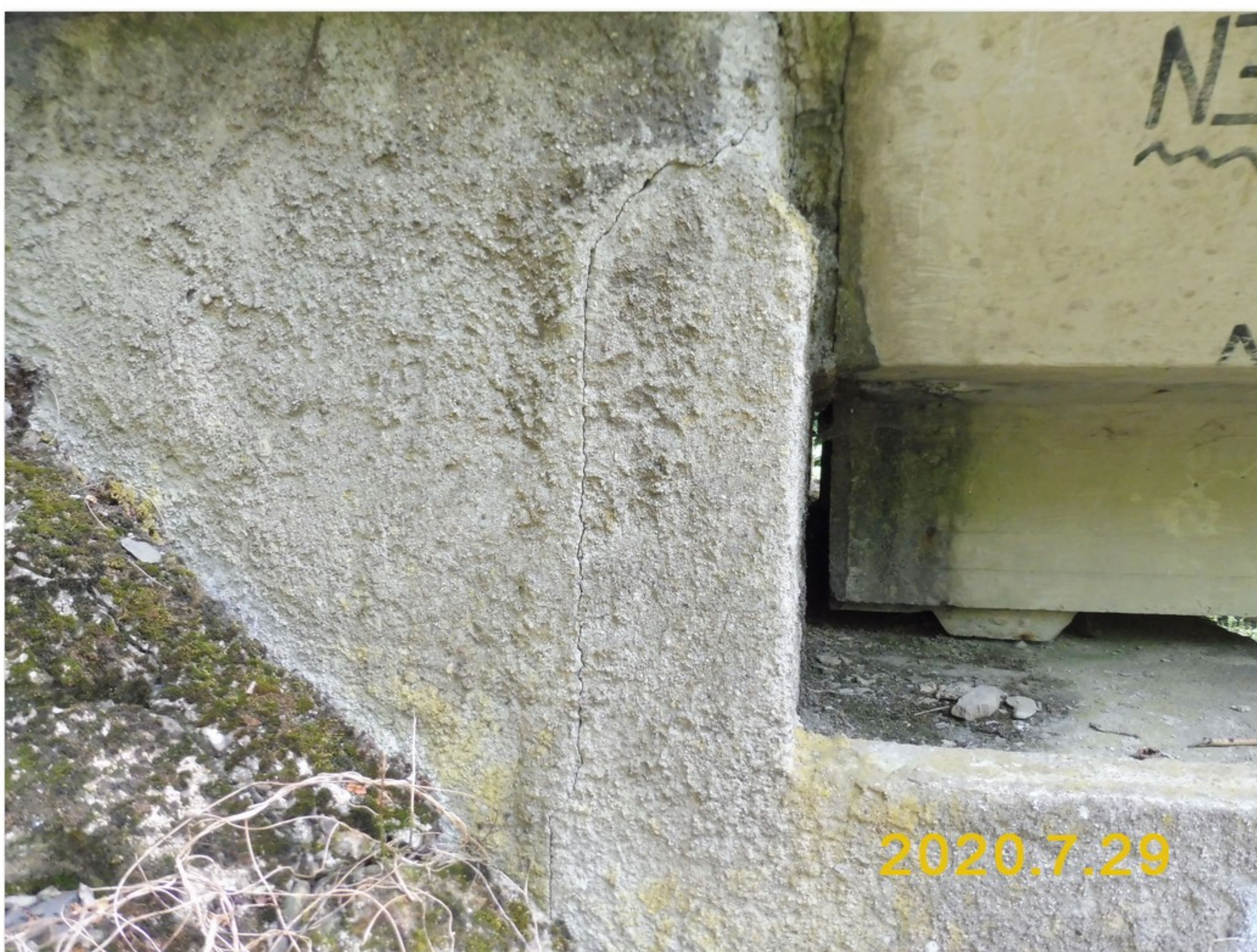
1.2-55 Trhlina mezi levým křídlem a závěrnou zídou opěry 3
