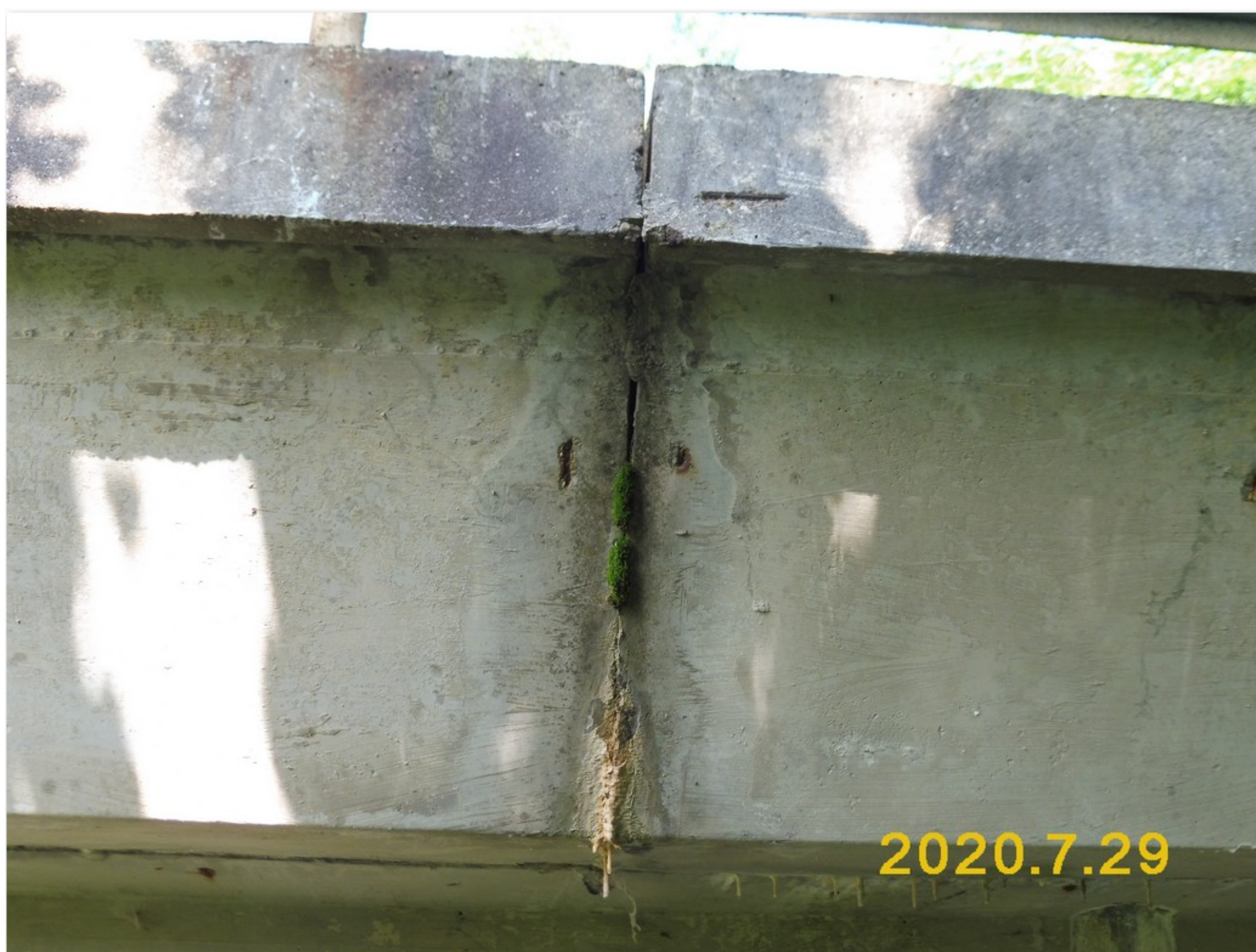
2.1-69 Příčná spára pravé římsové konzoly - zatékání - uchycená vegetace
