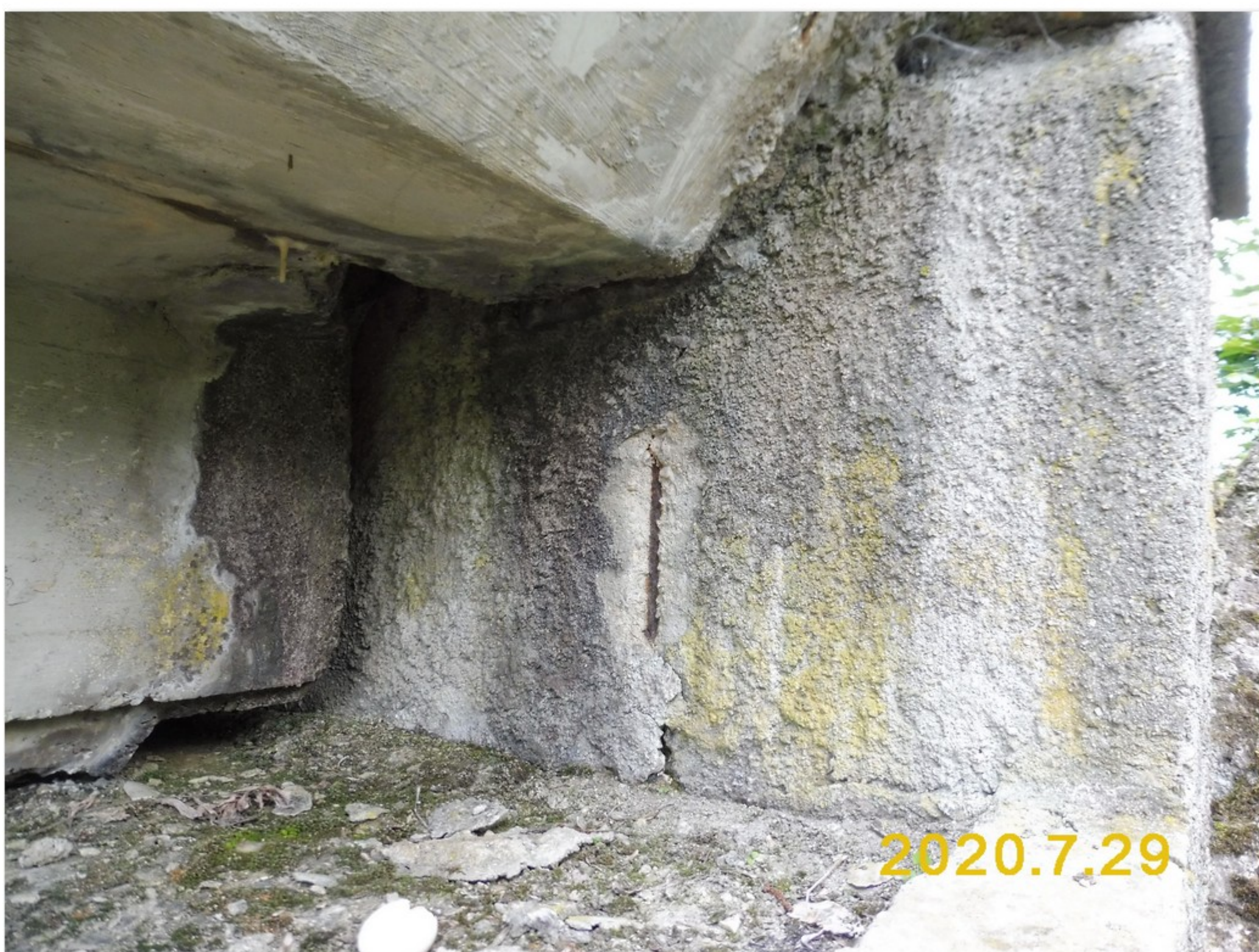
1.2-65 Líc závěrné zídky u pravého čela opěry 3 se stopami dlouhodobého zatékání - obnažená korodující výztuž - odlomený beton
