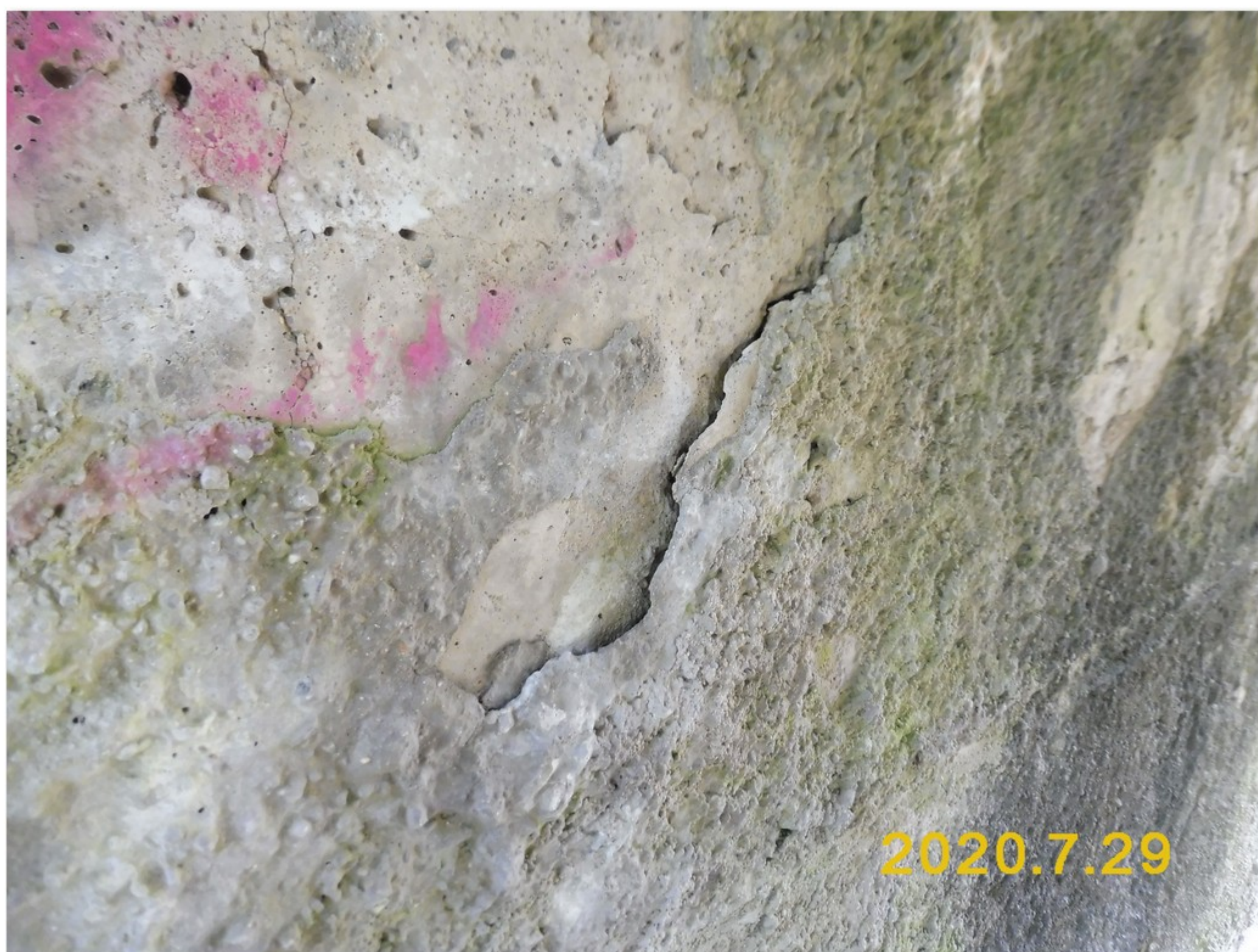
1.2-31 Trhliny a odpadaná omítka v líci podpěry 2 v 1. poli
