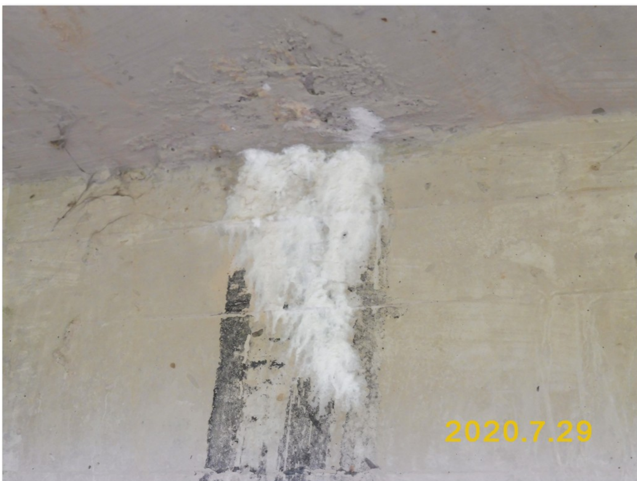
2.1-26 Stopy zatékání mezi levou stěnou a horní přírubou nosníku č. 02.1 - inkrustace
