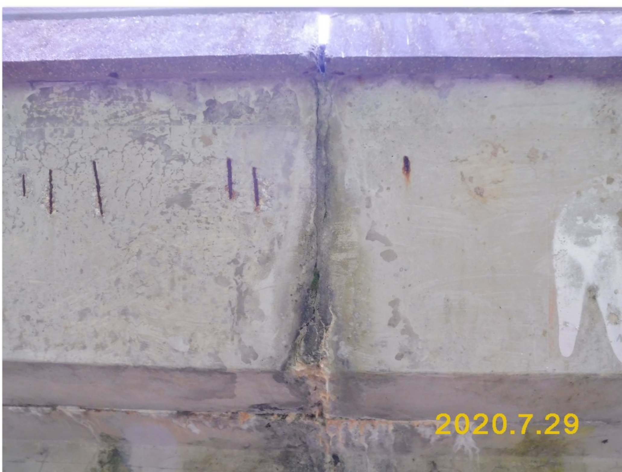
2.1-31 Příčná spára v levé římsové konzole - známky zatékání - inkrustace - krápníky
