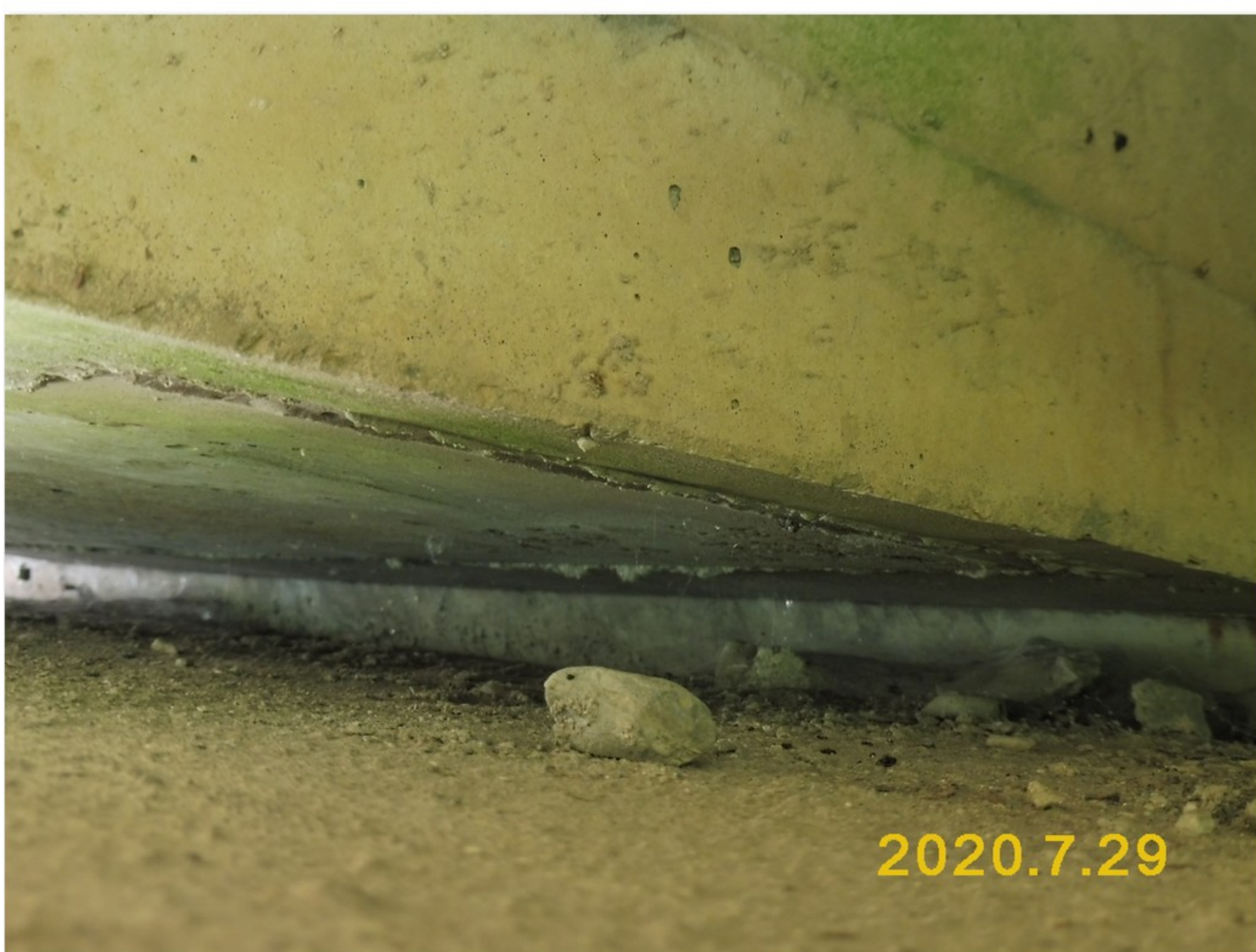
2.2-03 Uložení nosníku č. 02.2 na podpěře 2
