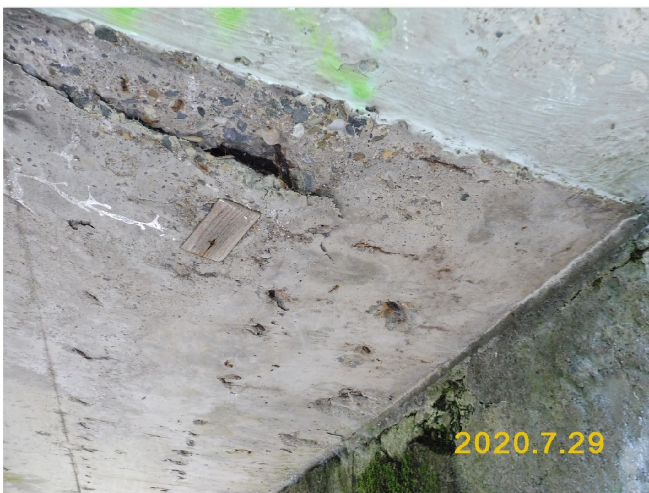
2.1-03 Detail fotografie č. 2.1-02 před opěrou 1 - beton odlomený působením korozních zplodin
