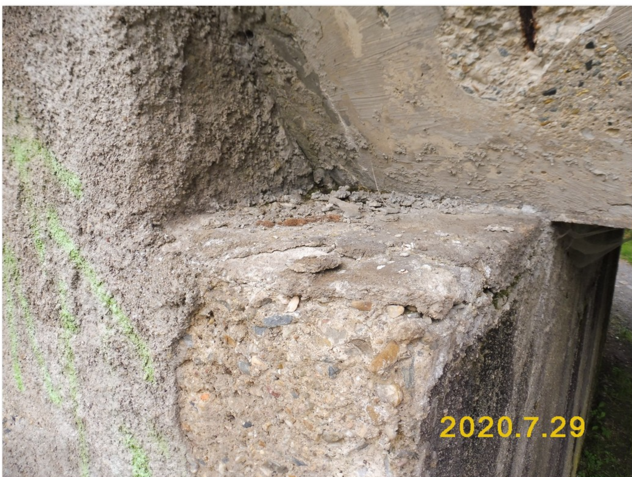
1.2-11 Úložný práh opěry 1 u pravého čela - rozpad betonu
