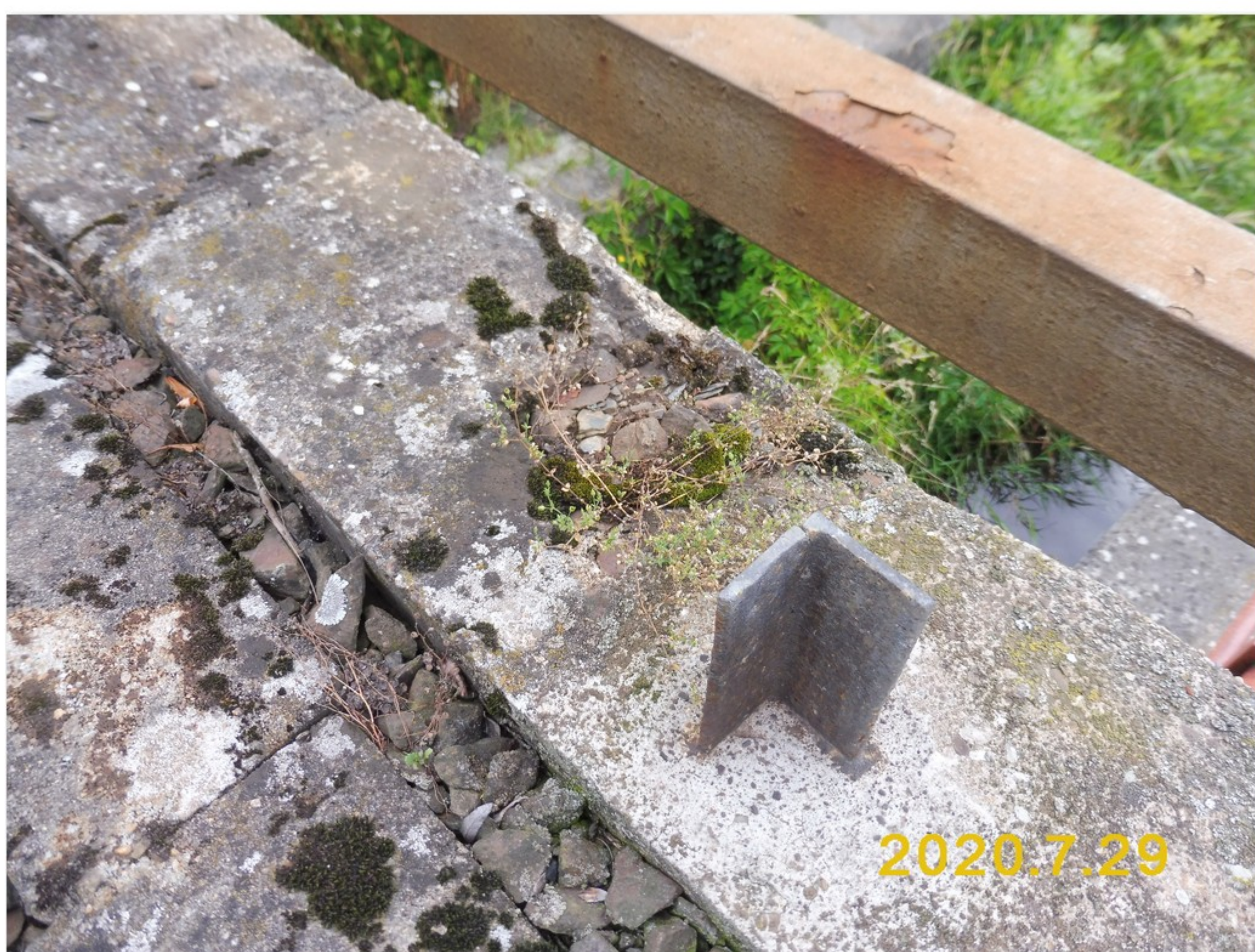
3.2-26 Horní povrch pravé římsy nad podpěrou 2 - rozpad betonu - uchycená vegetace
