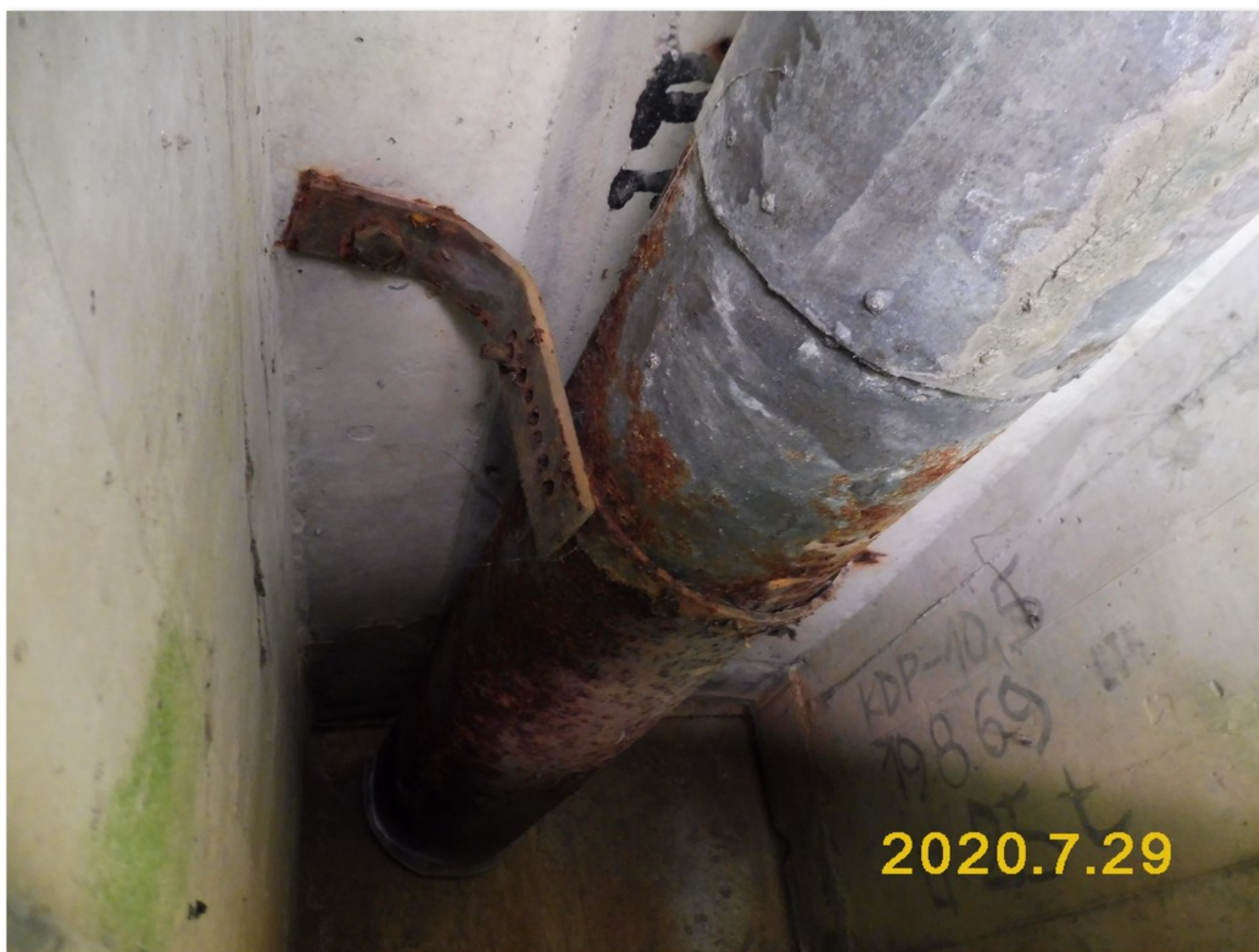
3.4-02 Detail uchycení odvodňovacího žlabu nad podpěrou 2 - žlab napadený plošnou korozí
