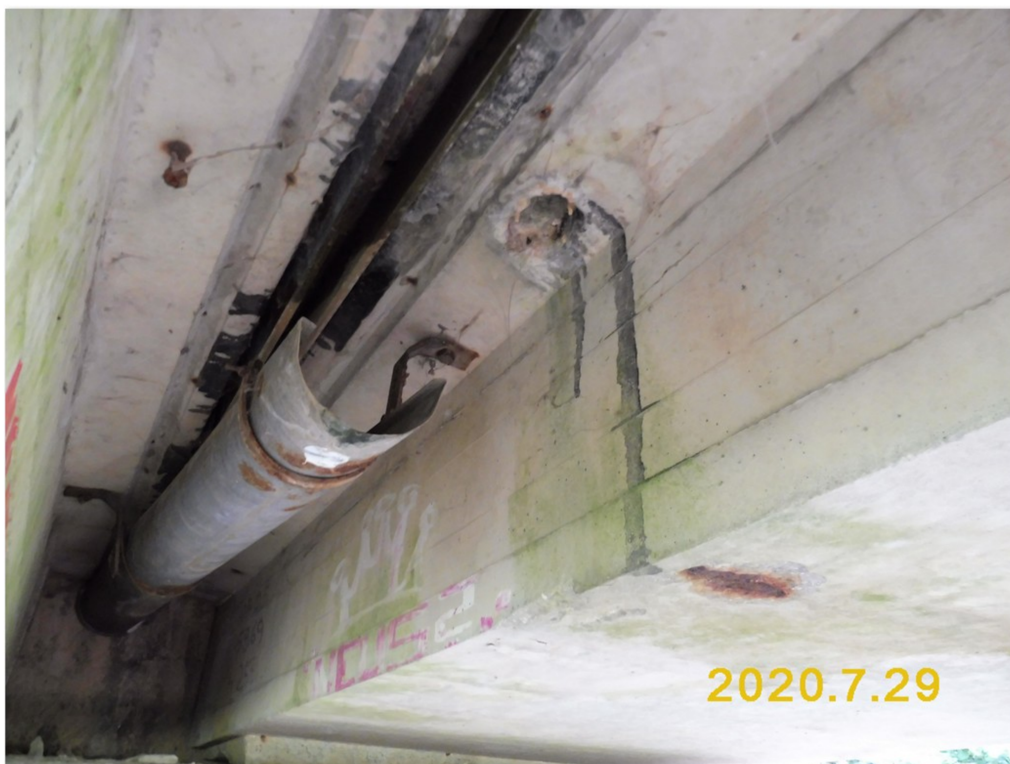
2.1-55 Zatékání přes montážní otvor v levé horní přírubě nosníku č. 02.2 před opěrou 3 - výluhy - krápníky
