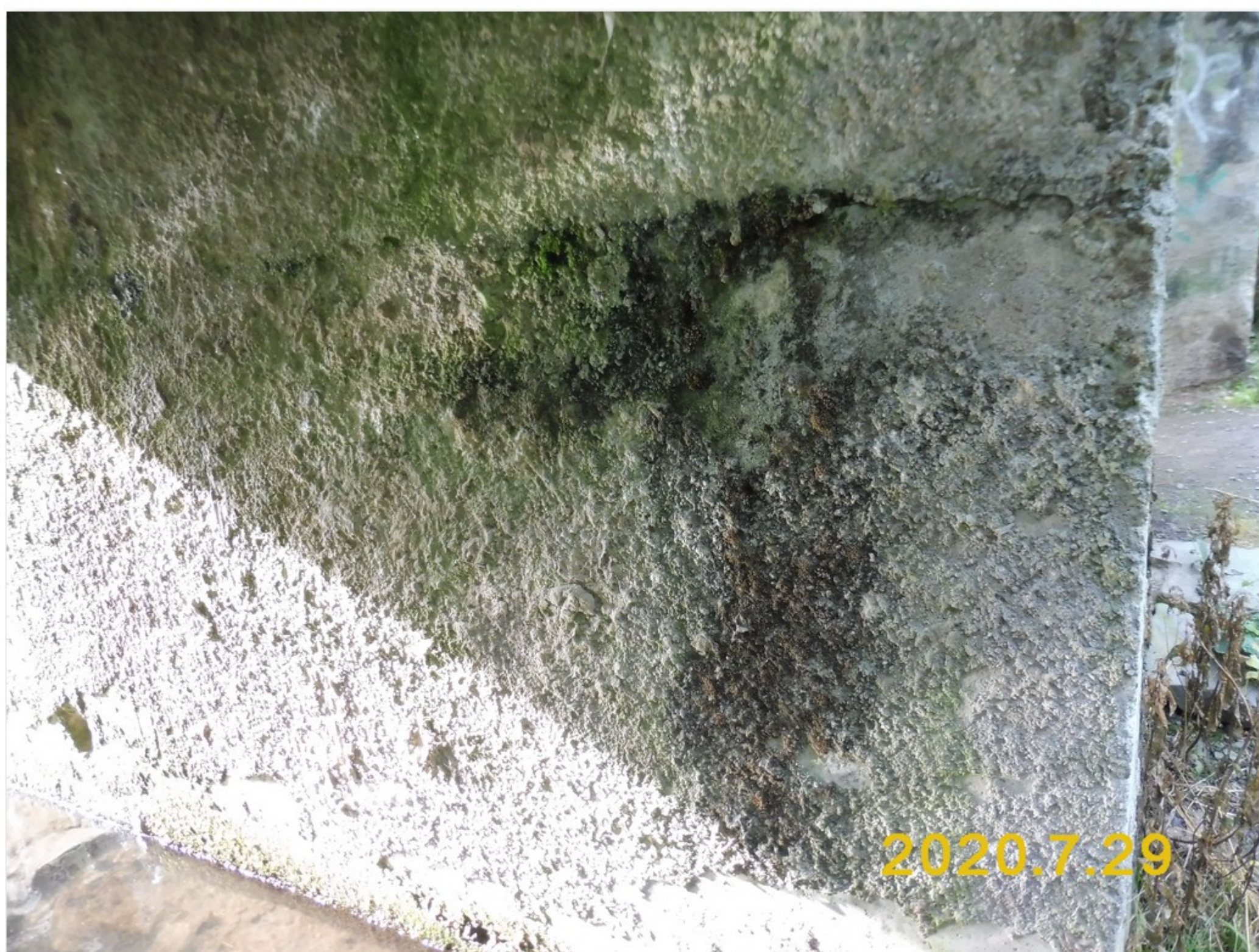
1.2-40 Líc podpěry 2 ve 2. poli - stopy vody pronikající spárou mezi prefabrikovaným úložným prahem a monolitickým dříkem - uchycená vegetace
