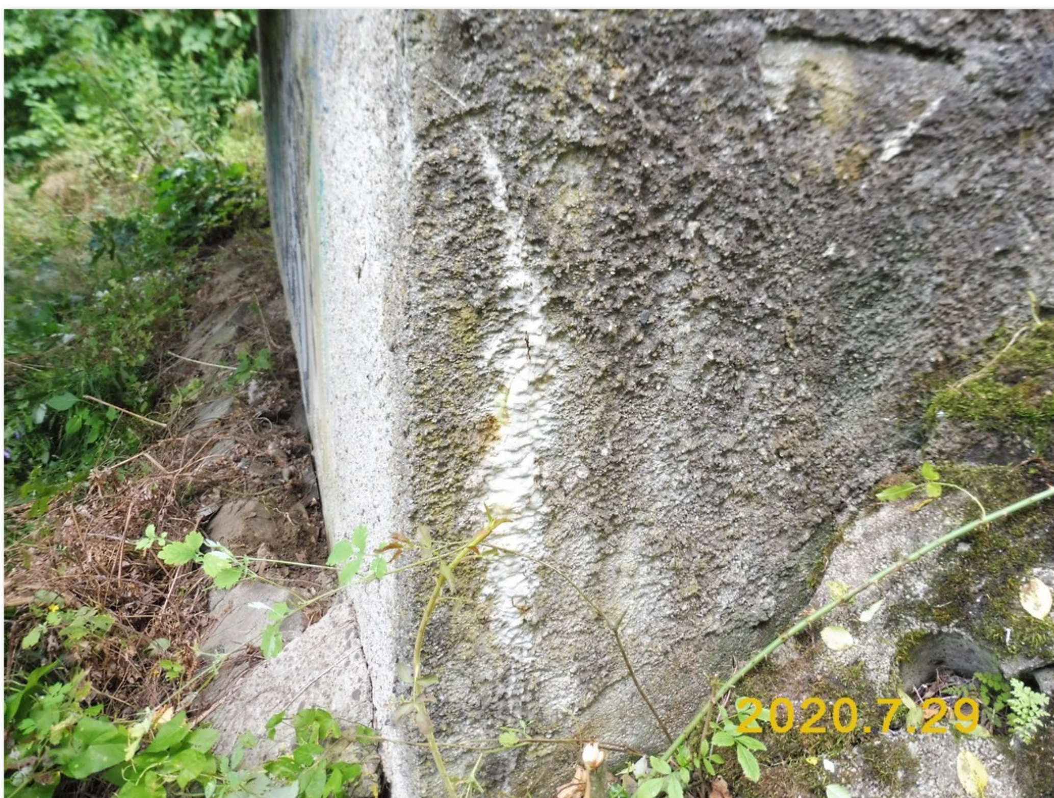
1.2-64 Trhliny s průsaky a inkrustacemi na pravém čele opěry 3
