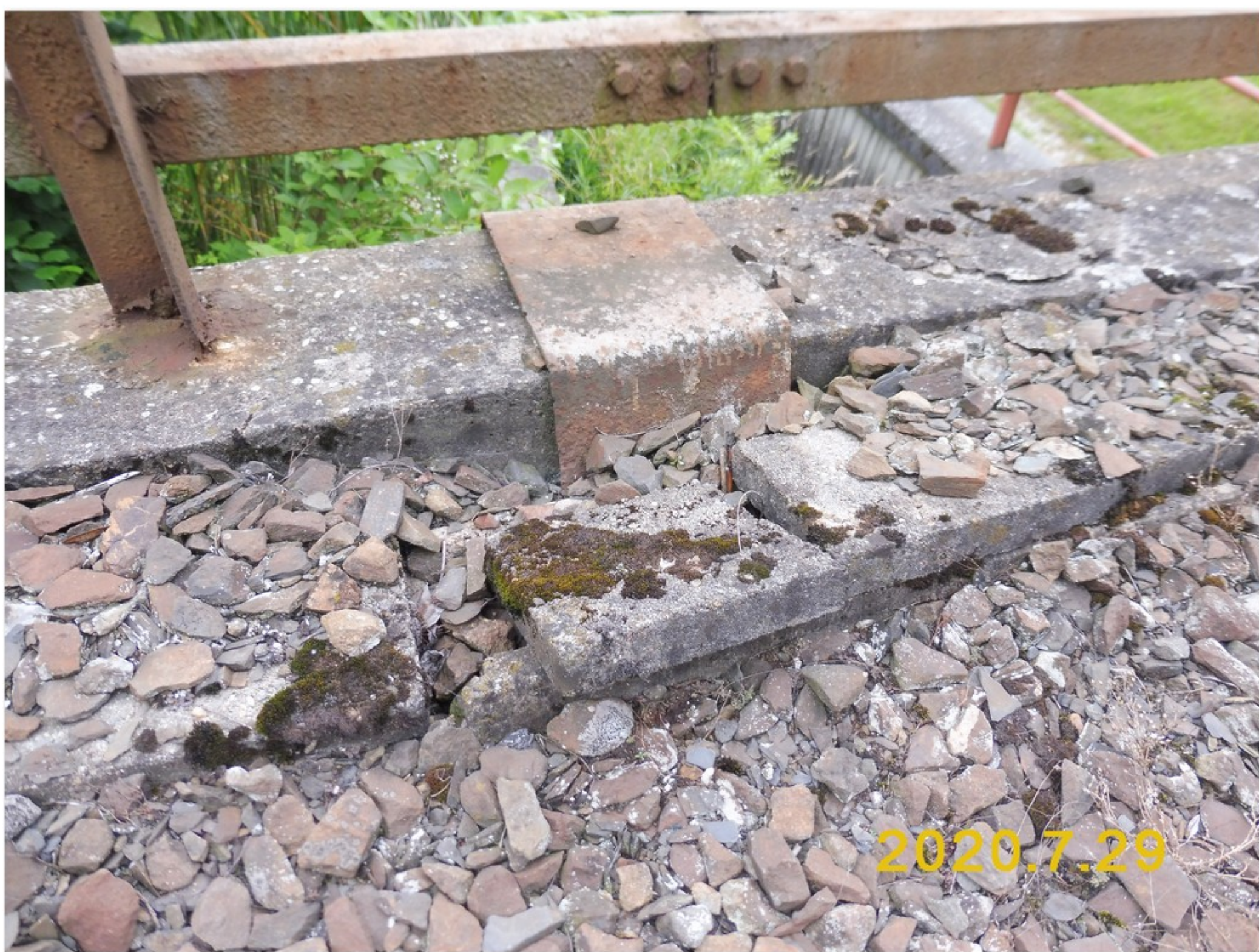
3.2-27 Zakrytí dilatační spáry pravé římsy uprostřed rozpětí 2. pole
