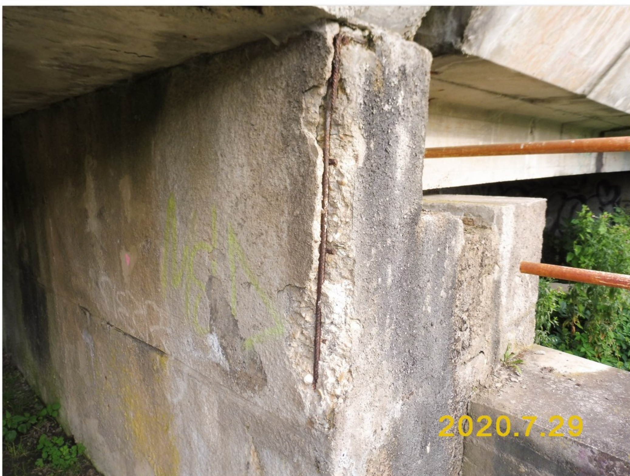
1.2-36 Pravý roh podpěry 2 v 1. poli - koroze výztuže - beton odlomený působením korozních zplodin
