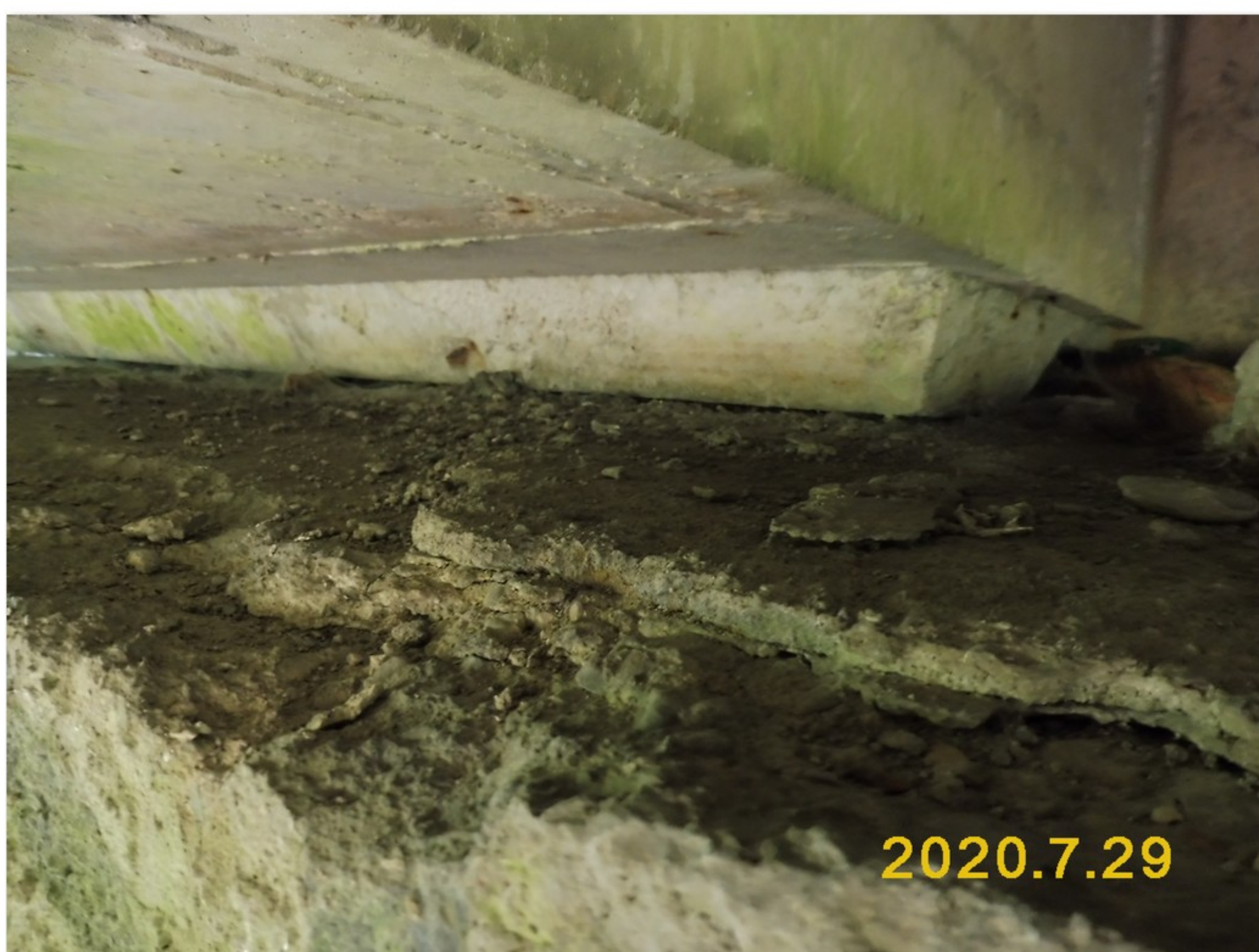
1.2-61 Degradace betonu na horním povrchu úložného prahu opěry 3
