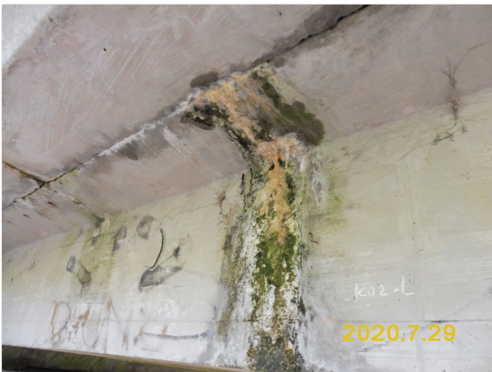
2.1-33 Opakující se poruchy na styku nosníku č. 02.1 a římsové konzoly
