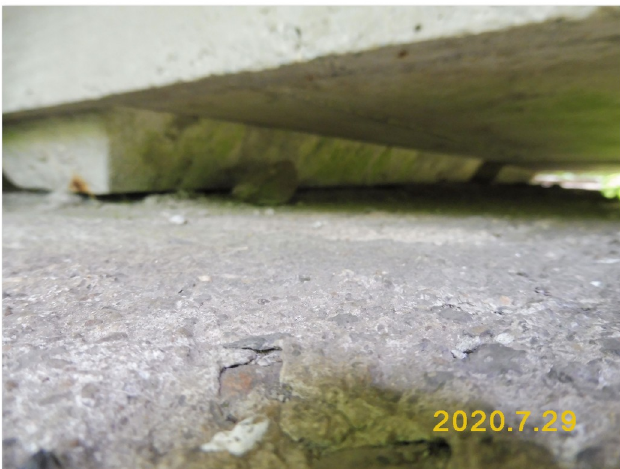
2.2-01 Uložení nosníku č. 02.1 na opěře 3 - pohled od líce opěry
