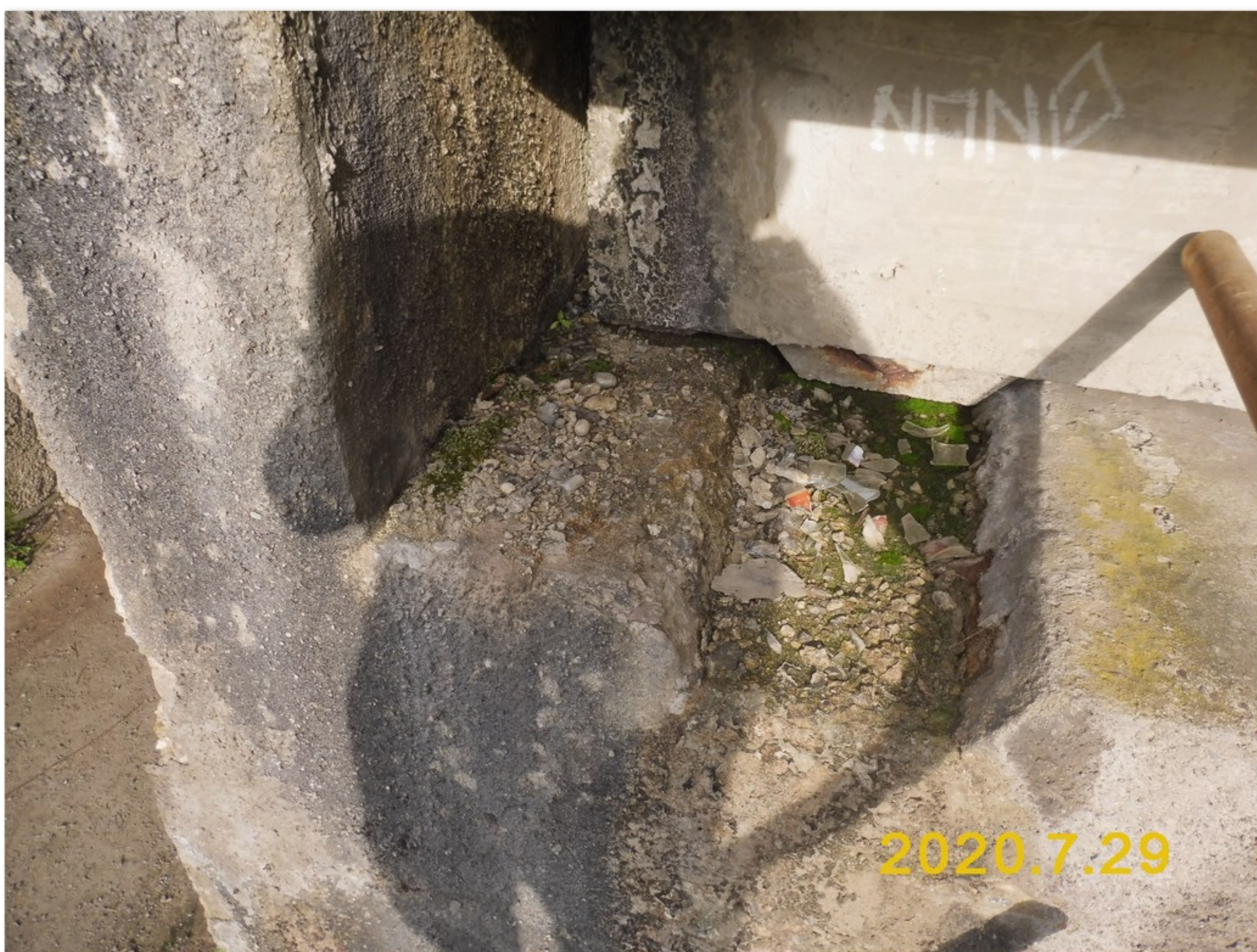
1.2-37 Úložný práh u pravého čela podpěry 2 - uchycená vegetace - znečištění odpadným betonem
