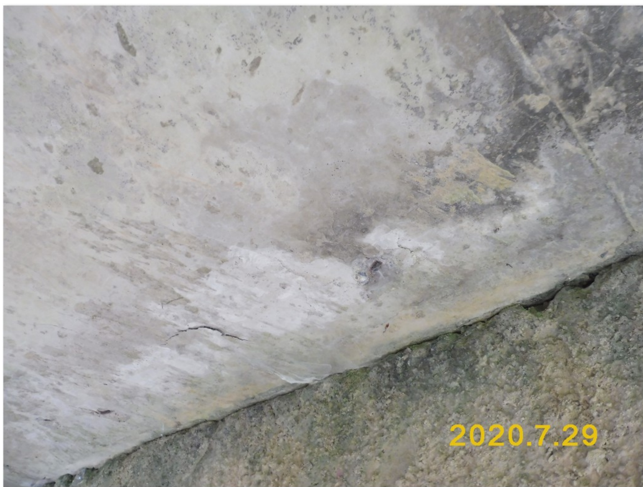
2.1-06 Podhled nosné konstrukce K01 před opěrou 1 - stopy zatékání - výluhy
