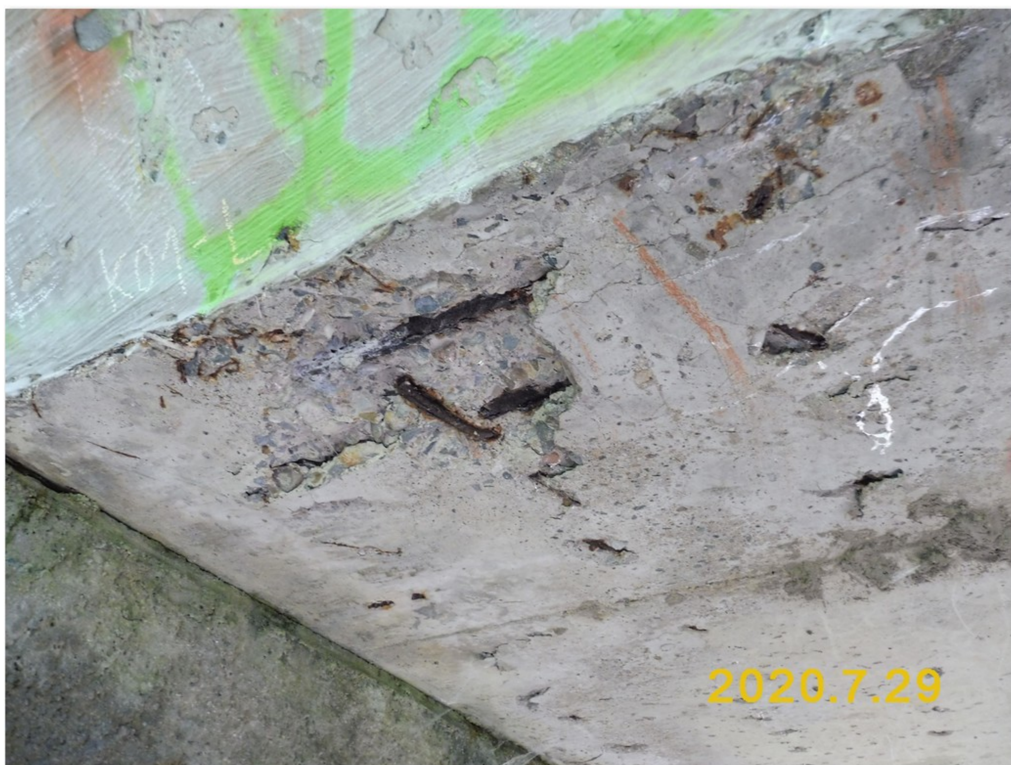
2.1-04 Detail fotografie č. 2.1-02 před pilířem 2 - beton odlomený působením korozních zplodin
