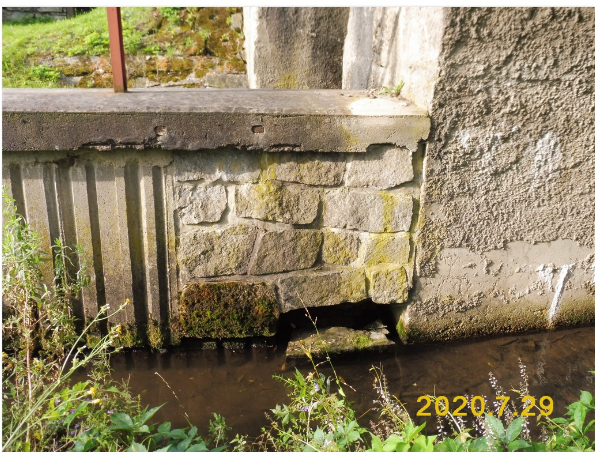
4.3-01 Poškozená levobřežní zeď v místě napojení na pravé čelo pilíře 2
