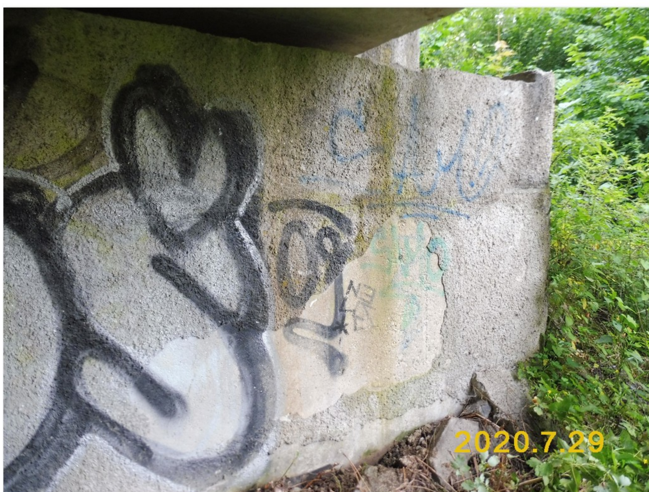
1.2-59 Odpadaná omítka v lici opěry 3 u pravého čela
