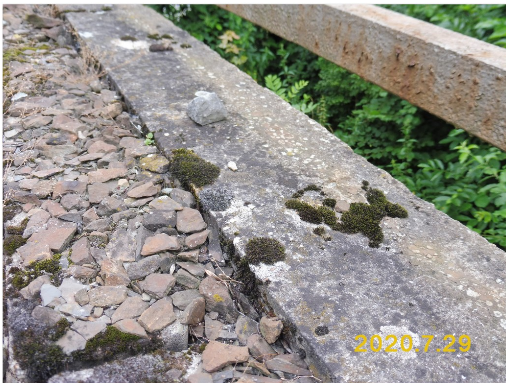
3.2-29 Uchycená vegetace na horním povrchu pravé římsy
