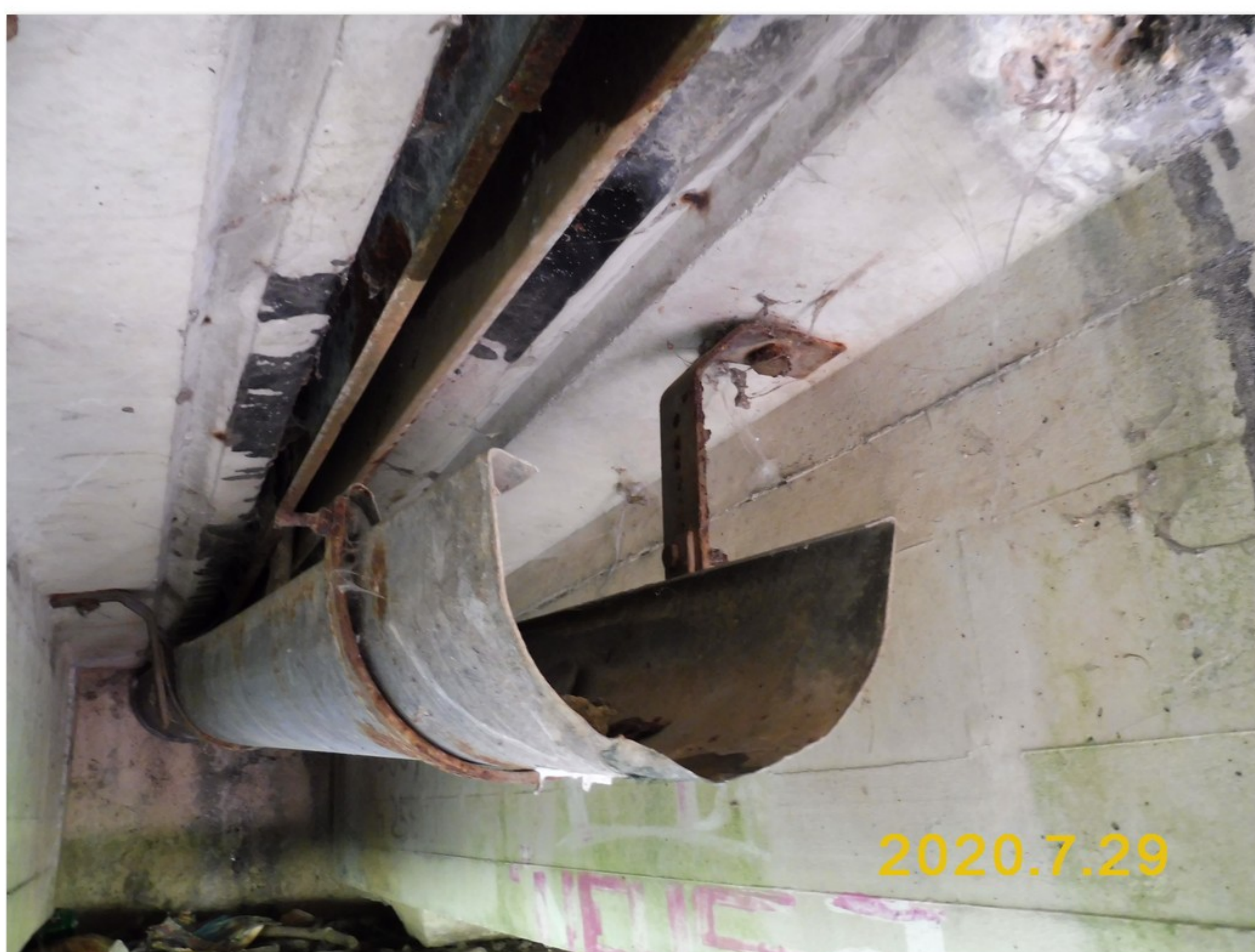
3.4-03 Odvodňovací žlab mezi nosníky nad opěrou 3
