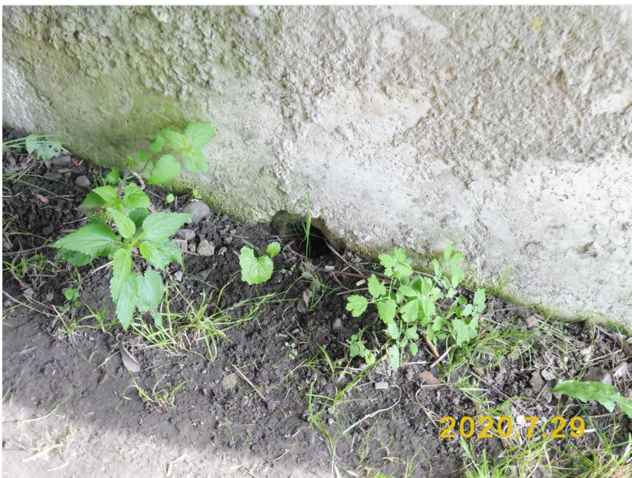
1.2-33 Odvodňovací otvor v patě podpěry 2 - líc podpěry v 1. poli
