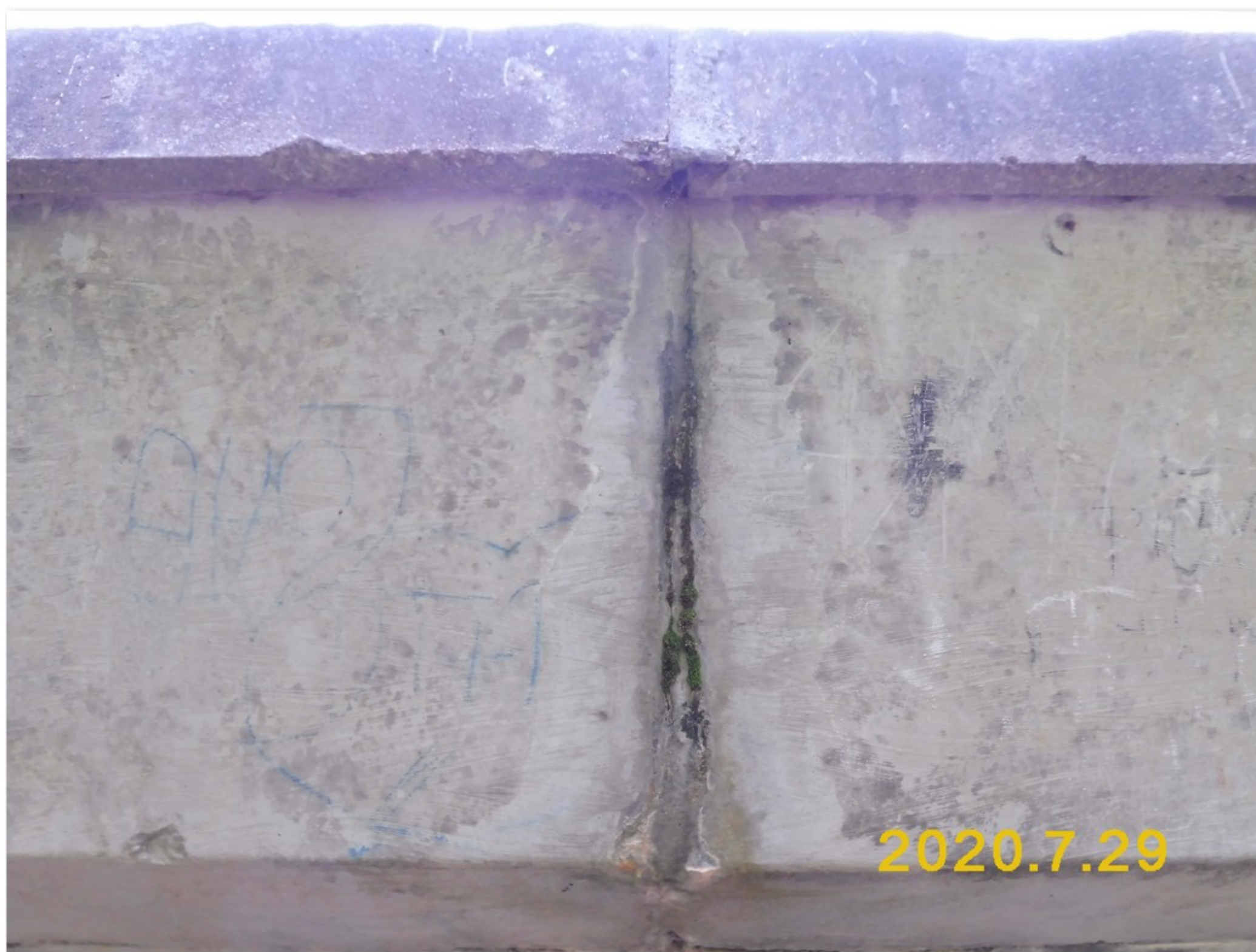
2.1-28 Příčná spára v levé římsové konzole - stopy zatékání - uchycená vegetace
