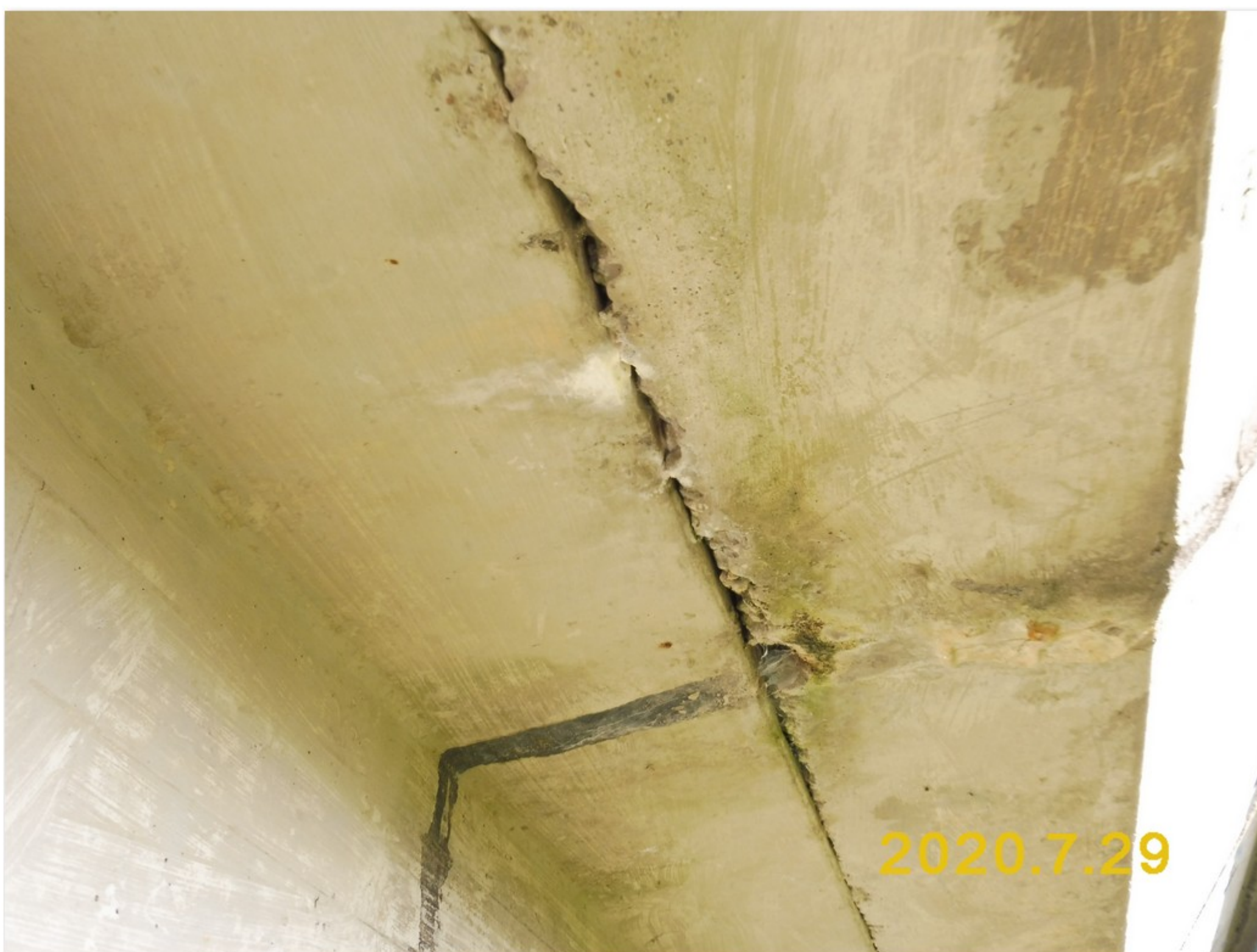
2.1-65 Podélná spára mezi nosníkem č. 02.2 a římsovou konzolou - zatékání - výluhy - inkrustace
