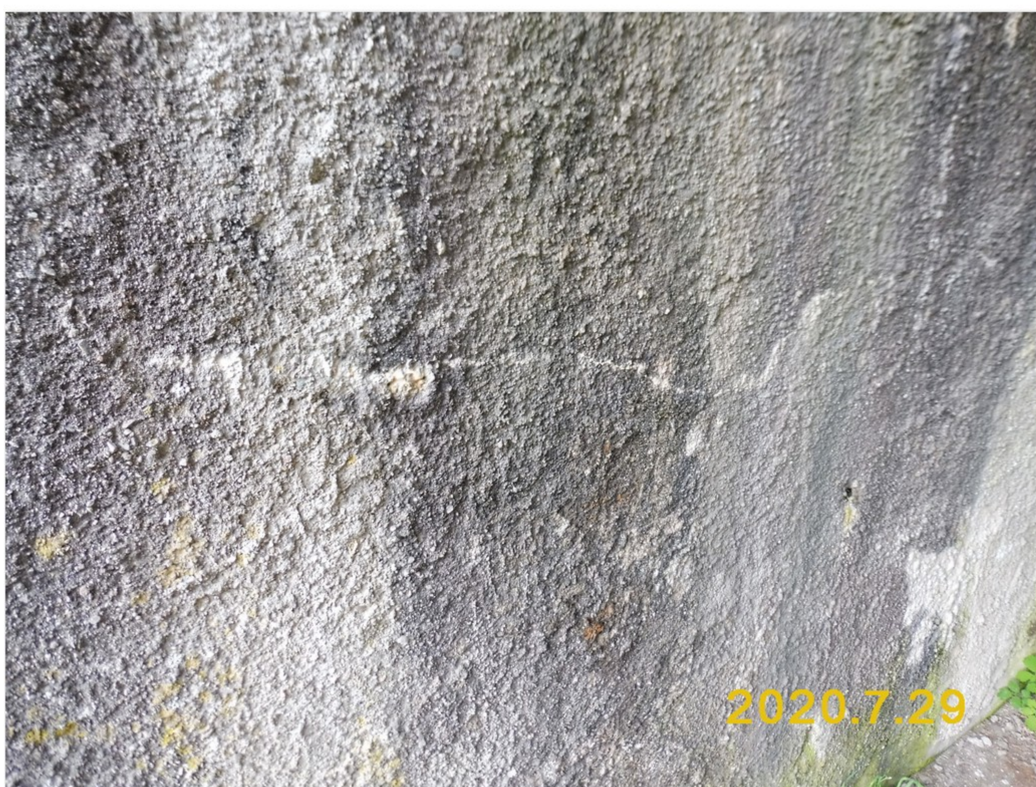
1.2-09 Líc opěry 1 - trhliny s průsaky a výluhy
