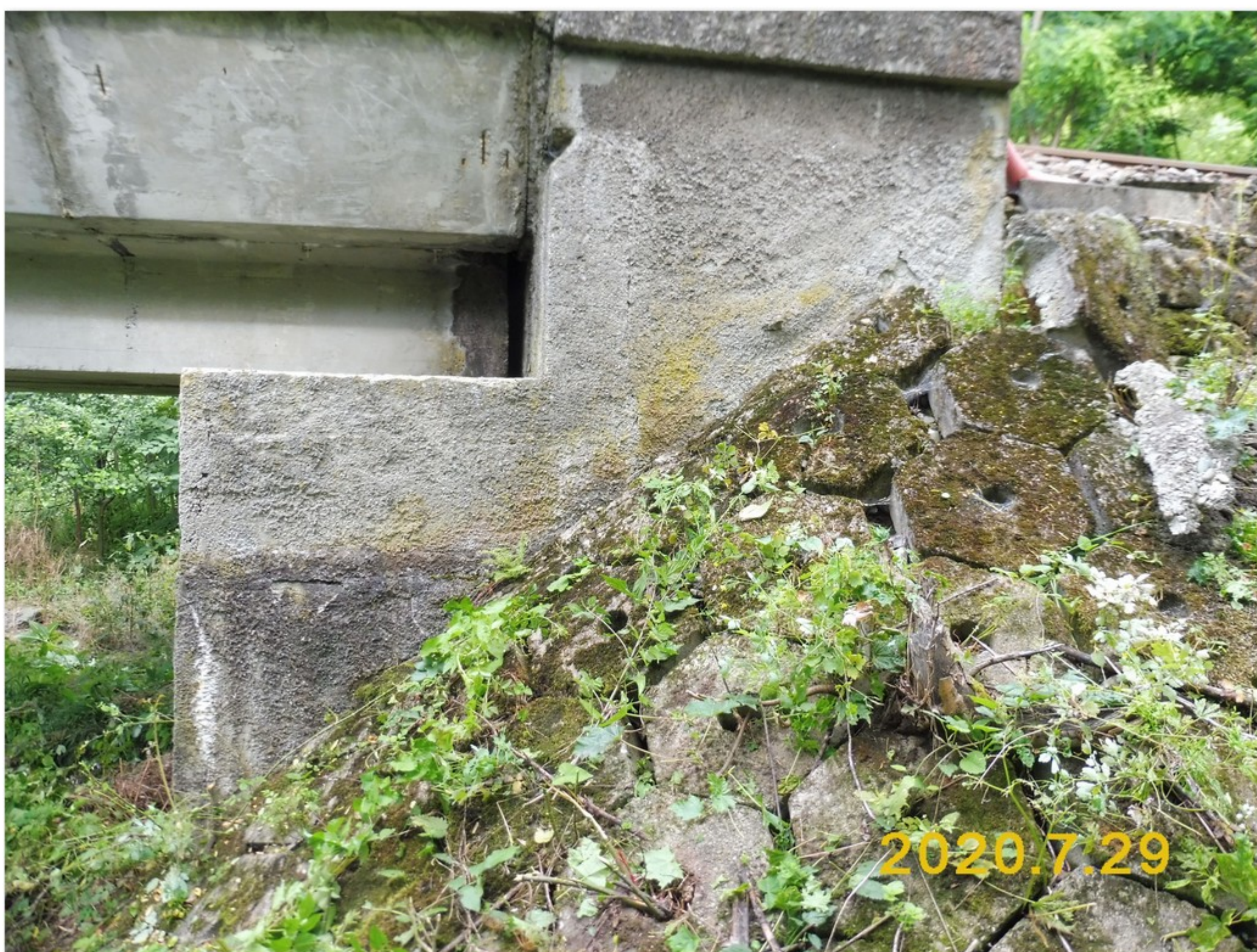
1.2-54 Pravé čelo opěry 3 s navazujícím křídlem - po odstranění vegetace ze svahového kuželu prohlídkářem
