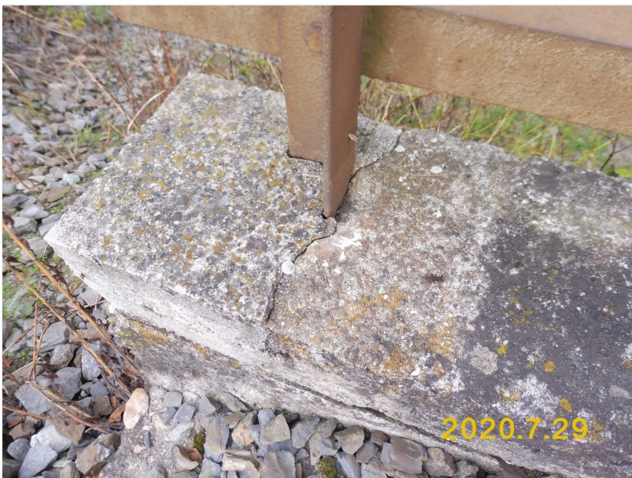
3.2-03 Prasklina na začátku levé římsy v místě uložení sloupku zábradlí
