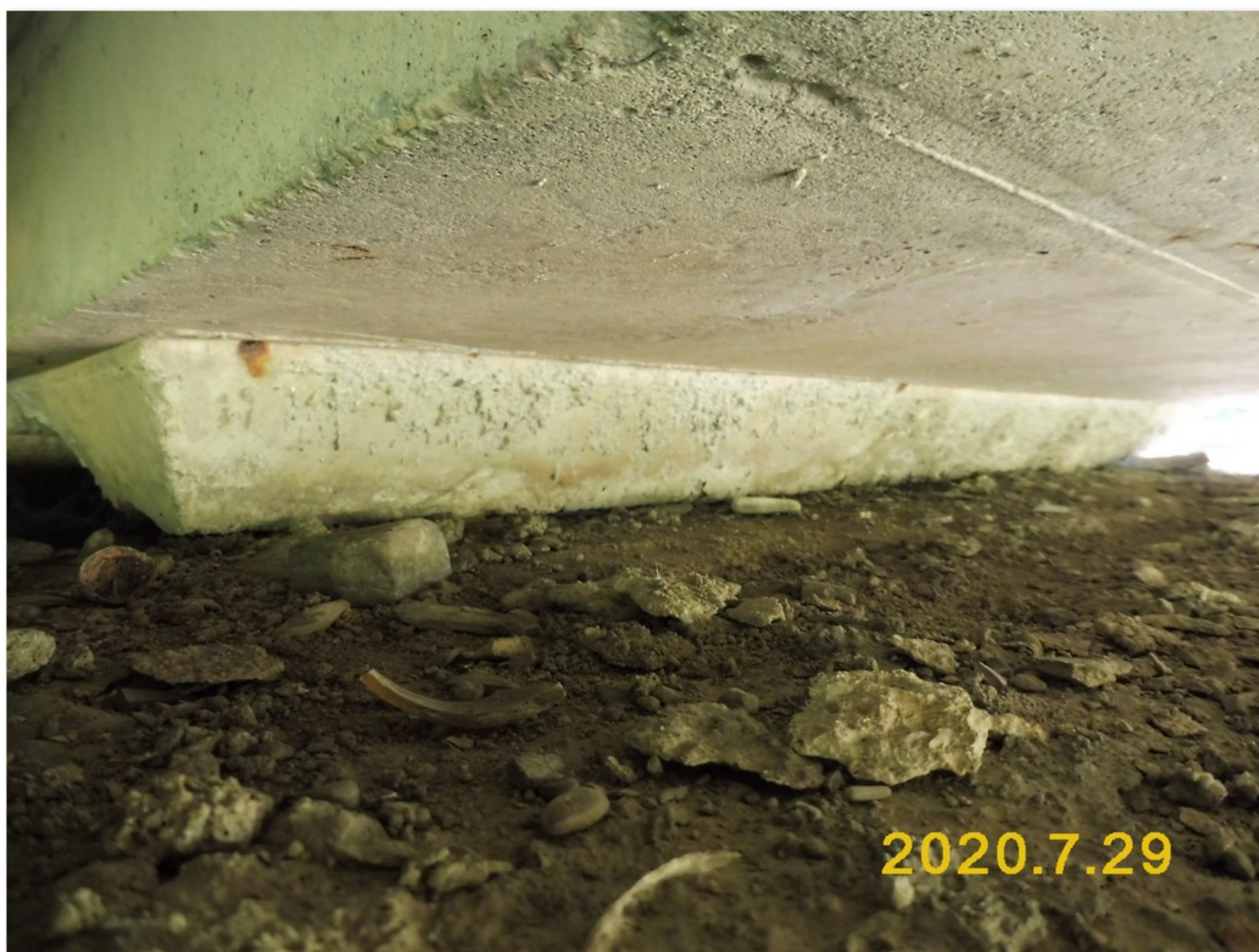
2.2-04 Uložení nosníku č. 02.2 na opěře 3 - pohled od líce opěry
