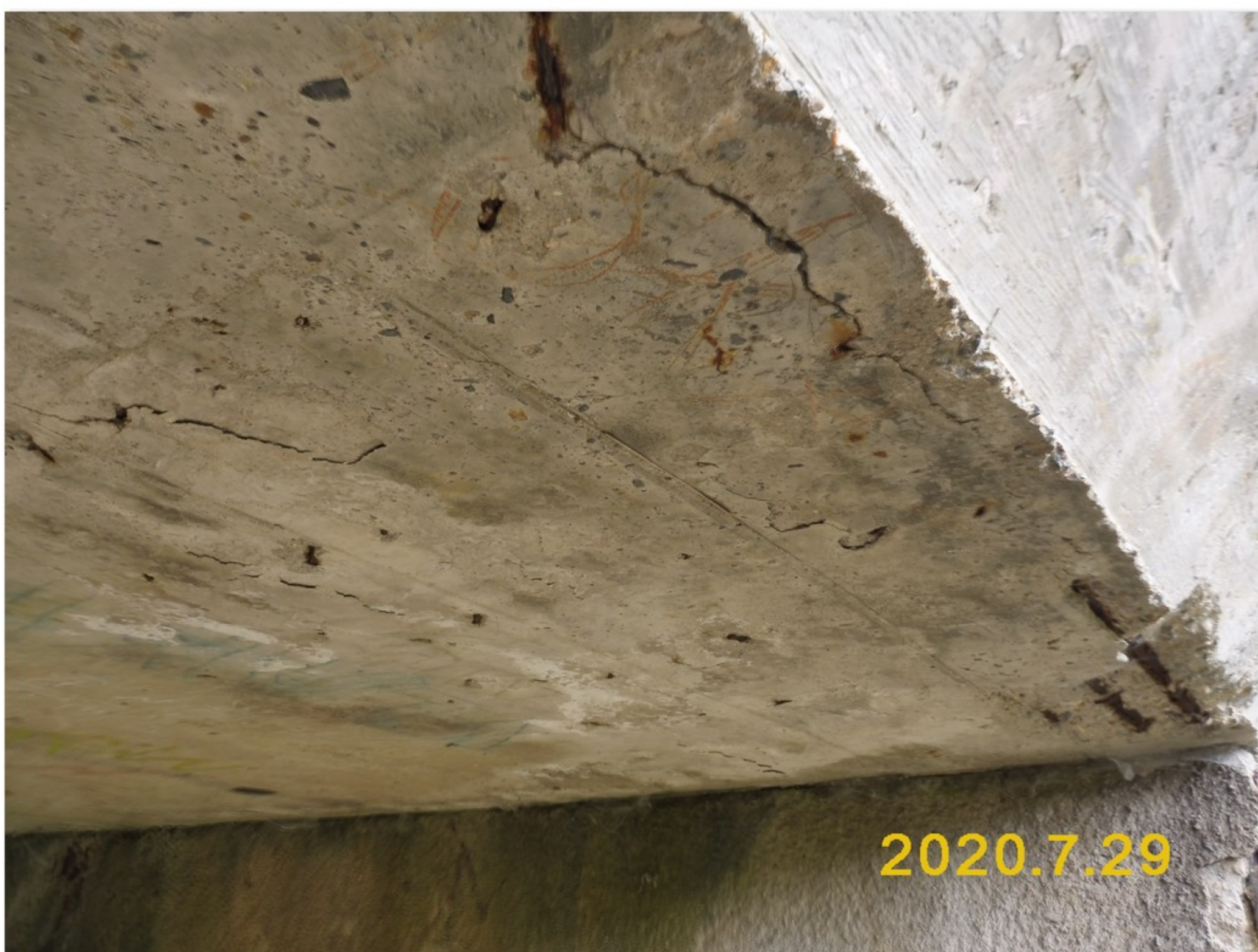
2.1-09 Podhled nosné konstrukce K01 před pilířem 2 - beton odlomený působením korozních zplodin v místě podélné výztuže
