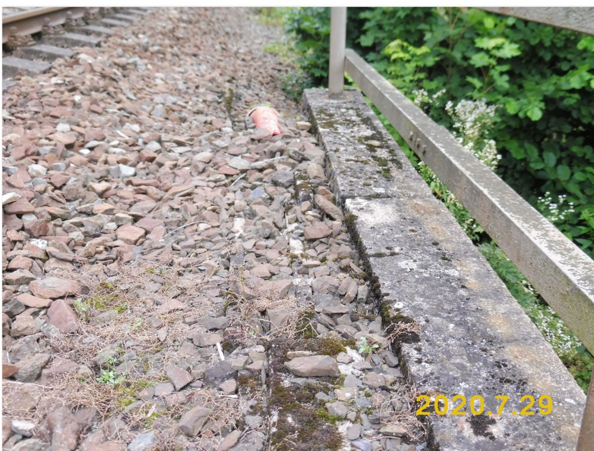
4.2-04 Kabelový žlab podél pravé římsy na křídle opěry 3 - chybějící krycí desky
