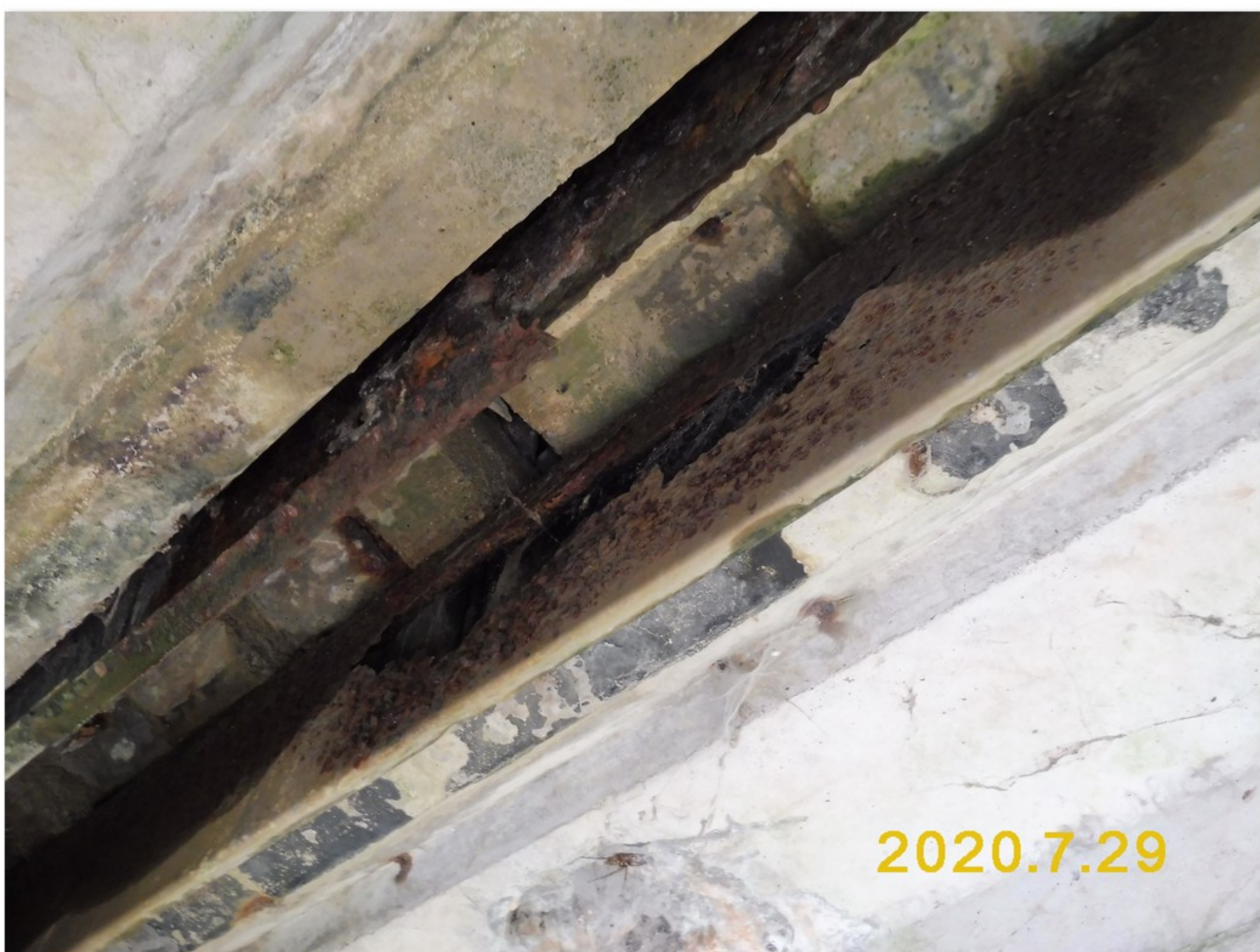
3.3-02 Podélná spára mezi nosníky ve 2. poli - korozi zcela strávené části okapních plechů
