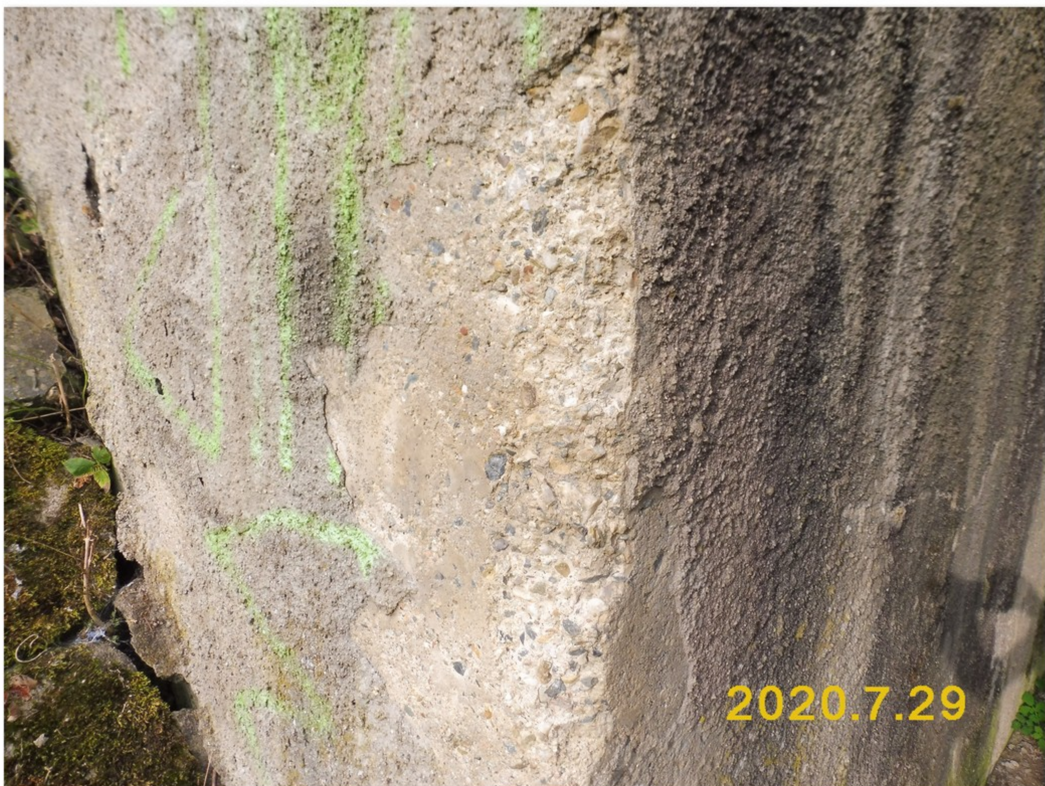
1.2-13 Odpadnutá omítka a degradace betonu na pravém rohu opěry 1
