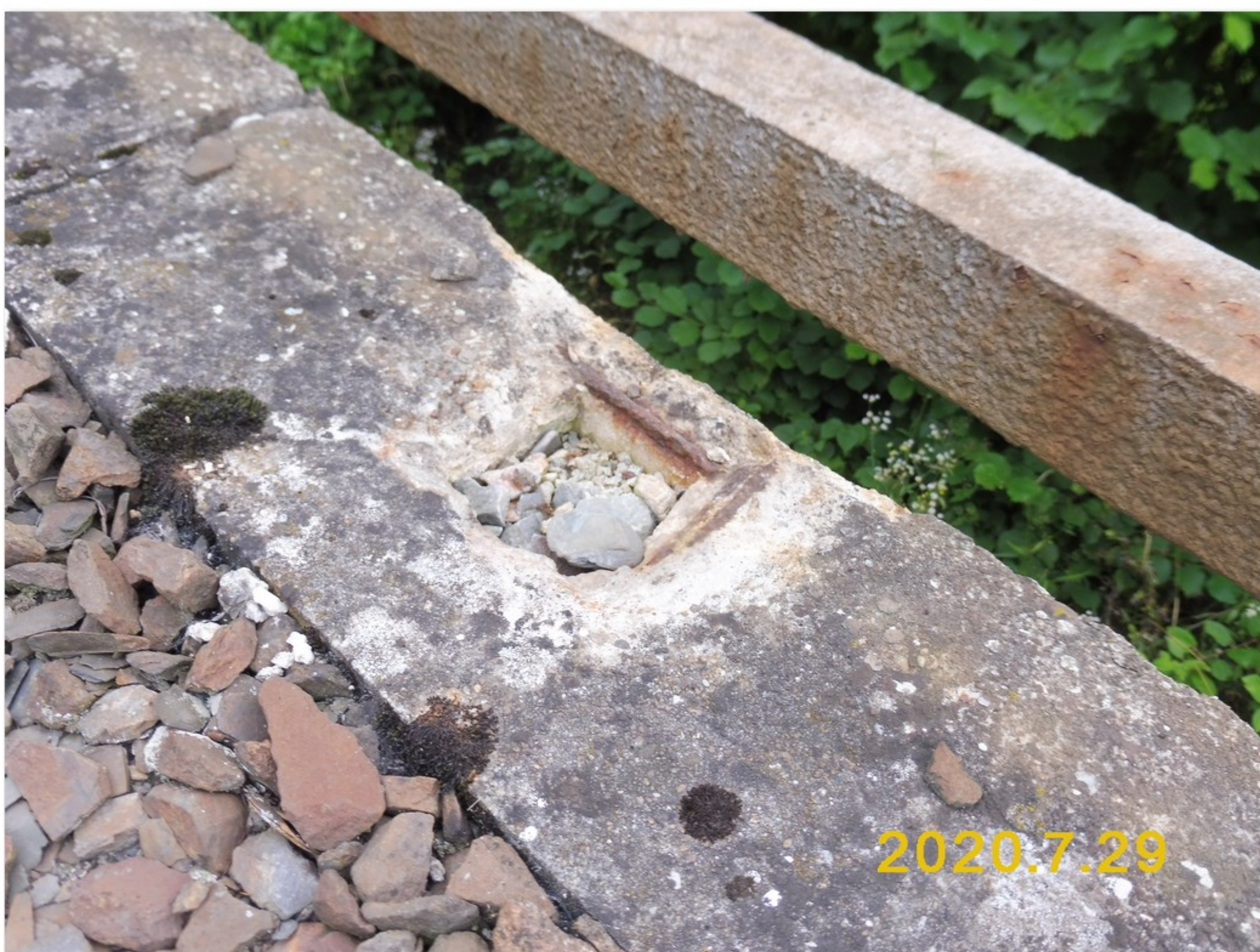
3.2-28 Pravá římsa ve 2. poli - nevyplněný otvor pro uložení sloupku zábradlí - v okolí otvoru degradace betonu
