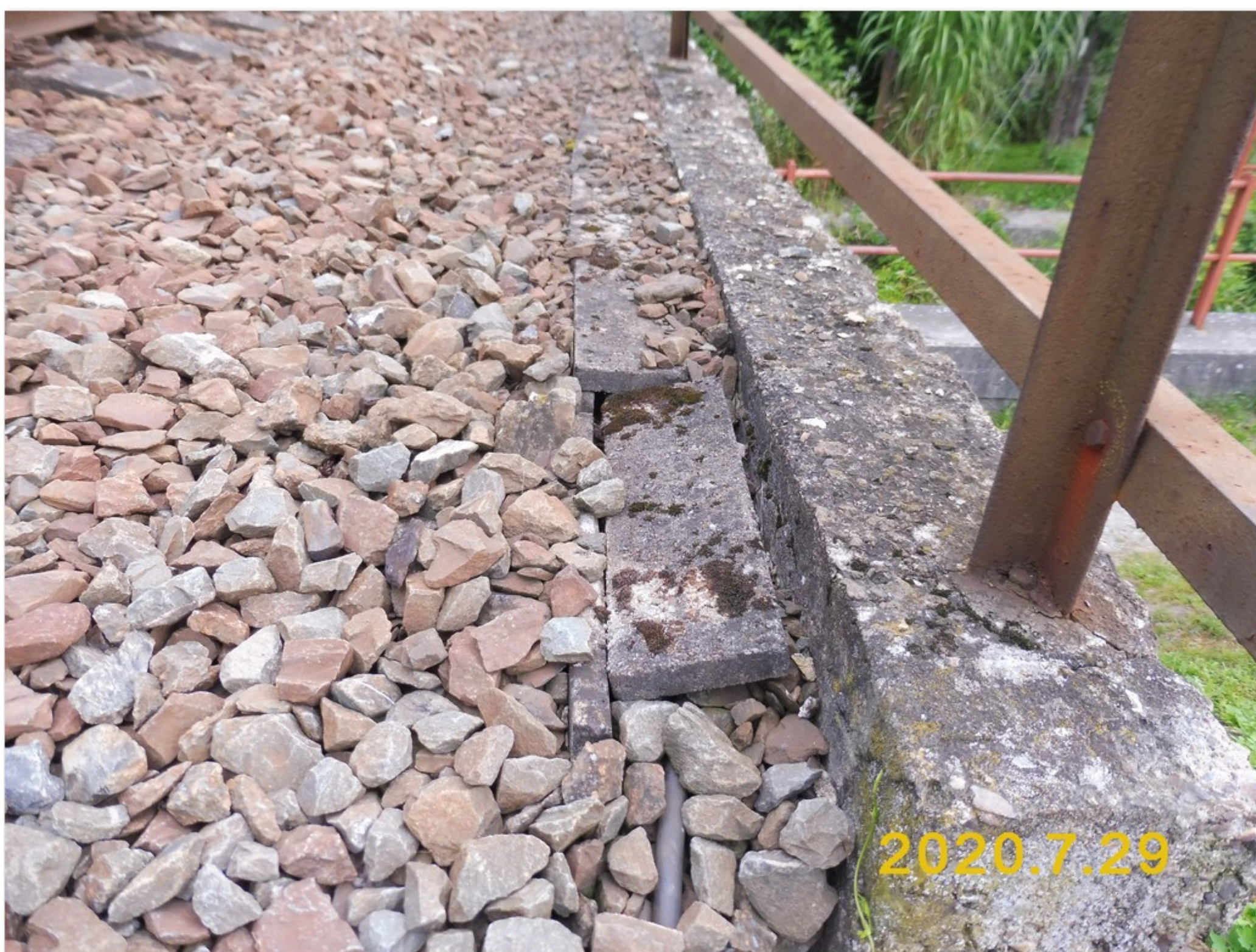
4.2-01 Kabelový žlab podél pravé římsy na křídle opěry 1 - posunutá krycí deska
