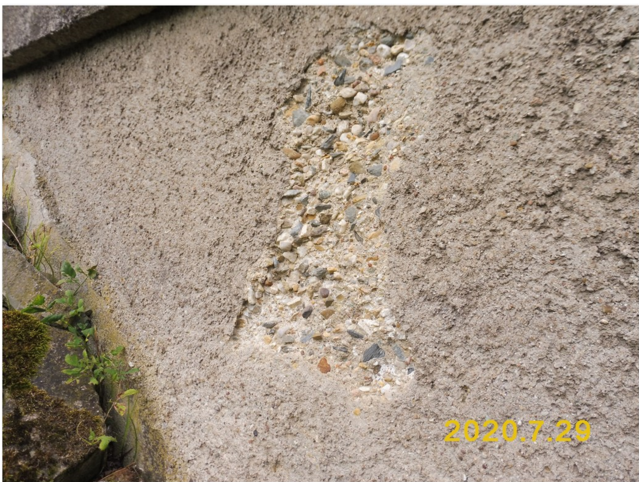
1.2-12 Pravé křídlo opěry 1 - odpadnutá omítka - degradace betonu
