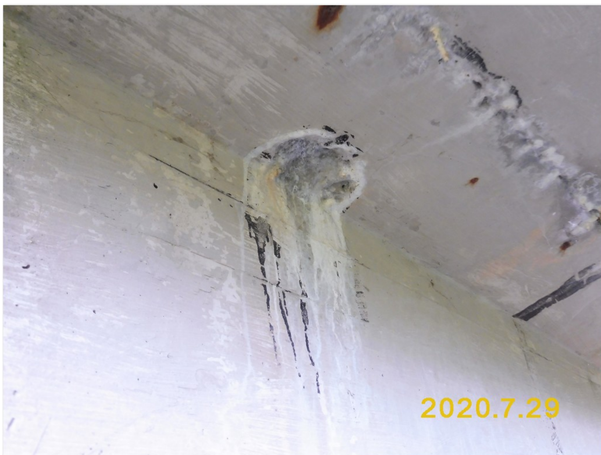
2.1-71 Zatékání přes montážní otvor v pravé horní přírubě nosníku č. 02.2 před opěrou 3
