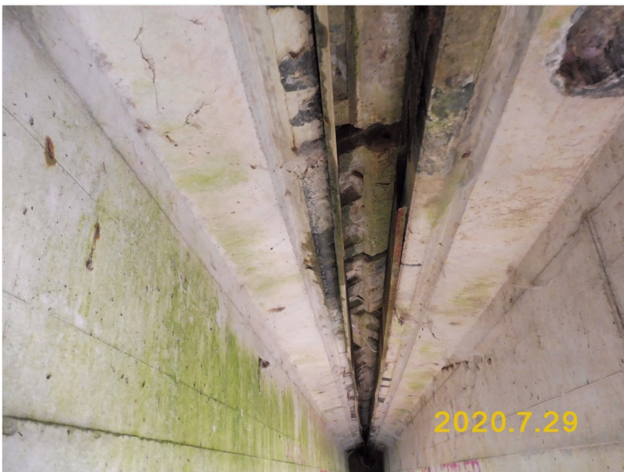
3.3-01 Podélná spára mezi nosníky ve 2. poli - stopy vody pronikající pod okapními plechy
