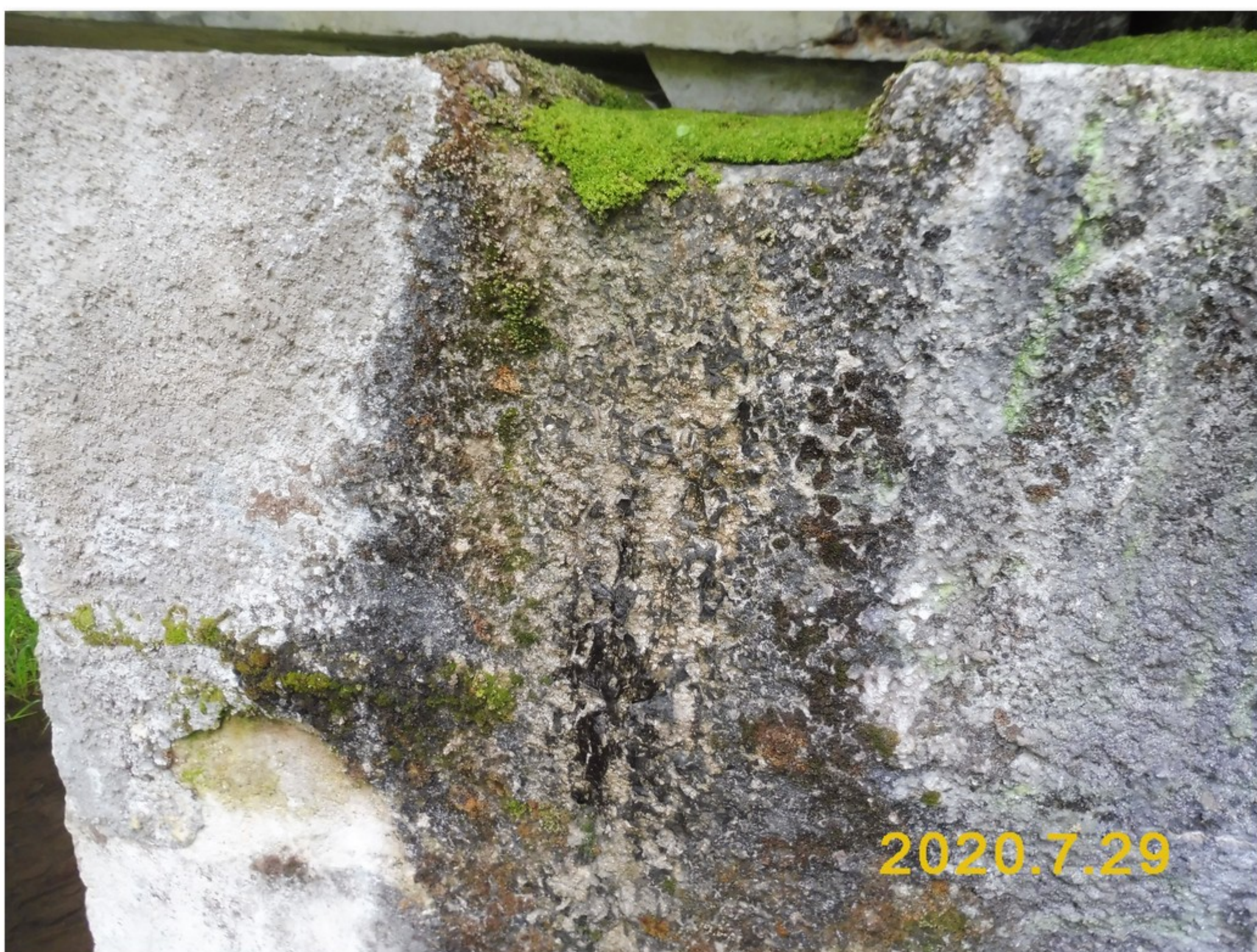
1.2-29 Úložný práh na levém čele podpěry 2 - degradace omítky a betonu zapříčiněná dlouhodobě protékající vodou
