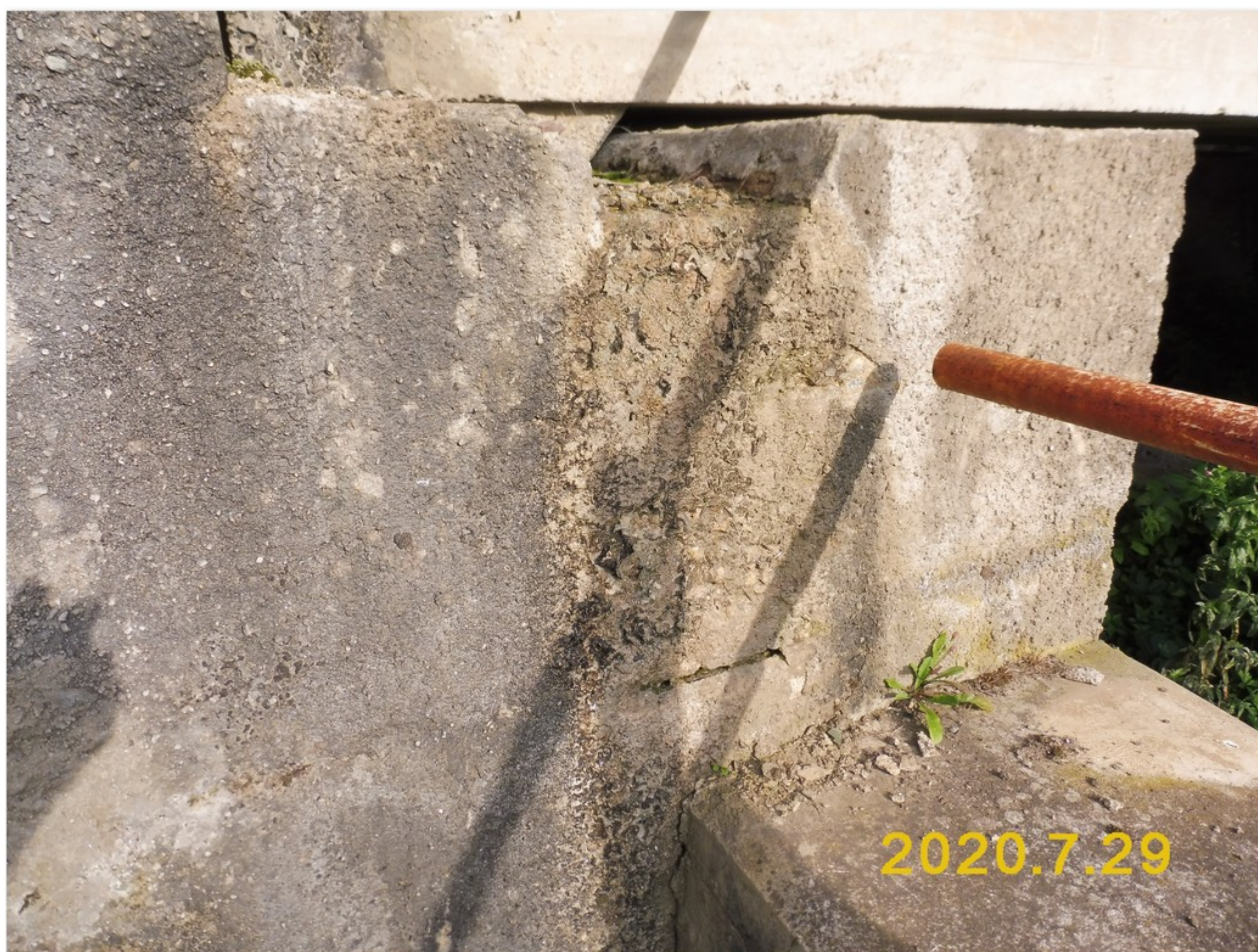
1.2-39 Úložný práh na pravém čele podpěry 2 - degradace omítky a betonu způsobená dlouhodobě protékající vodou
