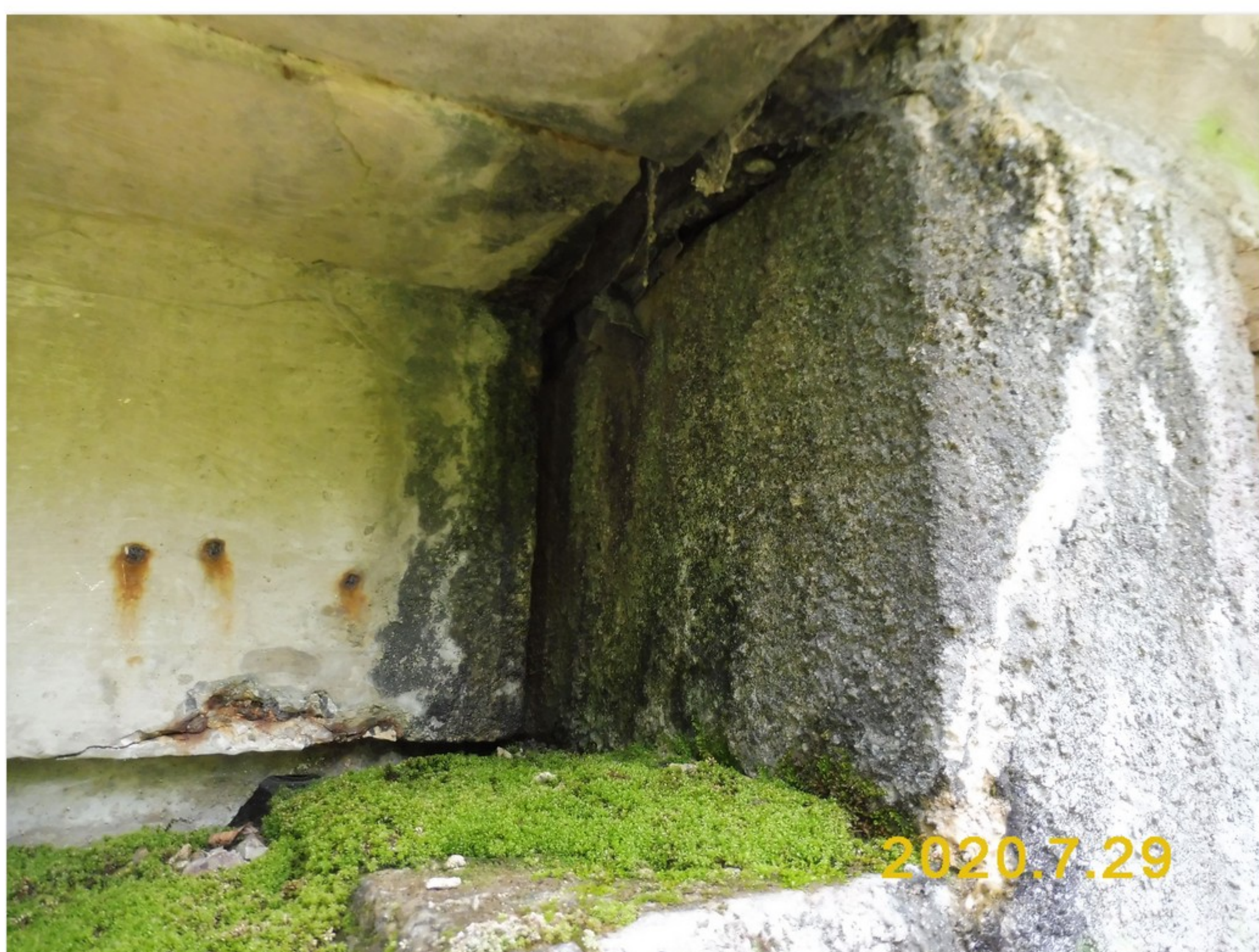
1.2-28 Líc závěrné zídky u levého čela podpěry 2 se stopami dlouhodobého zatékání
