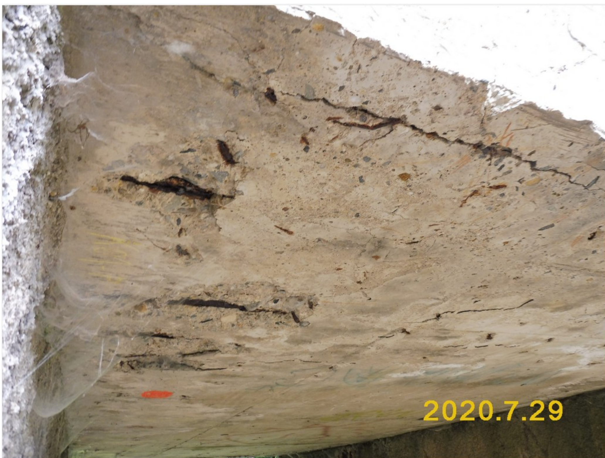
2.1-08 Podhled nosné konstrukce K01 před opěrou 1 - beton odlomený působením korozních zplodin v místě podélné výztuže
