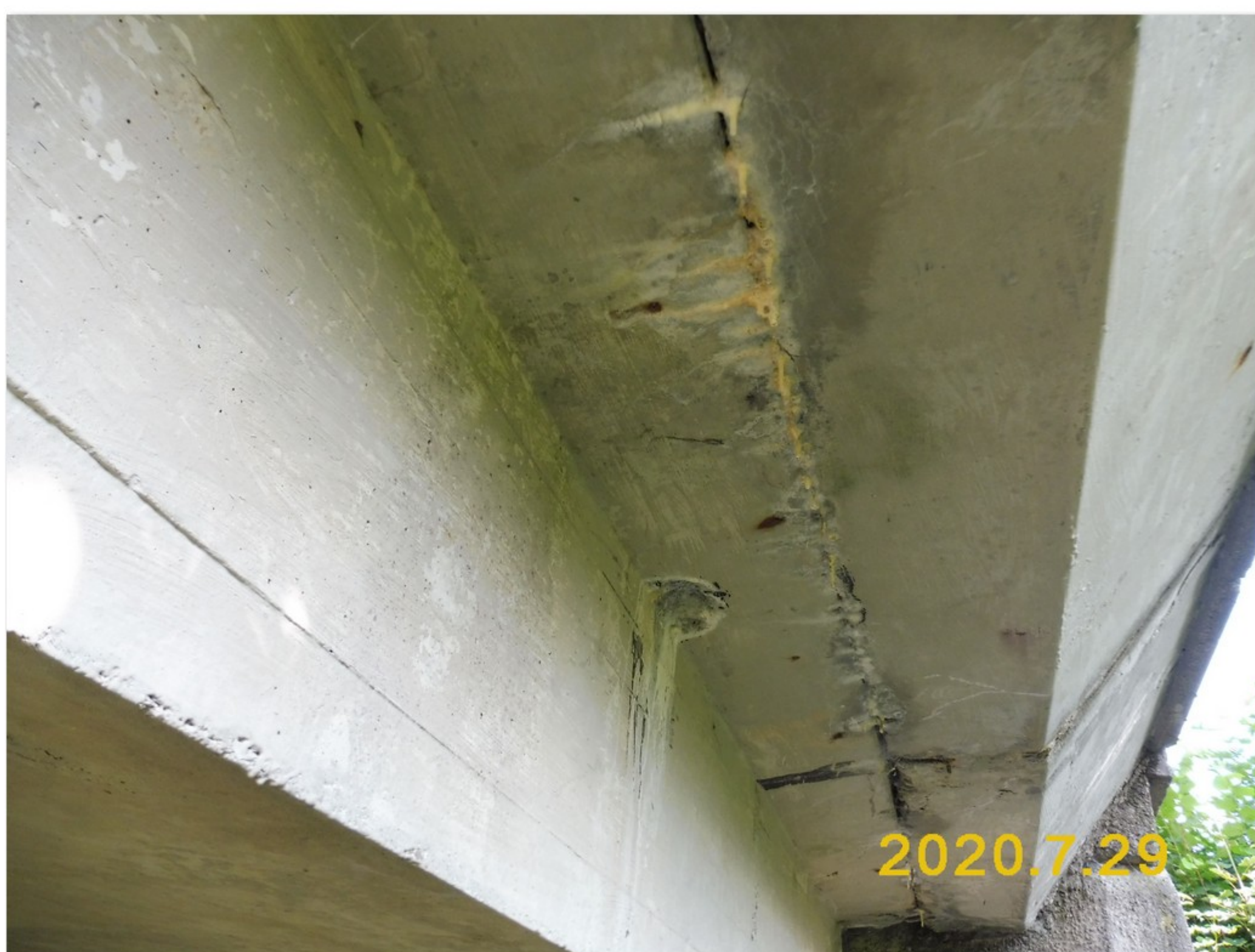
2.1-70 Opakující se poruchy v podélné spáře mezi nosníkem č. 02.2 a římsovou konzolou v oblasti před opěrou 3
