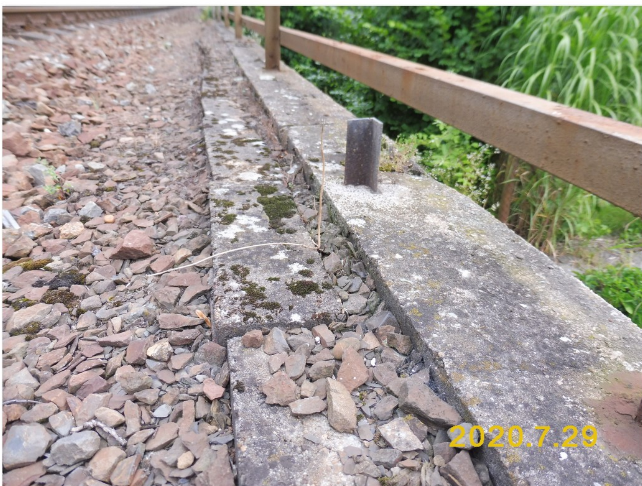
4.2-02 Kabelový žlab podél pravé římsy v 1. poli
