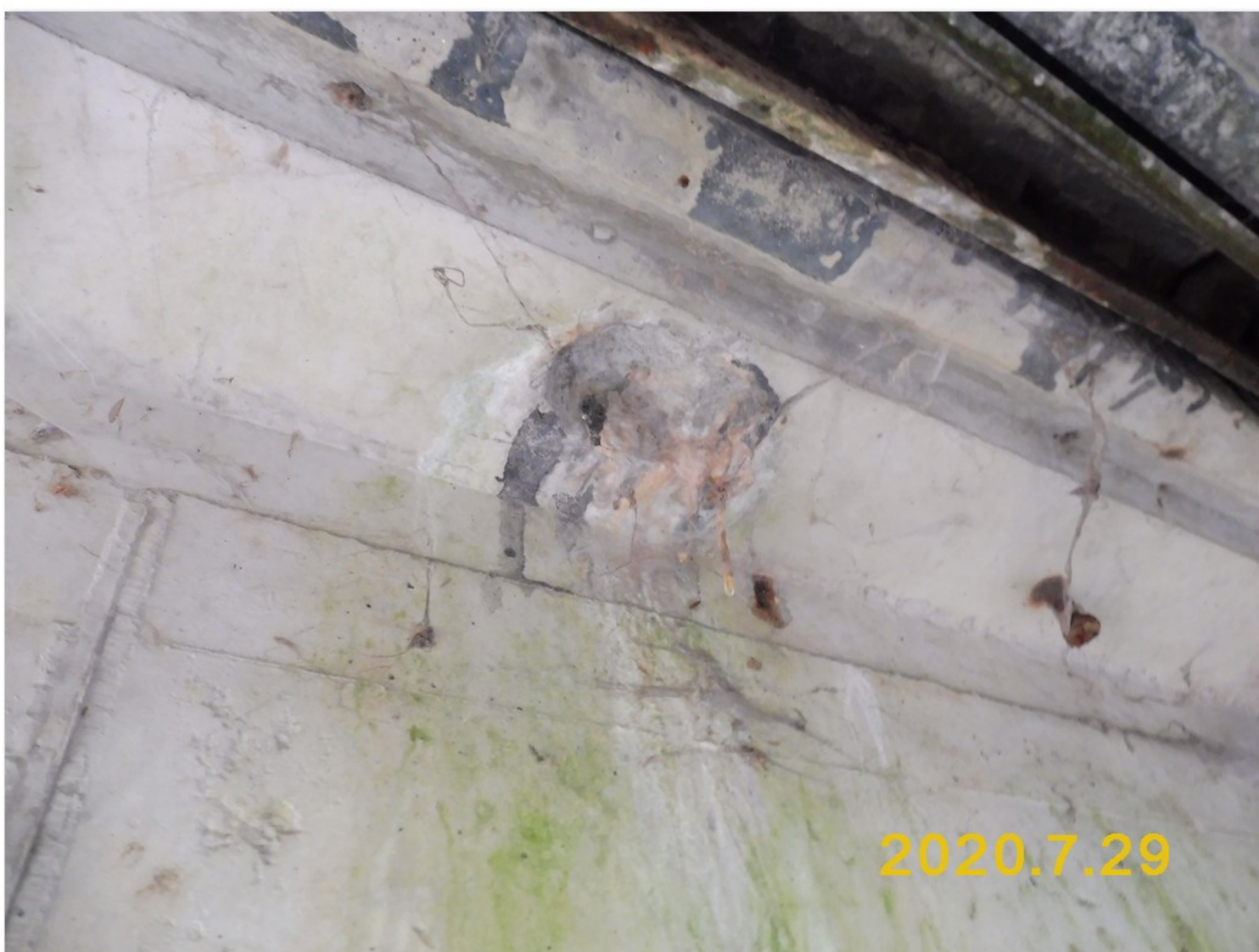
2.1-41 Zatékání přes montážní otvor v pravé horní přírubě nosníku č. 02.1 před opěrou 3
