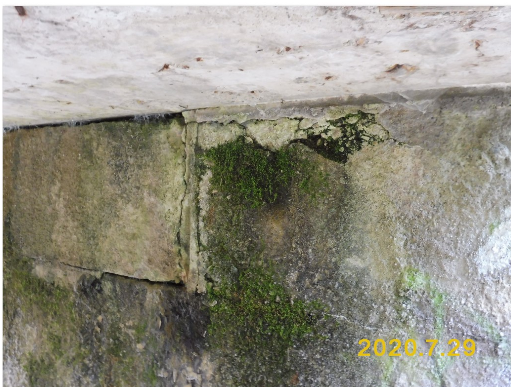
1.2-07 Detail líce opěry 1 - zatékání z úložné spáry - uchycená vegetace - degradace omítky a betonu
