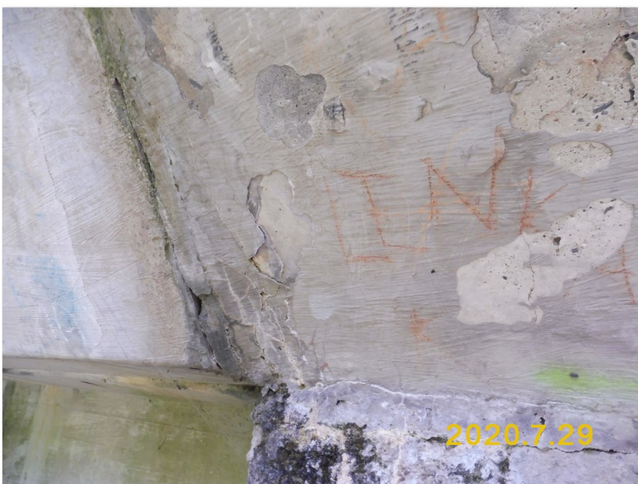
2.1-15 Detail uložení nosné konstrukce K01 na pilíři 2 vlevo - na boku trhliny se stopami zatékání
