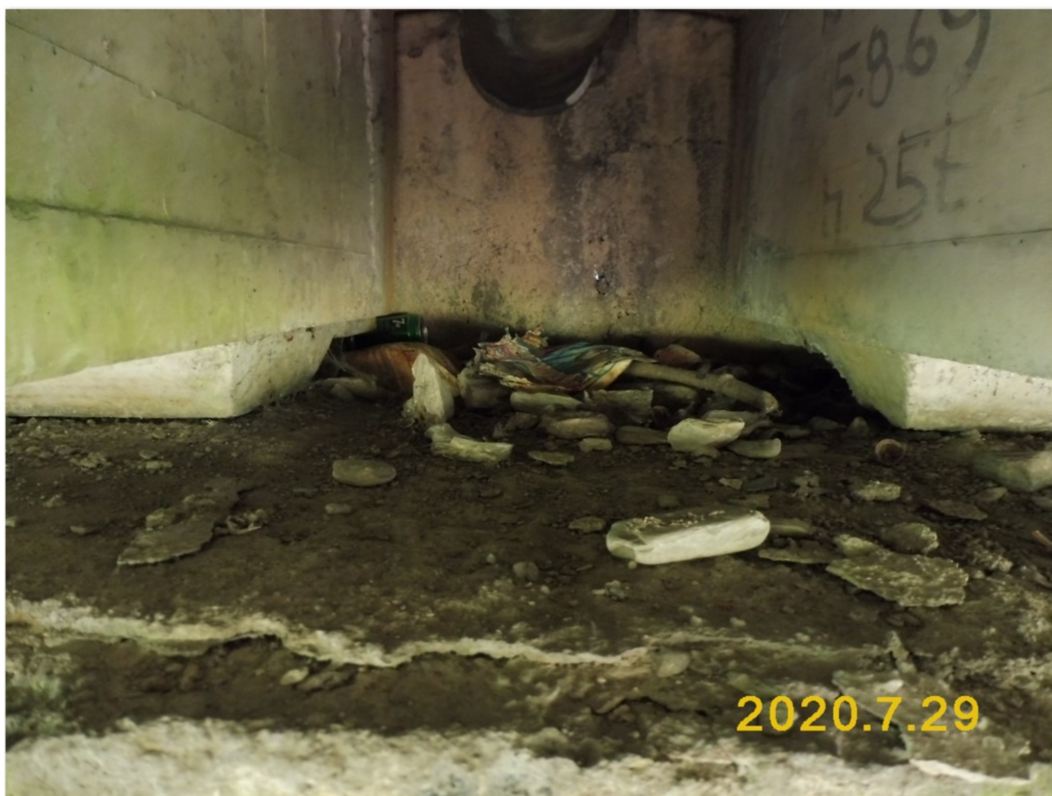
1.2-60 Úložný práh opěry 3 znečištěný odpadným betonem a odpadky
