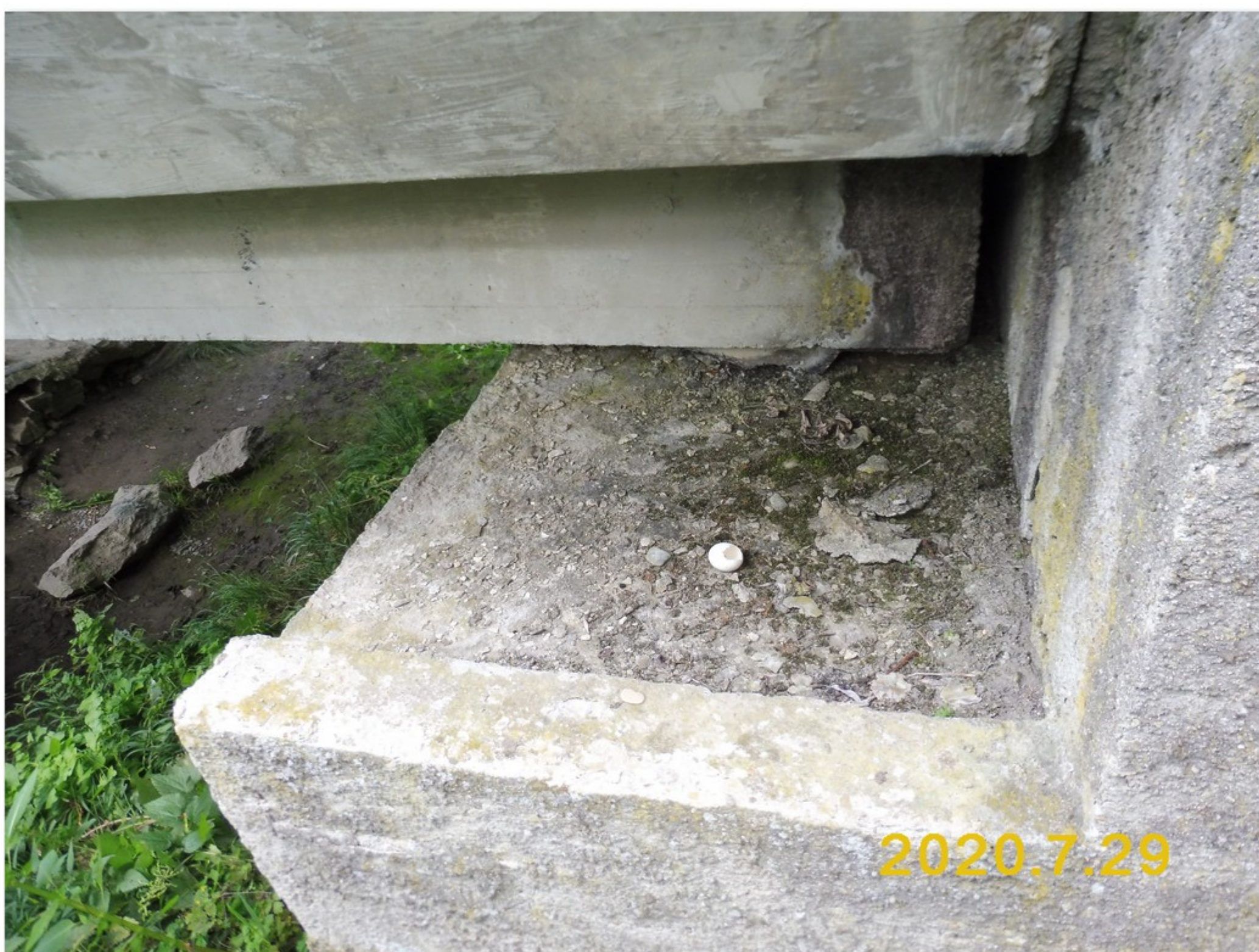
1.2-63 Úložný práh u pravého čela opěry 3 - uchycená vegetace - znečištění odpadaným betonem a omítkou
