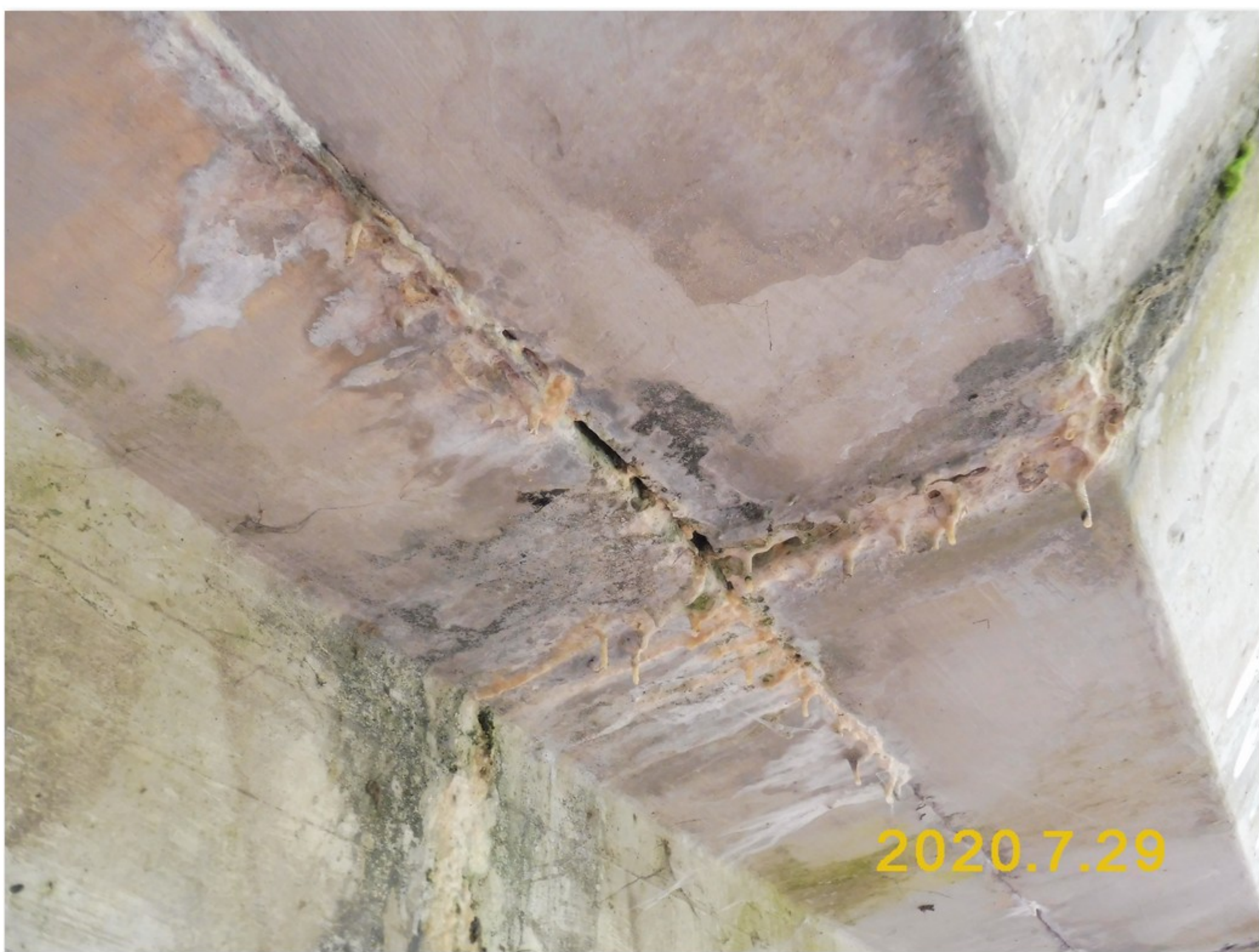
2.1-32 Podhled levé římsové konzoly - zatékání ve spárách - inkrustace - krápníky
