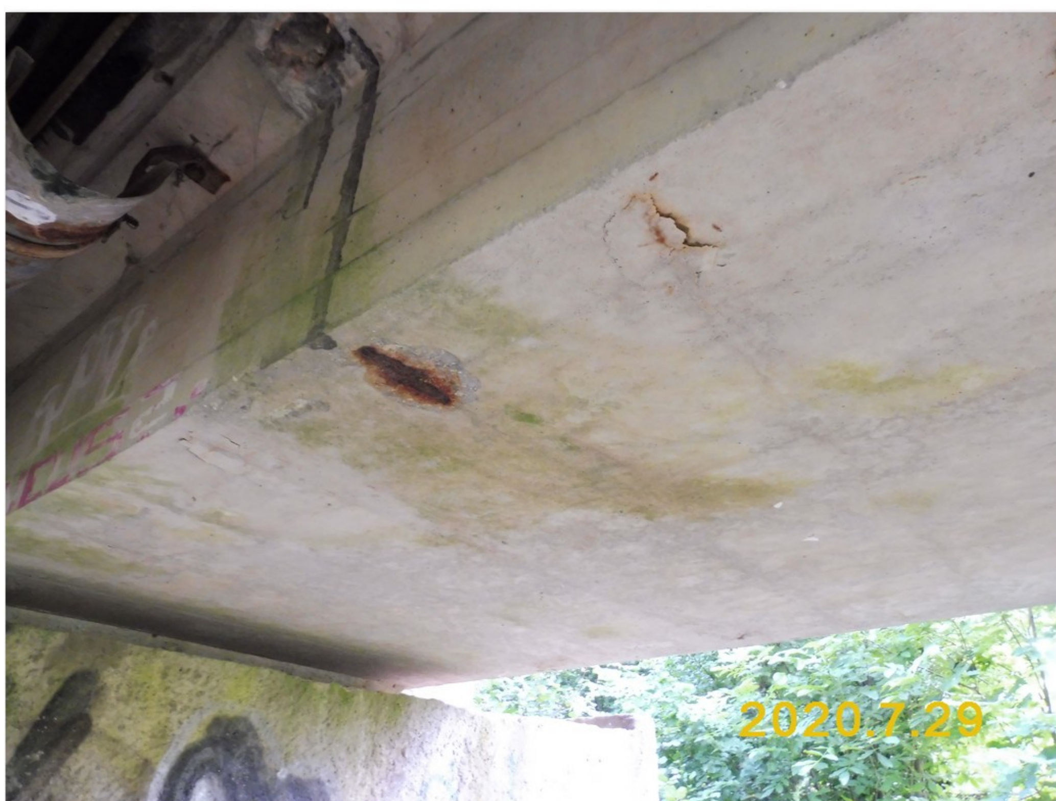
2.1-56 Dno nosníku č. 02.2 před opěrou 3 - beton odlomený působením korozních zplodin výztuže
