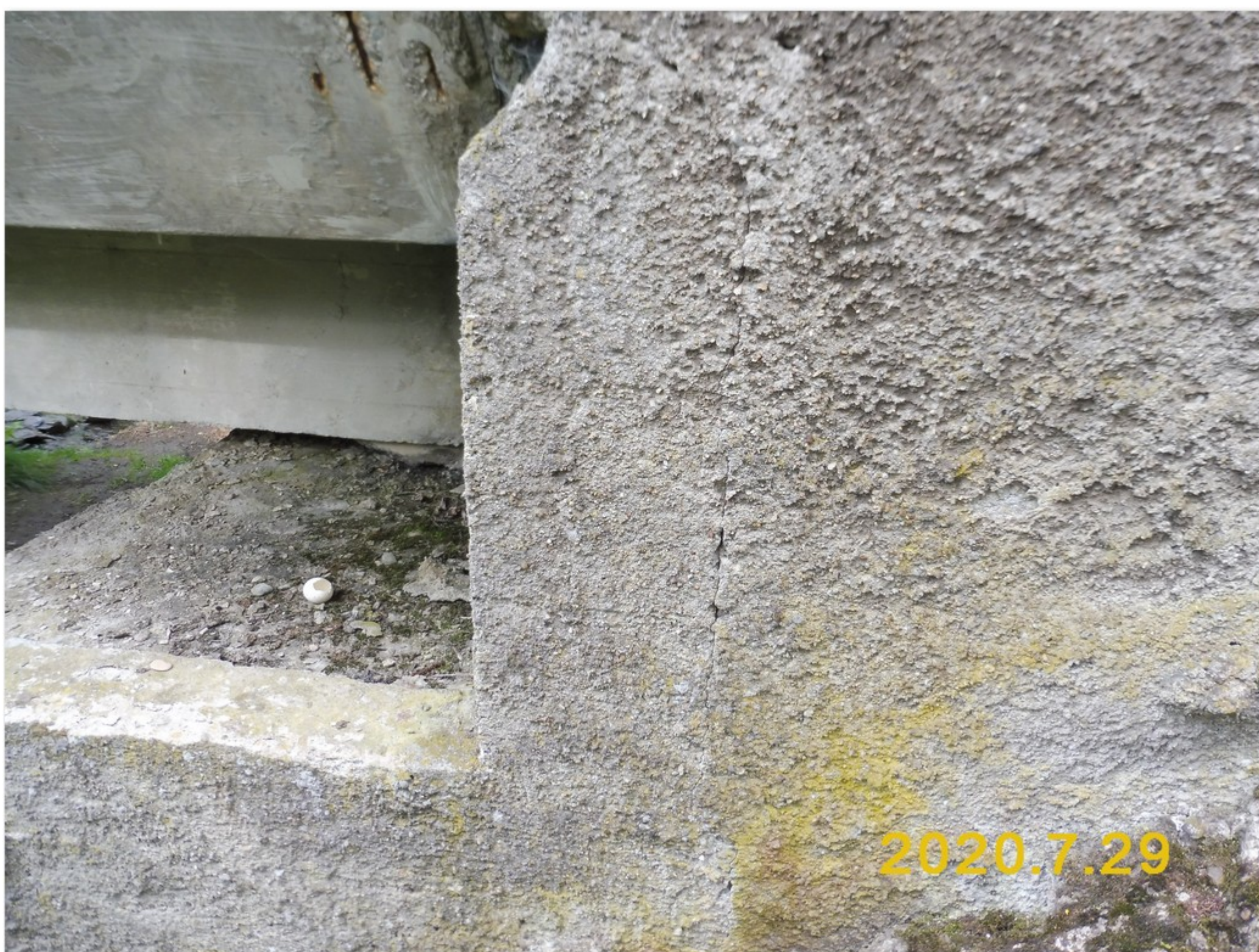
1.2-62 Trhlina mezi pravým křídlem a závěrnou zídou opěry 3
