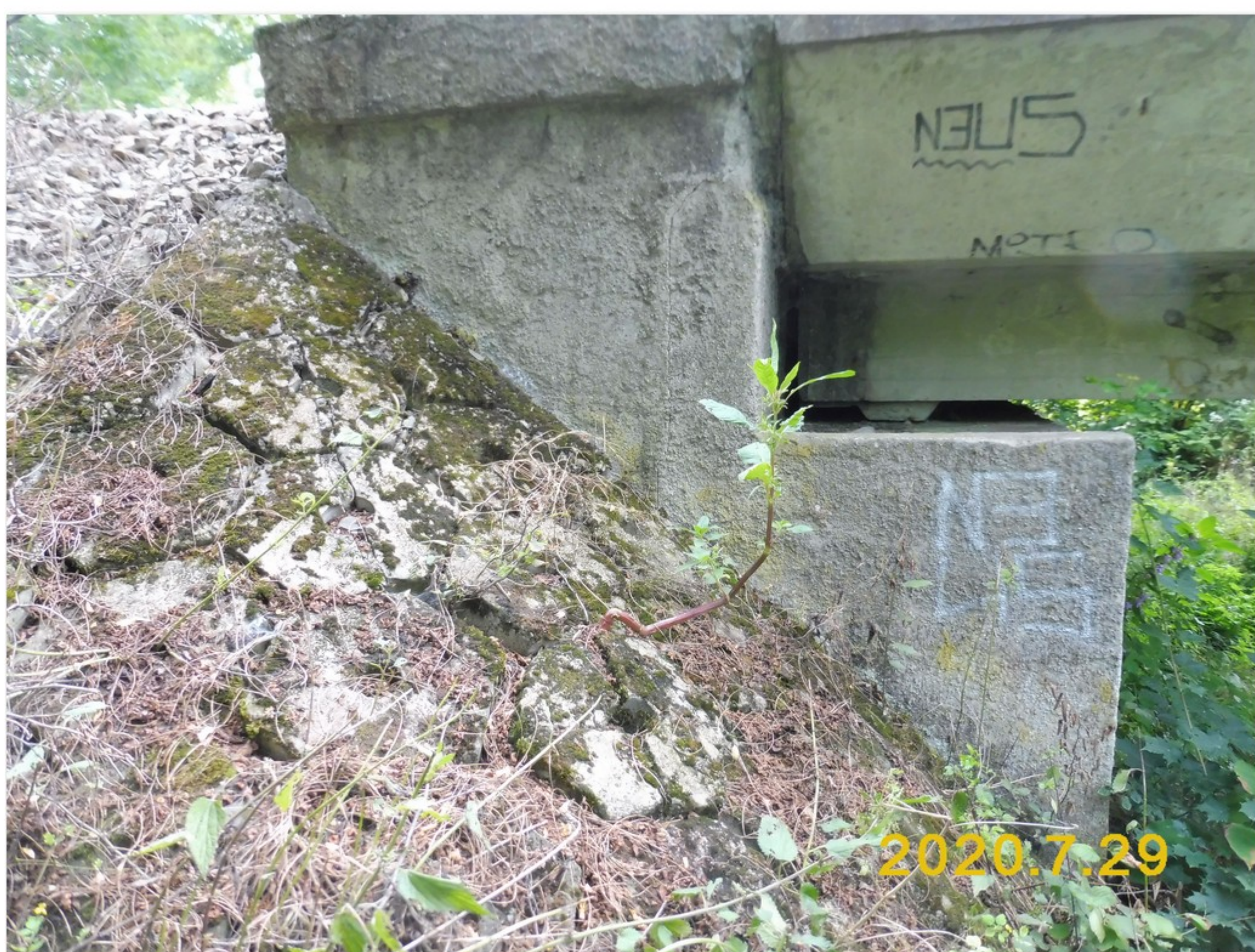
1.2-51 Levé čelo opěry 3 s navazujícím křídlem
