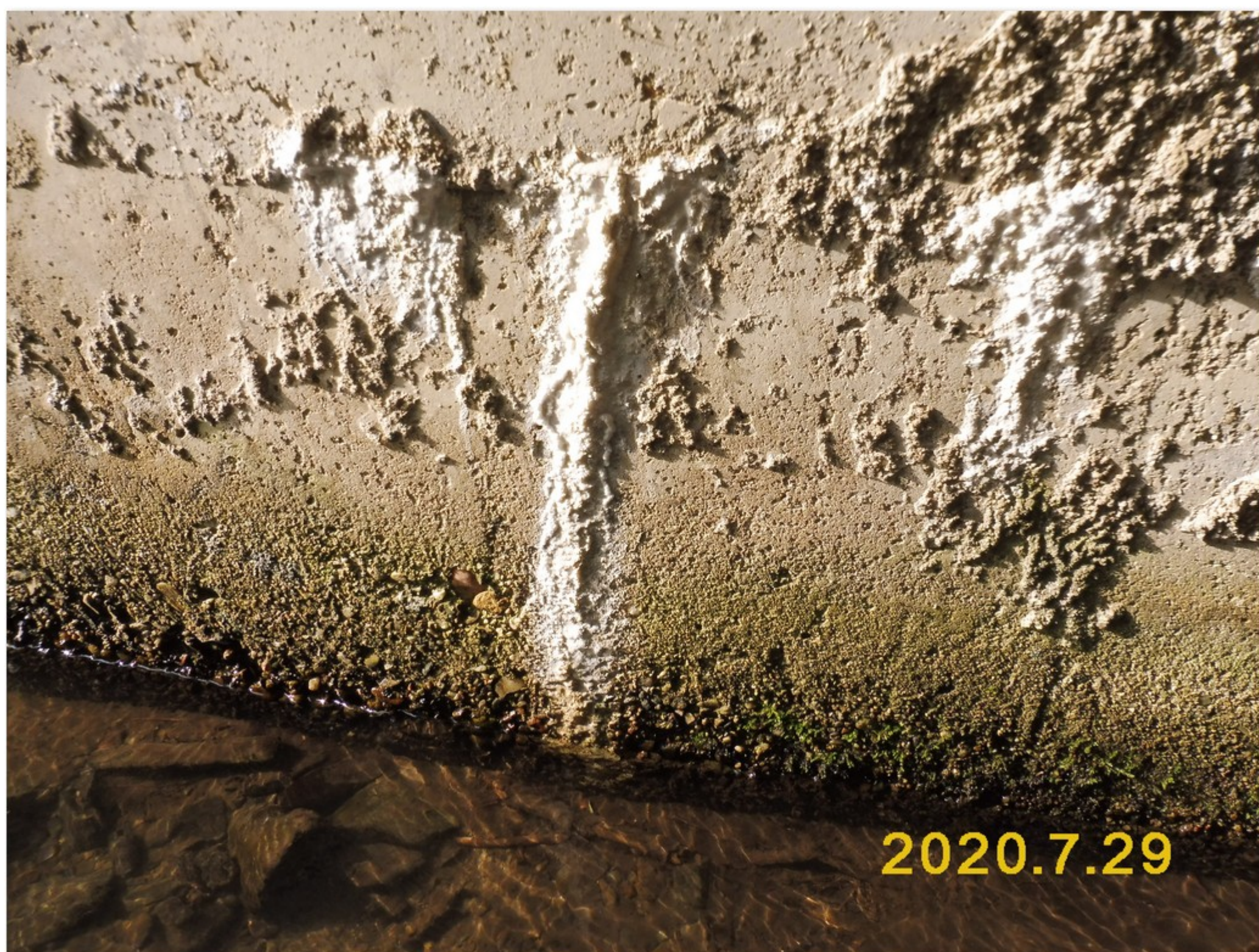
1.2-43 Trhliny s průsaky a inkrustacemi v líci podpěry 2 ve 2. poli
