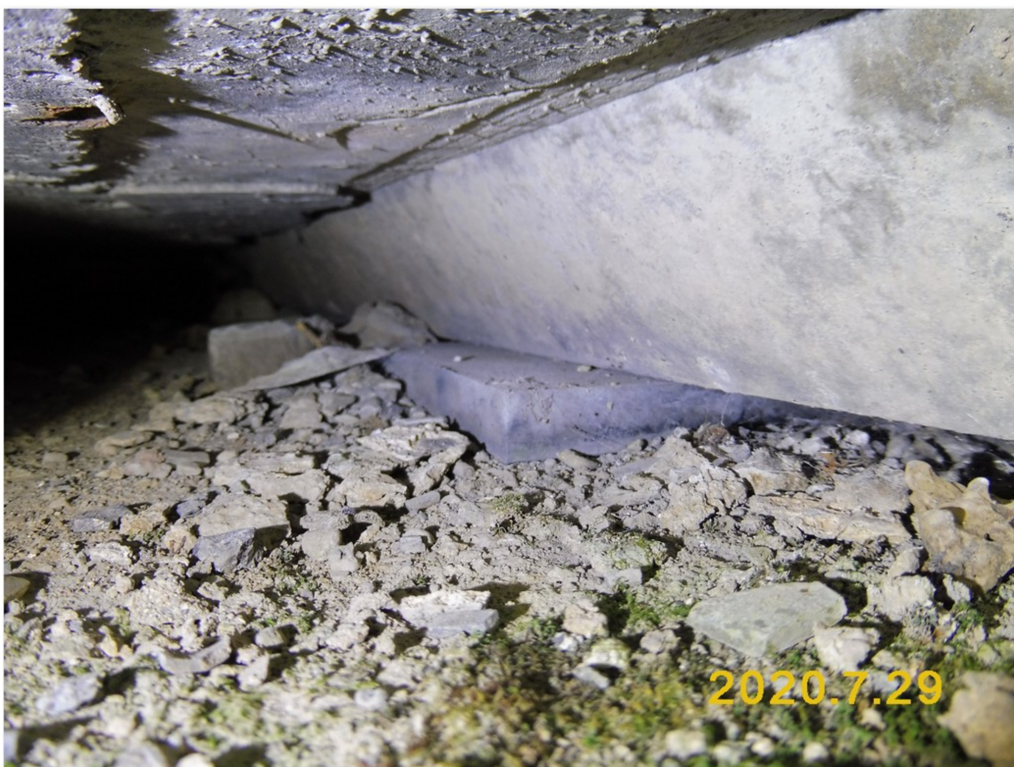
2.2-02 Uložení nosníku č. 02.1 na opěře 3 - pohled od závěrné zídky
