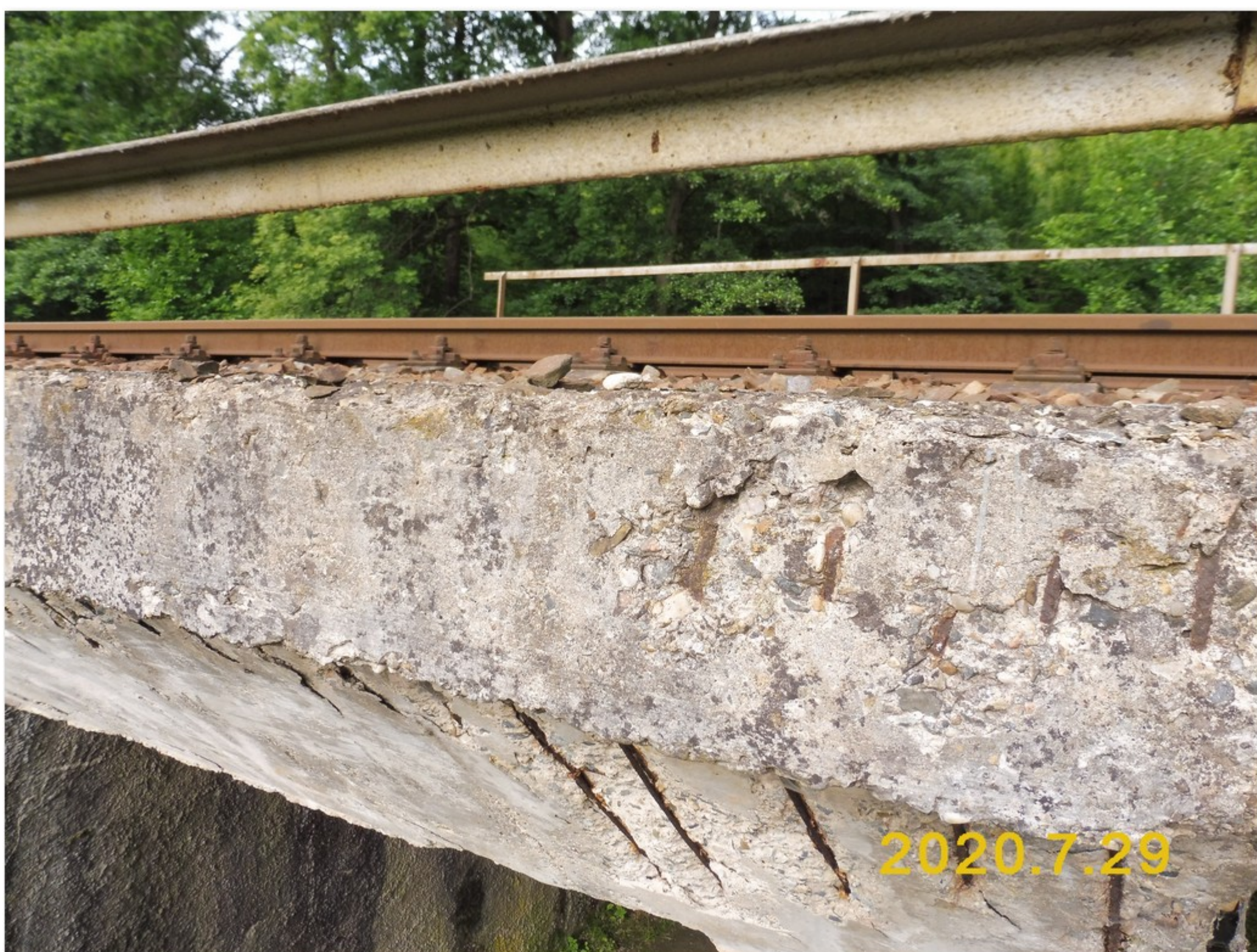
3.2-33 Pohledová plocha pravé římsy v 1. poli - obnažená korodující výztuž - beton odlomený působením korozních zplodin
