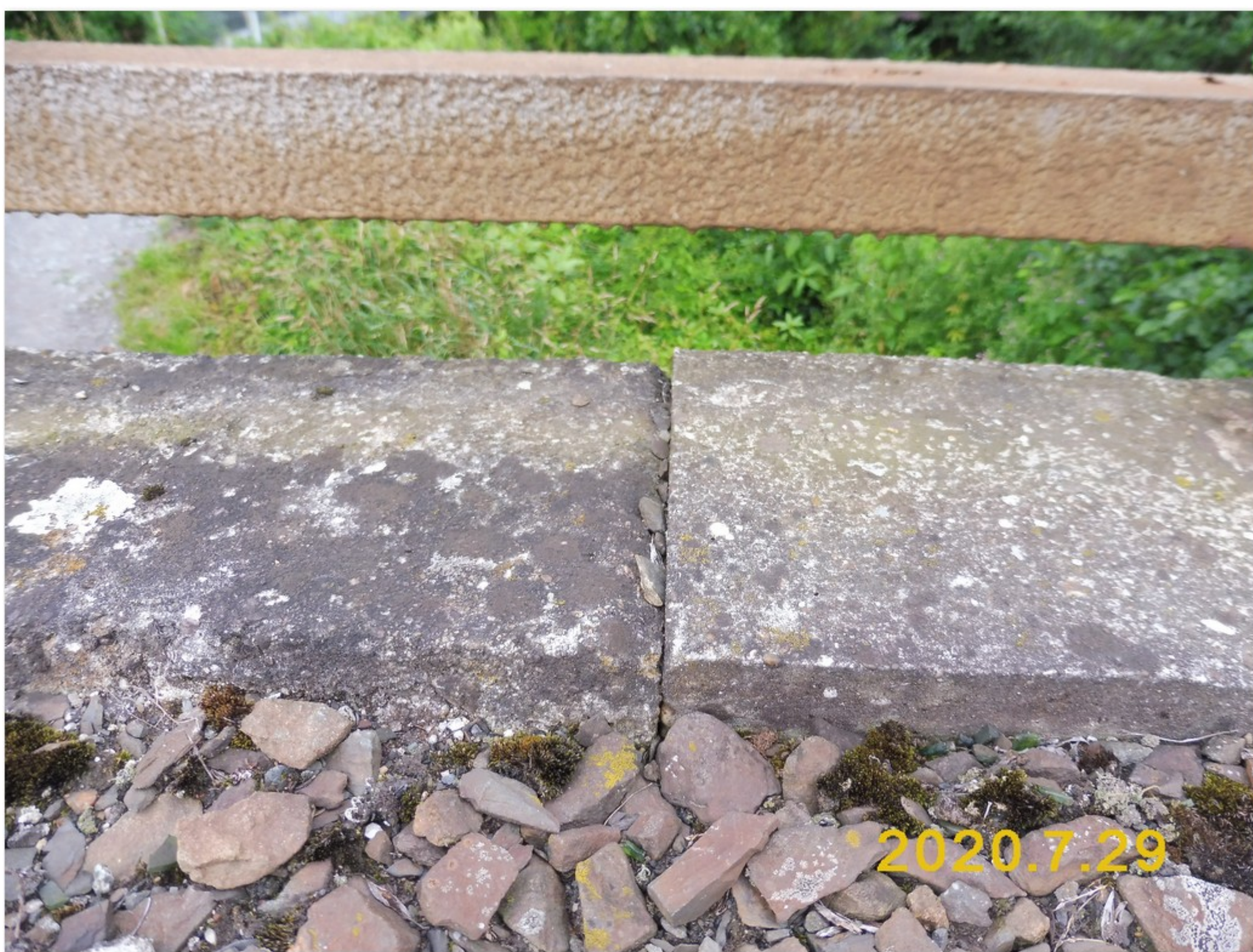
3.2-07 Dilatační spára levé římsy nad podpěrou 2
