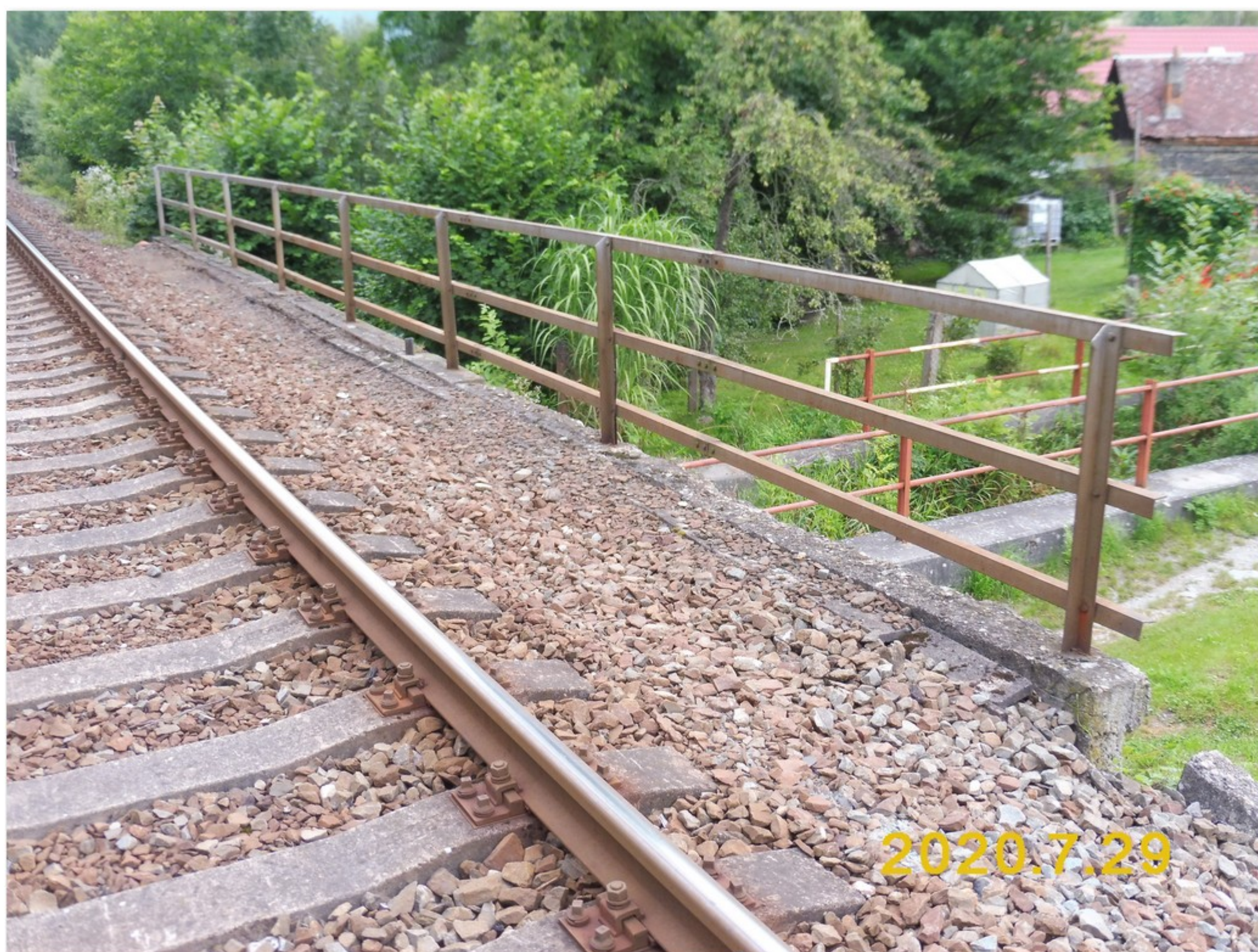
3.2-21 Pravá římsa se zábradlím
