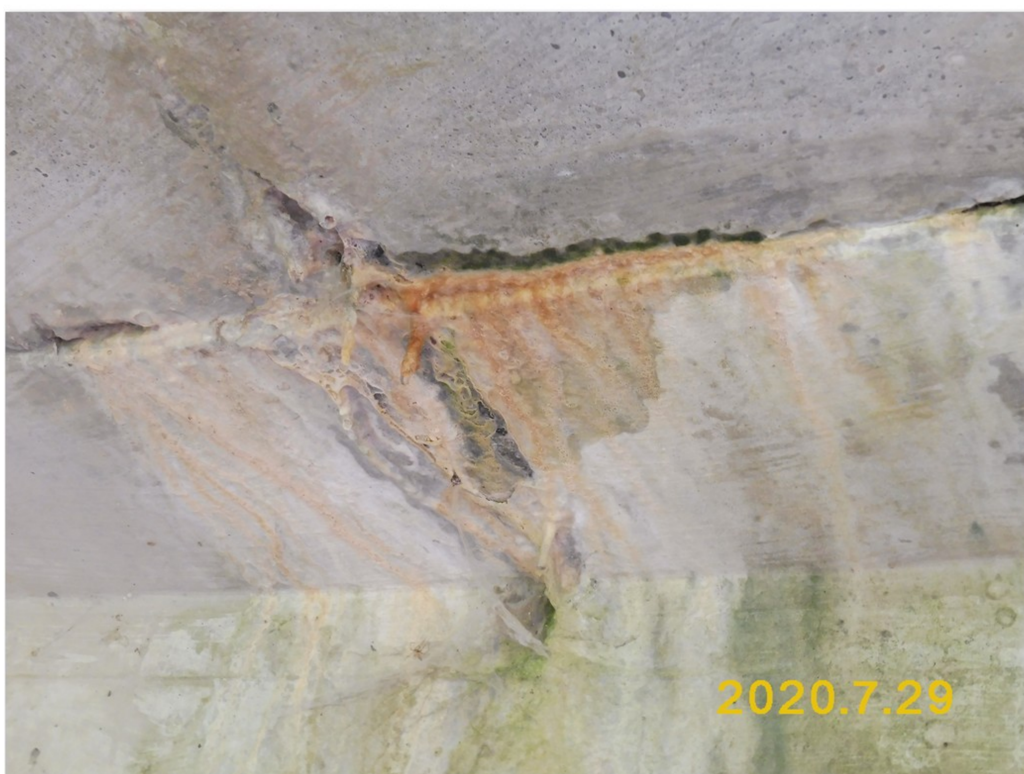
2.1-25 Podélná spára mezi nosníkem č. 02.1 a římsovou konzolou - zatékání - výluhy - krápníky
