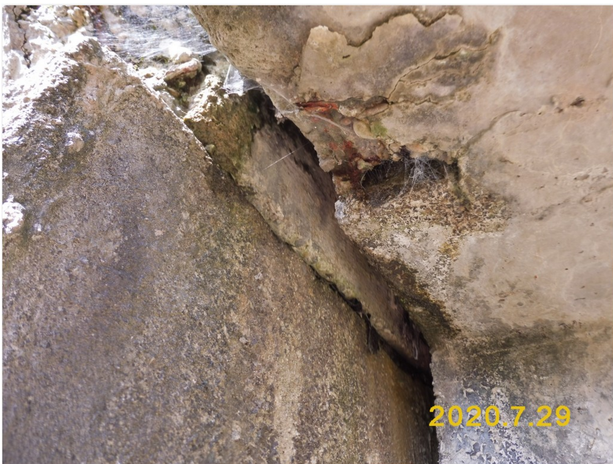
2.1-61 Podhled pravé římsové konzoly na začátku nosníku č. 02.2 nad pilířem 2 - kolem příčné spáry degradace betonu
