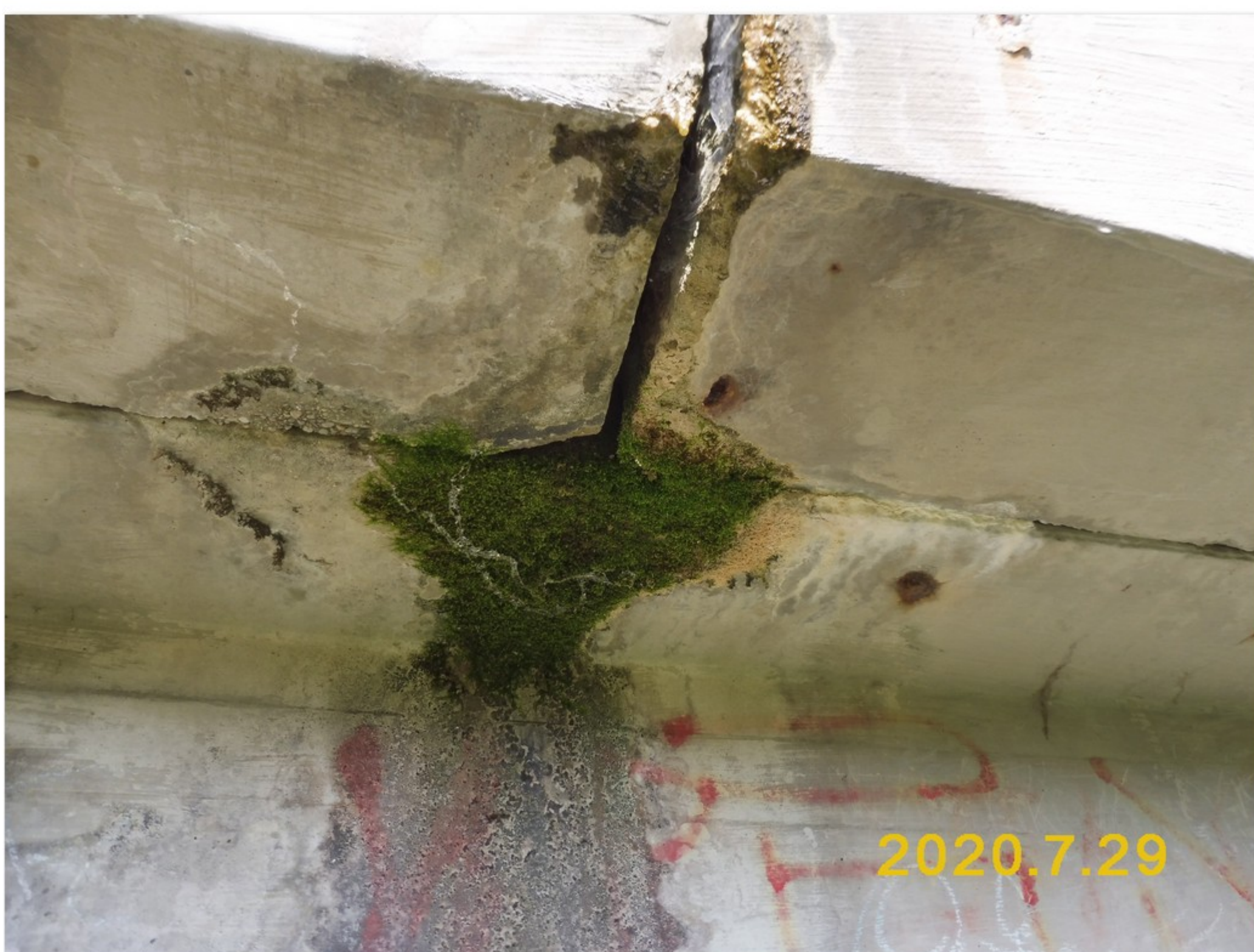
2.1-66 Podhled pravé římsové konzoly v místě její příčné dilatační spáry - zatékání - inkrustace - uchycená vegetace
