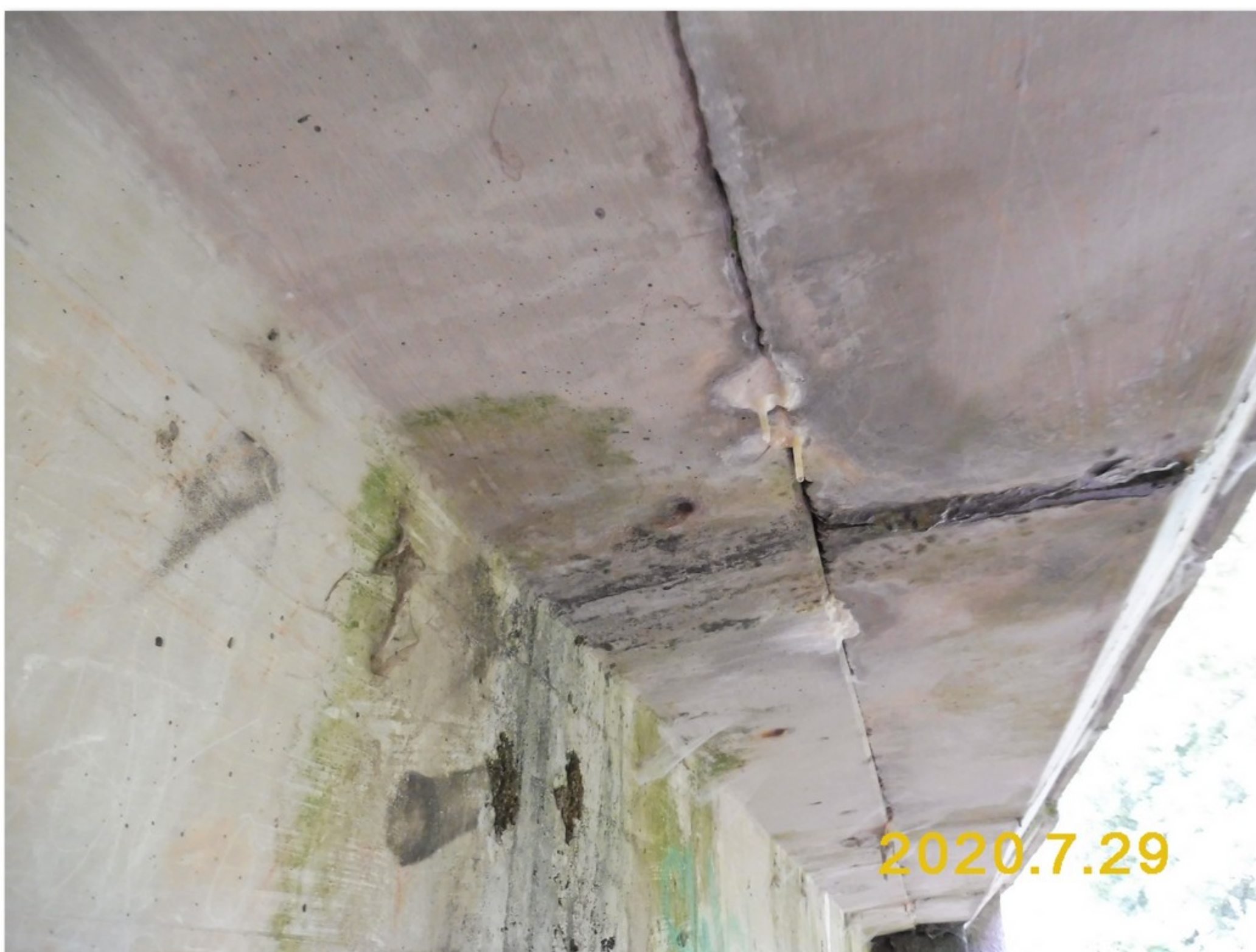
2.1-30 Opakující se poruchy na styku nosníku č. 02.1 a římsové konzoly
