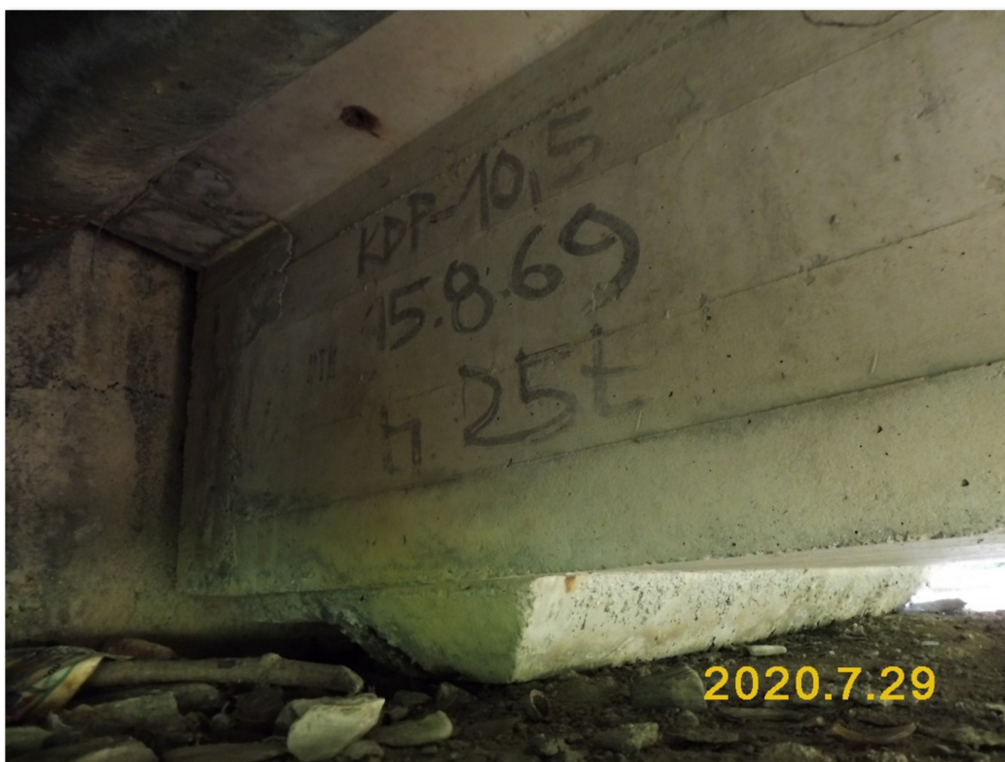
2.1-57 Ukončení nosníku č. 02.2 nad opěrou 3 vlevo
