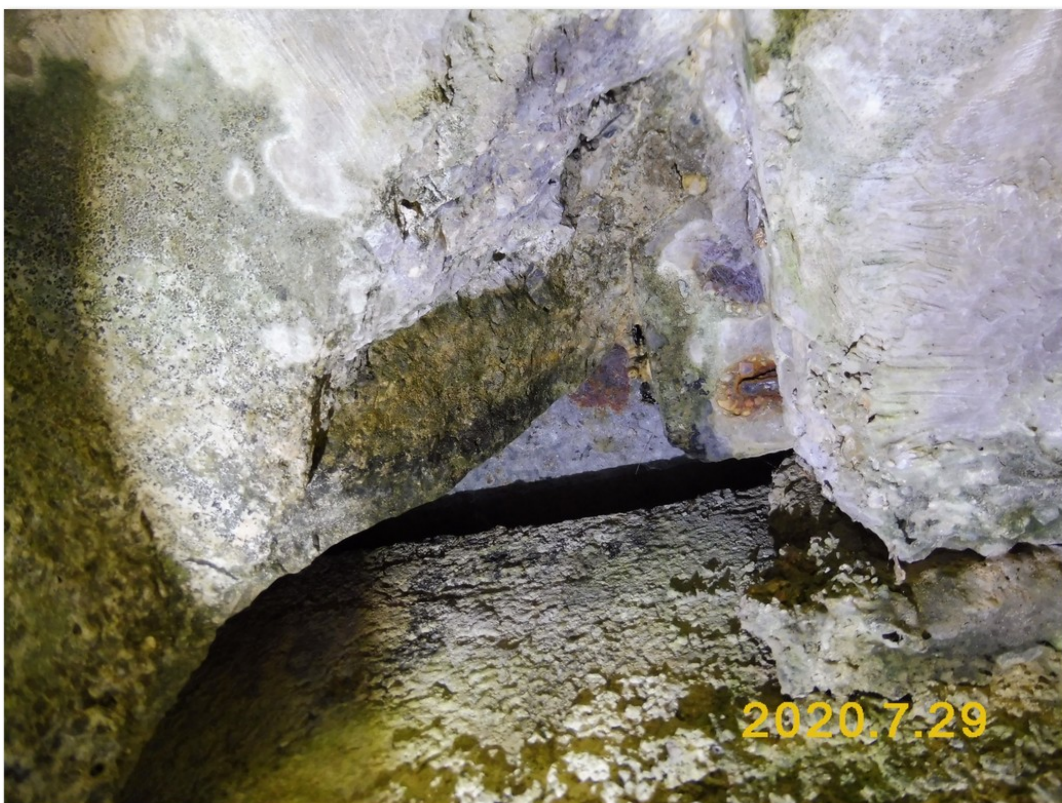
2.1-75 Podhled pravé horní příruby na konci nosníku č. 02.2 nad opěrou 3 - odlomený beton v místě podélné spáry s římsovou konzolou
