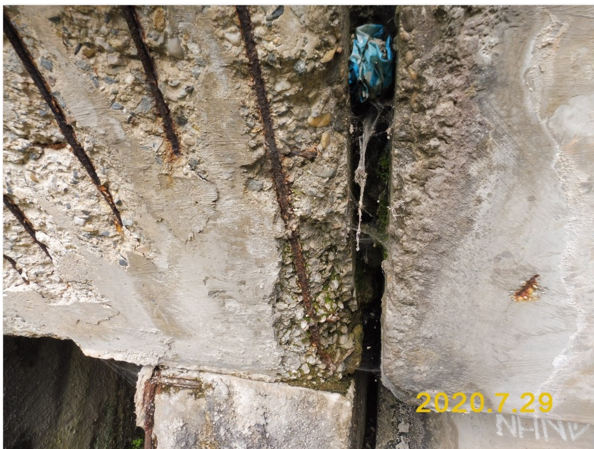
2.1-12 Degradace betonu v čele nosné konstrukce K01 nad pilířem 2 vlevo
