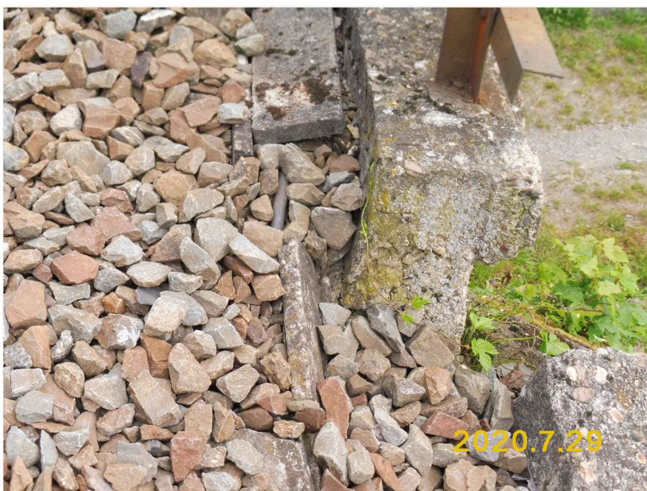
3.2-22 Začátek pravé římsy před opěrou 1 - poškozený kabelový žlab
