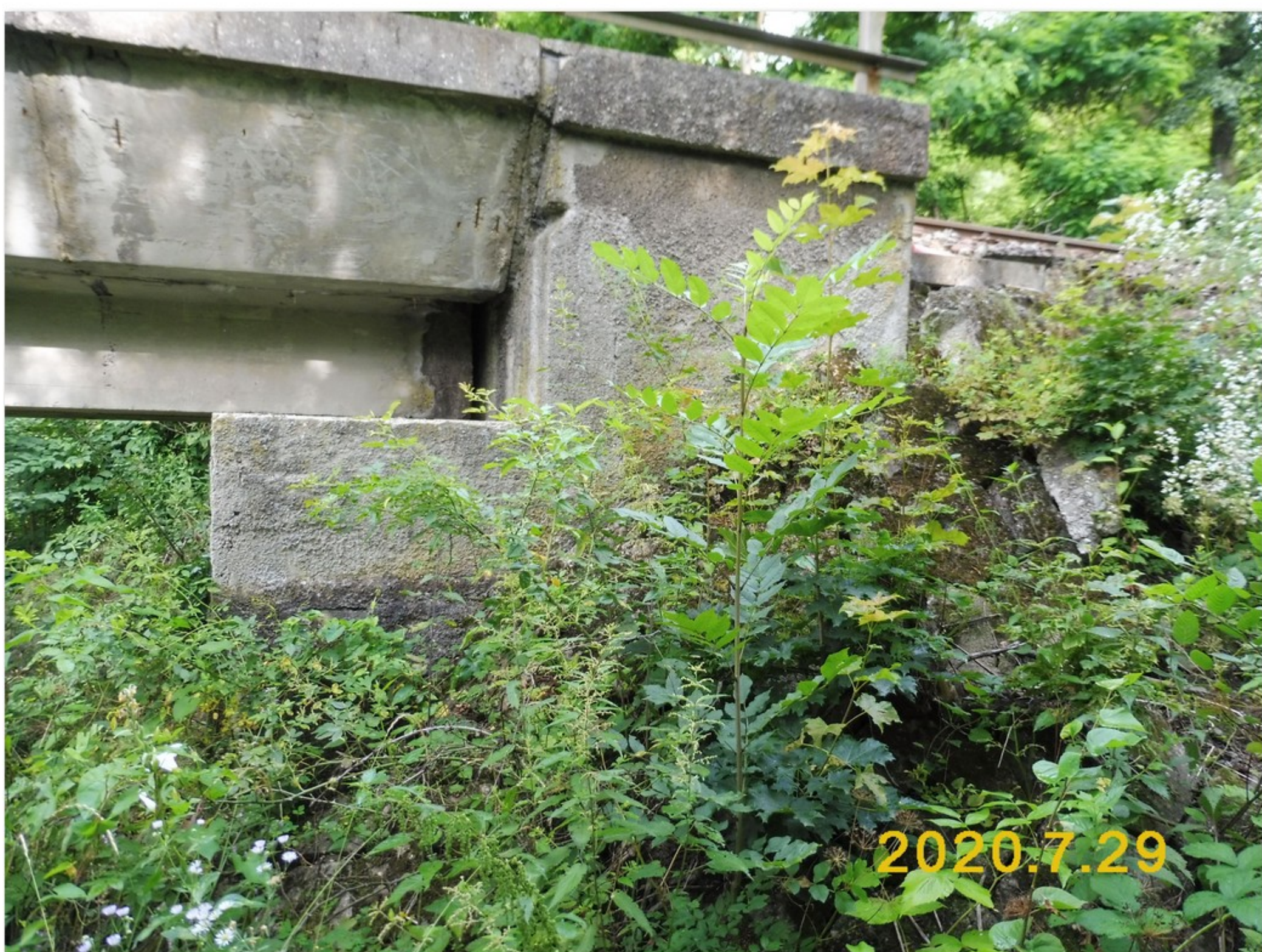
1.2-53 Pravé čelo opěry 3 s navazujícím křídlem - před odstraněním vegetace ze svahového kuželu prohlídkářem
