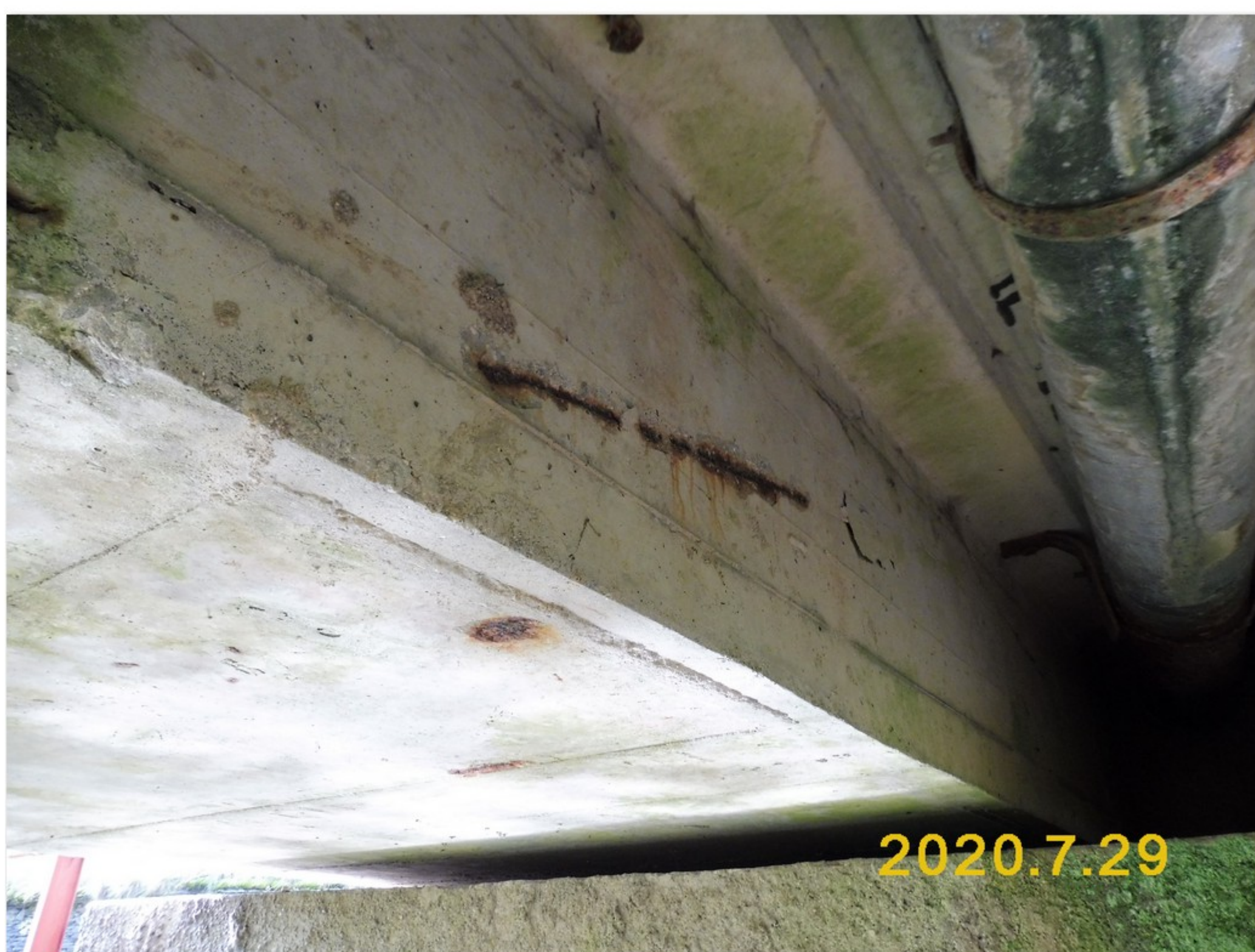
2.1-52 Levá stěna nosníku č. 02.2 před pilířem 2 - beton odlomený působením korozních zplodin výztuže
