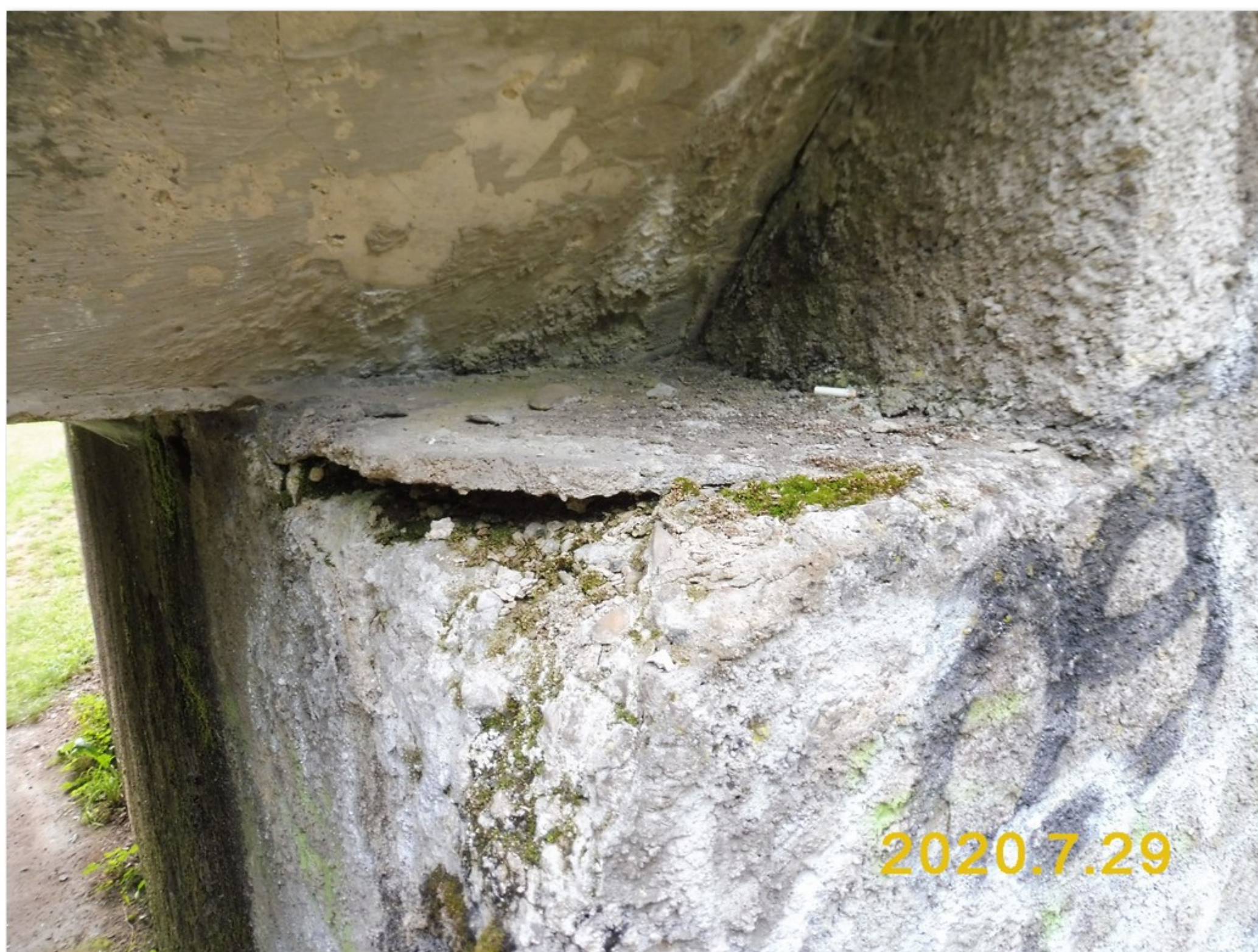
1.2-06 Úložný práh opěry 1 u levého čela - rozpad betonu - uchycená vegetace
