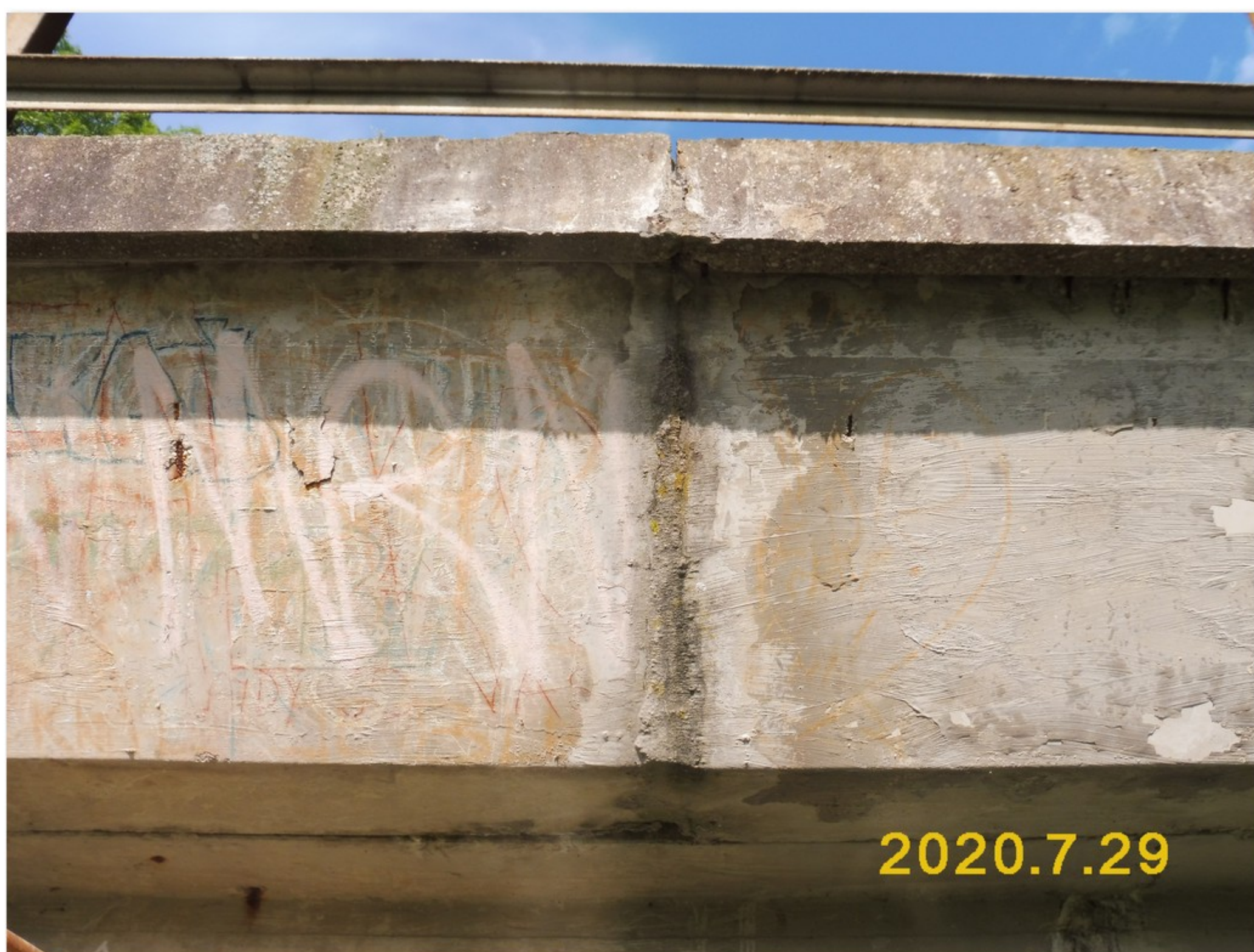
2.1-63 Příčná spára v pravé římsové konzole - stopy zatékání - uchycená vegetace
