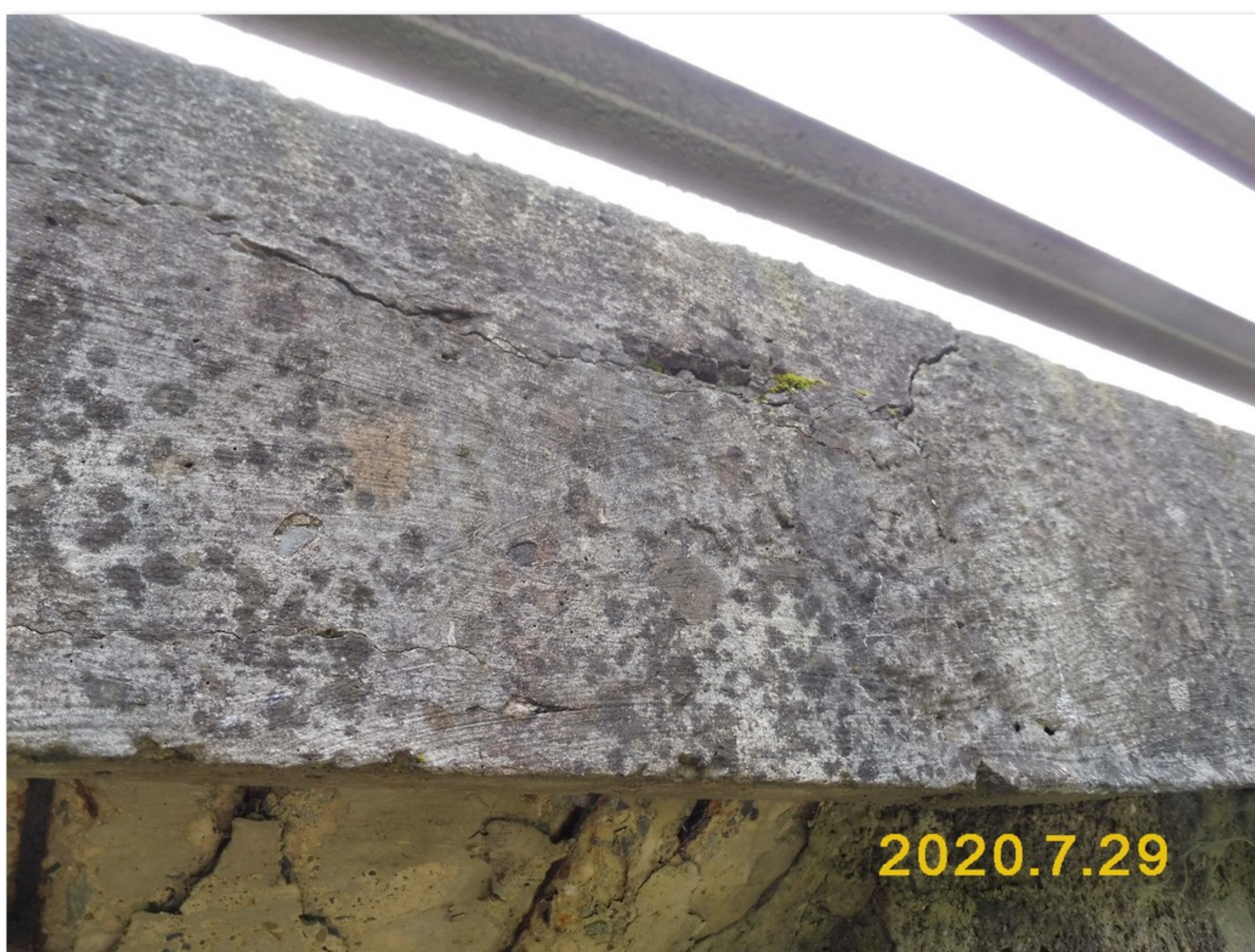
3.2-12 Pohledová plocha levé římsy nad opěrou 1 rozrušená trhlinami
