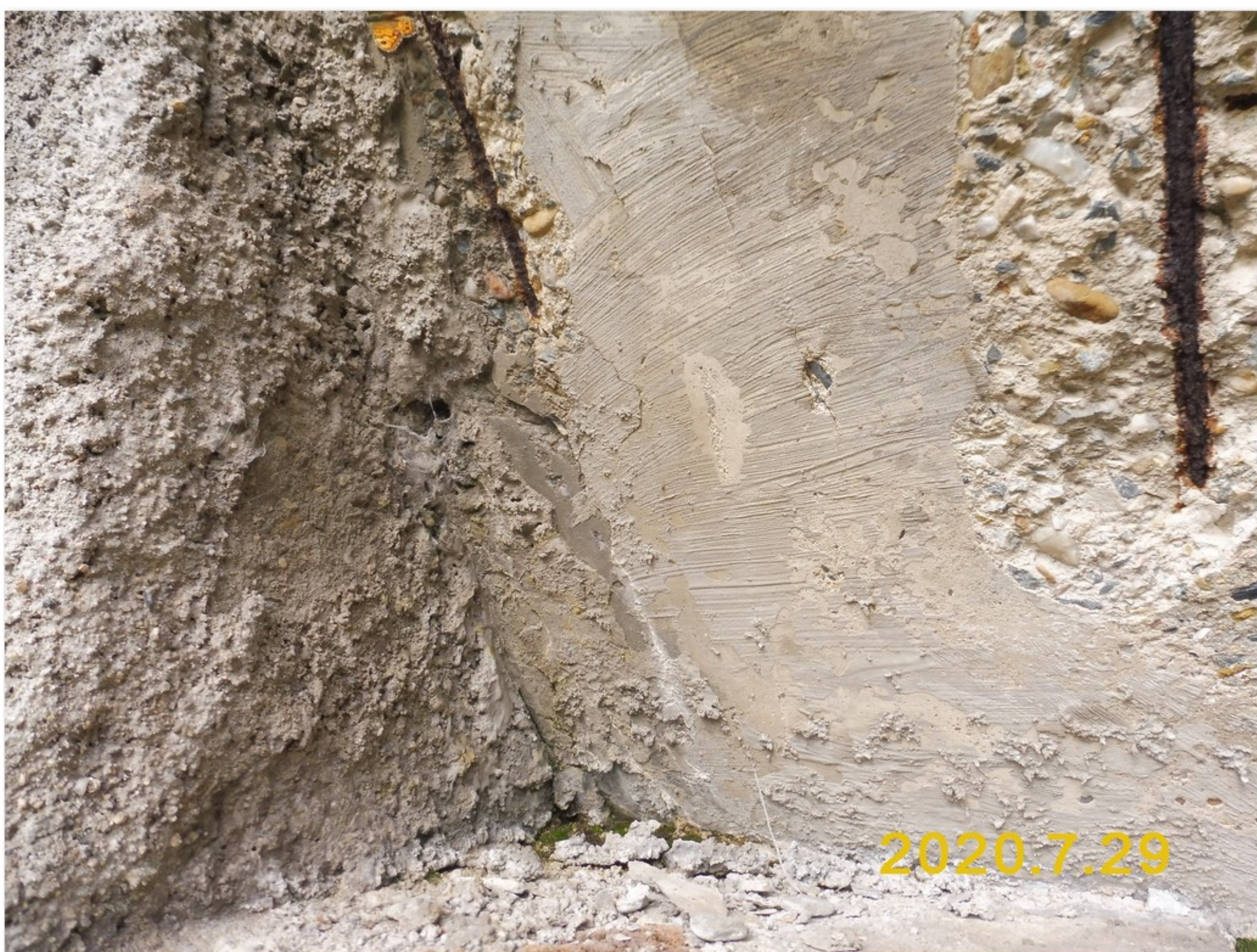
2.1-16 Detail uložení nosné konstrukce K01 na opěře 1 vpravo - na boku trhliny se stopami zatékání a výluhy
