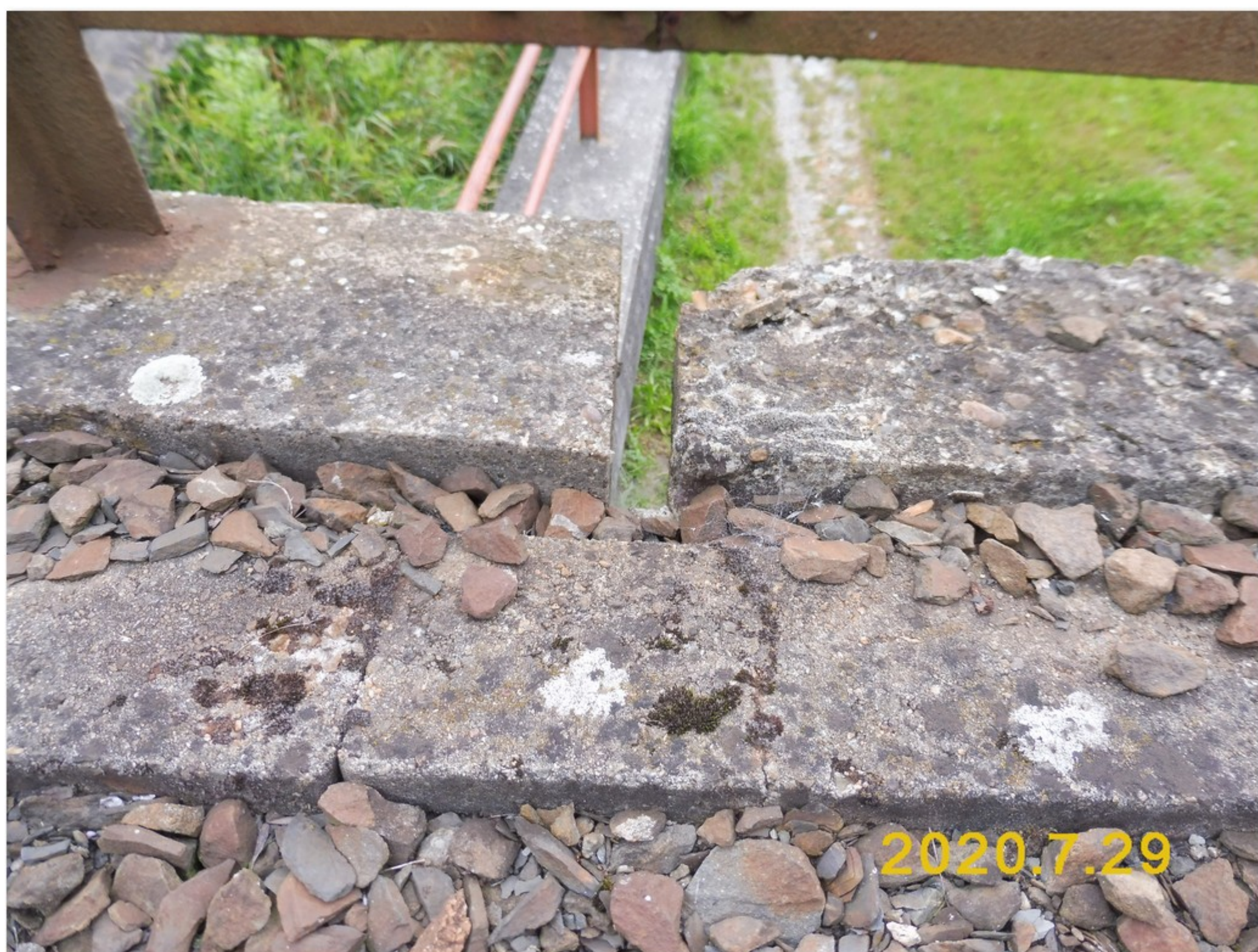
3.2-25 Dilatační spára pravé římsy nad podpěrou 2
