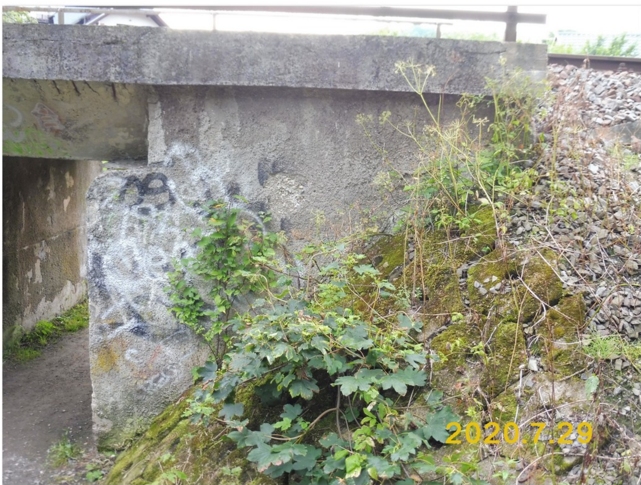
1.2-01 Levé čelo opěry 1 s navazujícím křídlem
