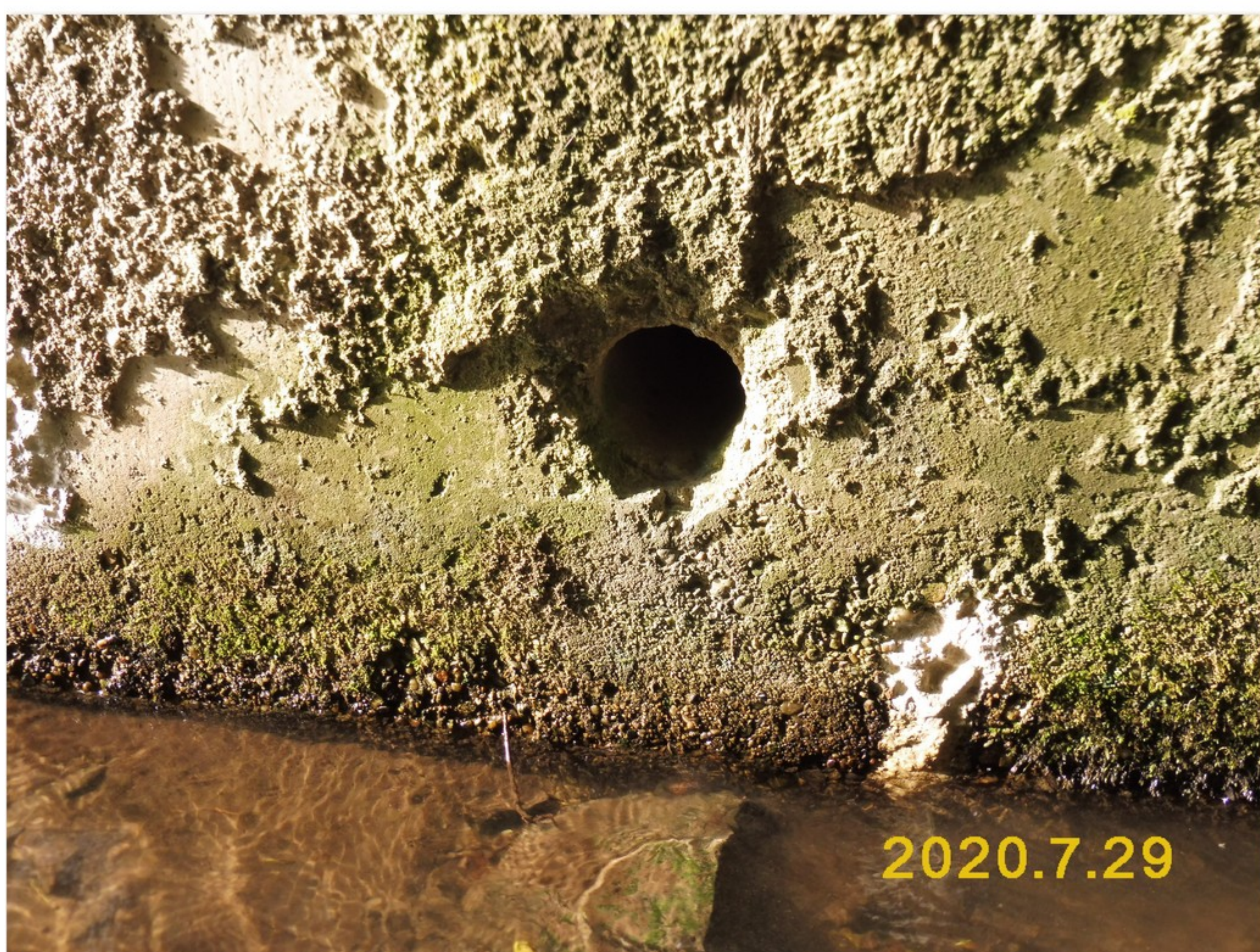
1.2-42 Odvodňovací otvor v patě podpěry 2 - líc podpěry ve 2. poli
