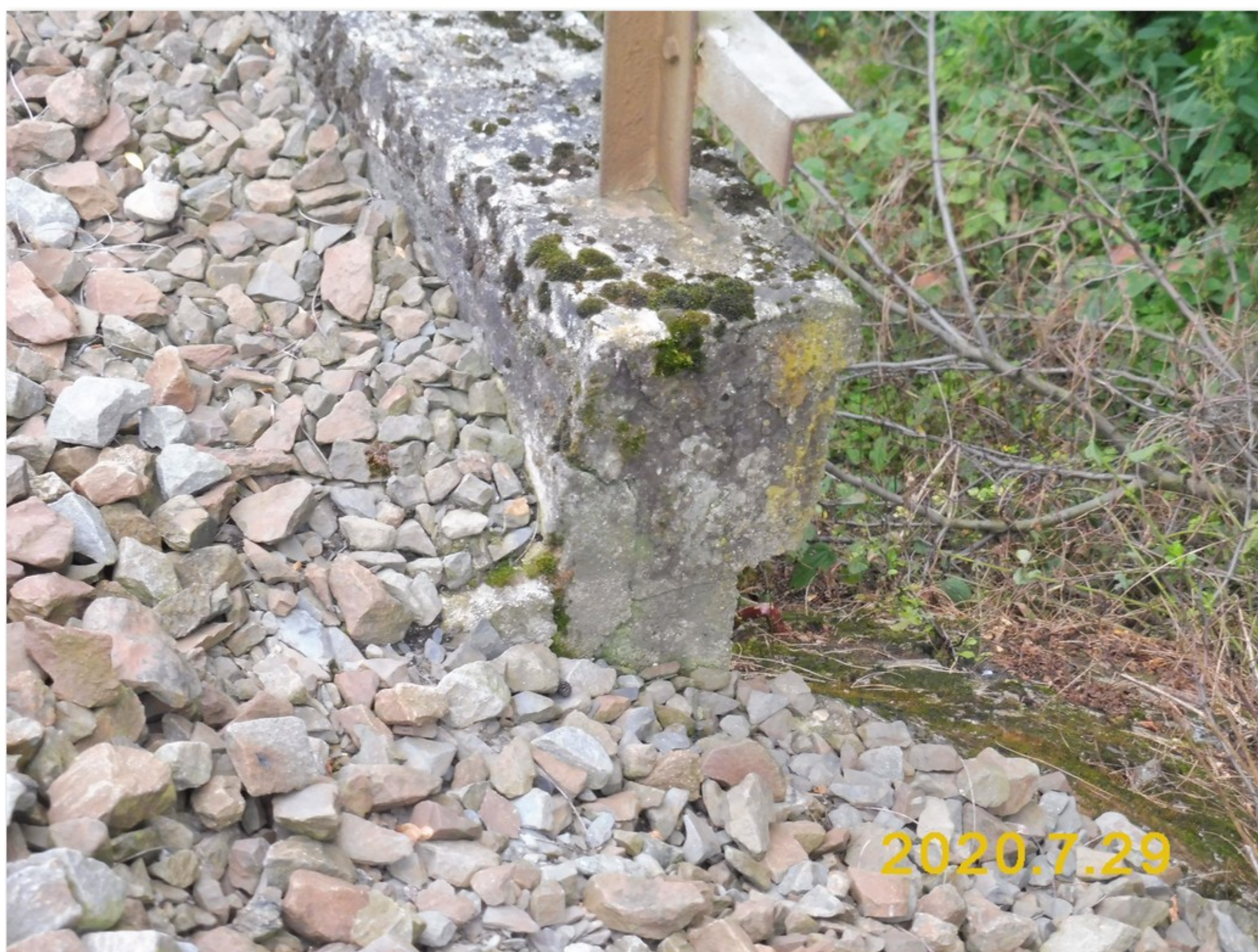
3.2-11 Konec levé římsy za opěrou 3
